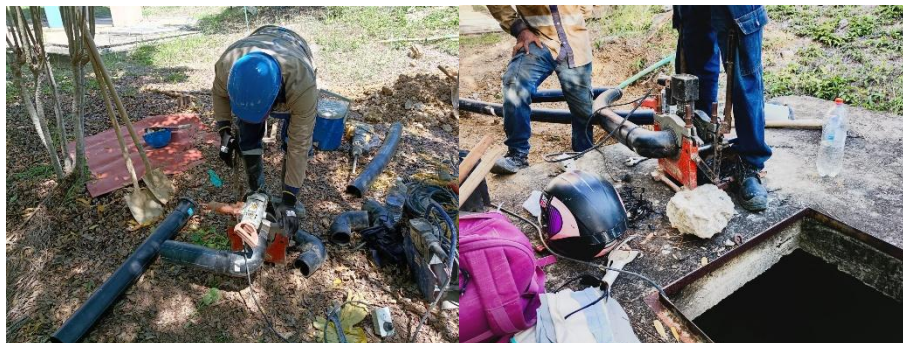
Fabricación de bypass
