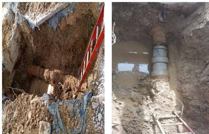
Excavación del tramo afectado
