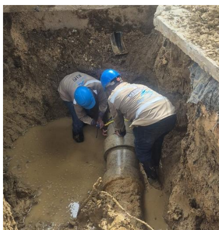
Toma de medidas y cuantificación de materiales para la reparación.
