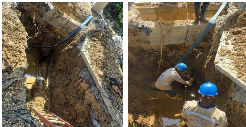
Desmonte de tubería afectada y limpieza
