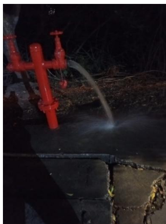
Pruebas hidráulicas y restablecimiento del servicio
