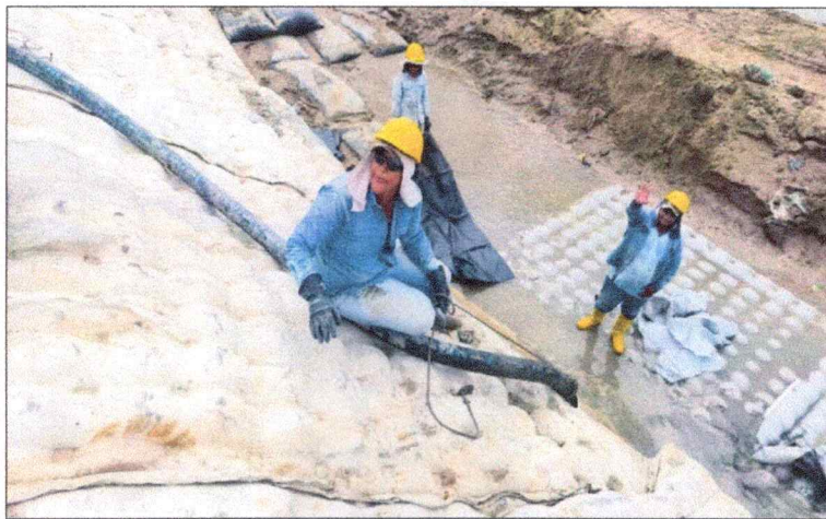
Ilustración 15 Suministro E Instalción De Flexocreto
