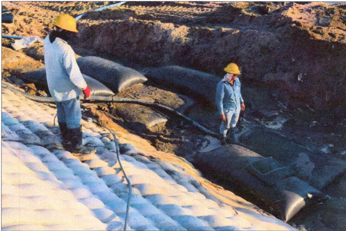
Ilustración 16 Suministro E Instalción De Bolsacreto
