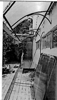
Foto 12: Instalación de cubierta en policarbonato
