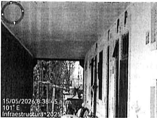
Cielo raso de toda la edificación en PVC
