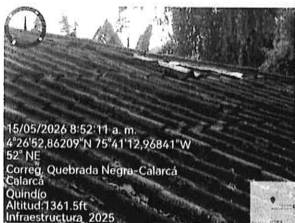
Cubierta en teja fibro-cemento tipo española
