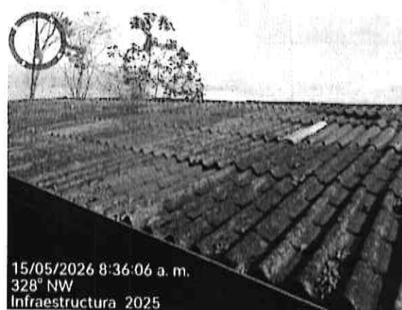
Cubierta en teja fibro-cemento tipo española
