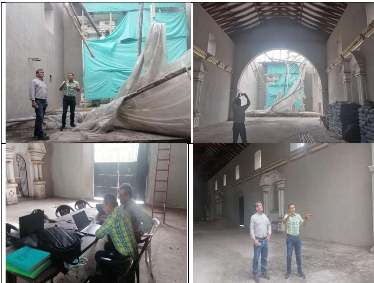
Visita técnica Especialista Estructural Interventoria, revisión materialización estructura presbítero y coro
