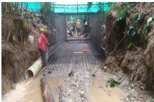
Armado de acero.
