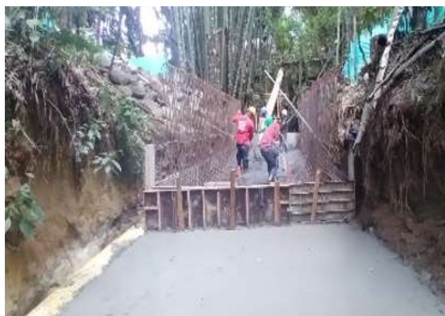
Armado de formaleta y vaciado de losa.
