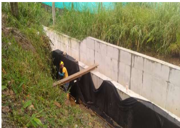
Excavación para filtros laterales.
