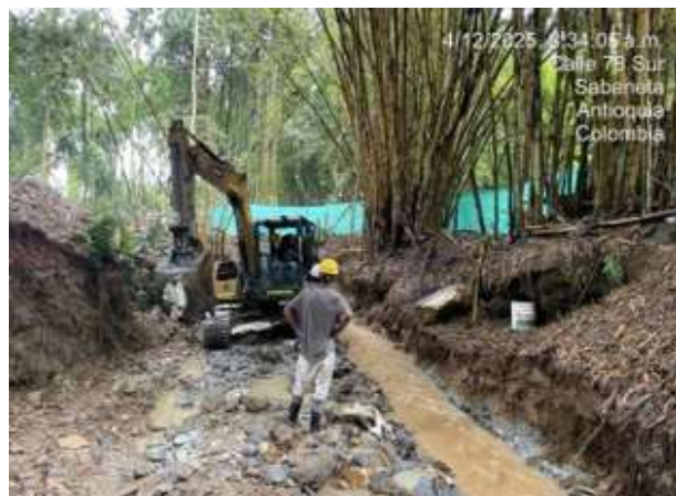
Remoción de detritos con maquinaria.
