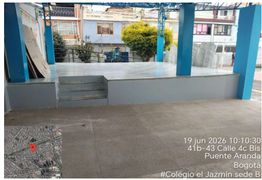
Piso en Gravilla y pintura
