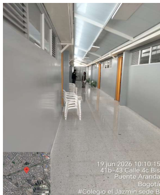
Pintura en Hall
