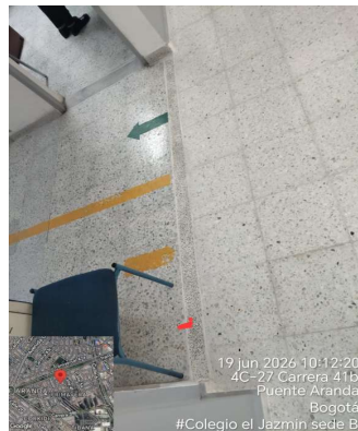
Instalacion de granito
