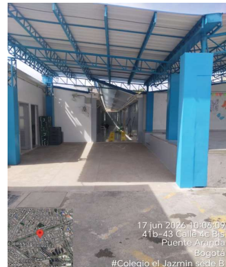
Recubrimiento de bajante en superboard
