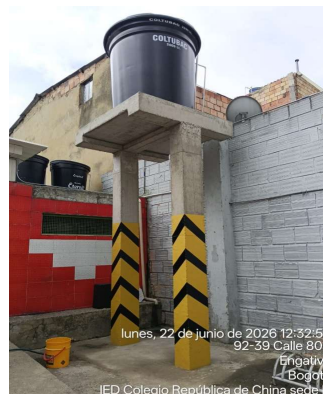
Aplicación de pintura en columnas de pedestal.
