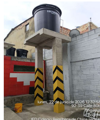
Aplicación de pintura en columnas de pedestal.
