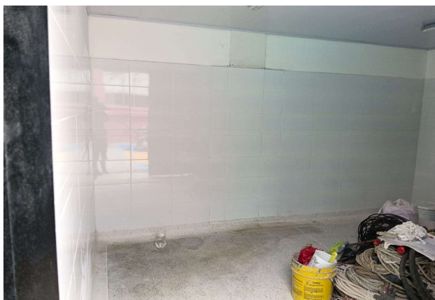
Instalacion total de enchape de muro en el shut
