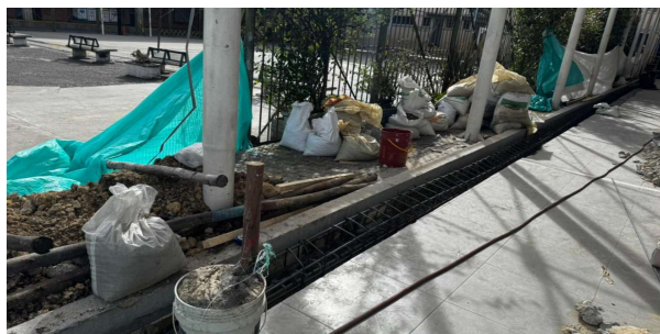
Excavación para reja
