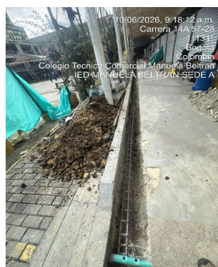
Demolicion y excavacion total de zanja
