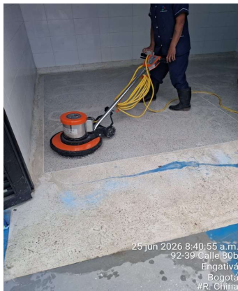
Limpieza de enchape de piso en shut de basuras
