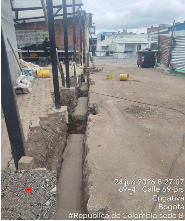
Aplicación de concreto pobre
