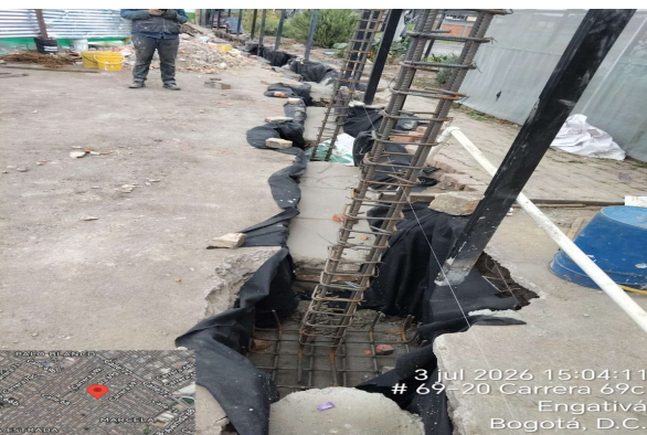
Alistamiento de zapatas y columnas para fundición
