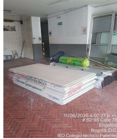
Acopio de material de eterboard, fibro termoacustica de vidrio y perfilaria metalica.
