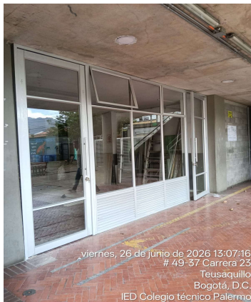
Desmonte e instalacion de puertas-ventanas
