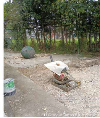
Demolición de placa y excavación
