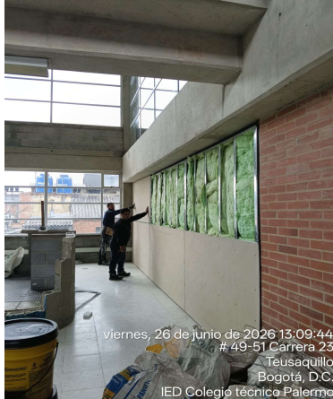
Instalación de muro en superboard con termoacustico de fibra de vidrio
