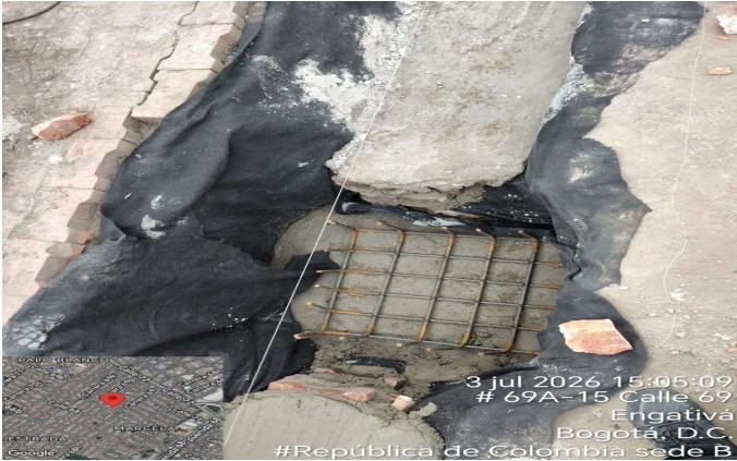
Instalación geotextil
