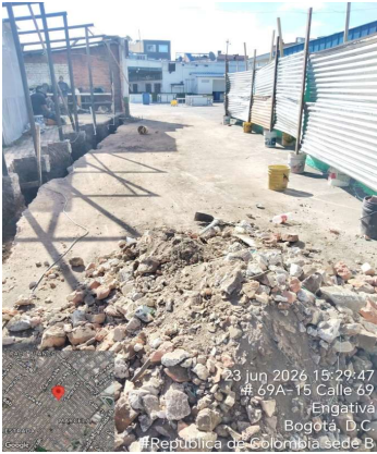
Retiro de residuo de excavación
