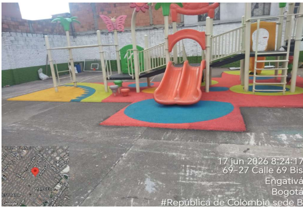
Instalacion de tapete
