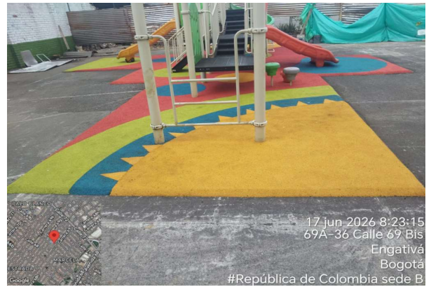
Instalacion de tapete
