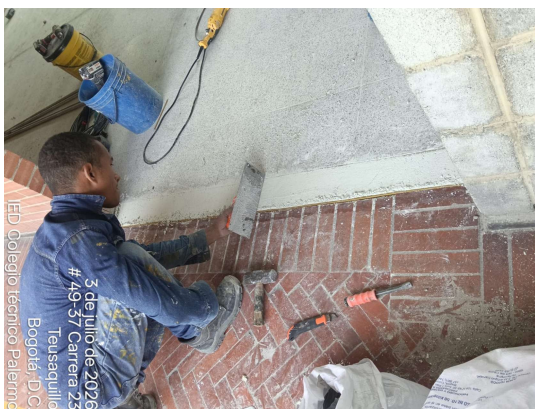
Instalación de bocapuerta en granito
