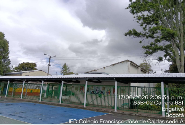
Vista frontal de cubierta con caballete y canaletas
