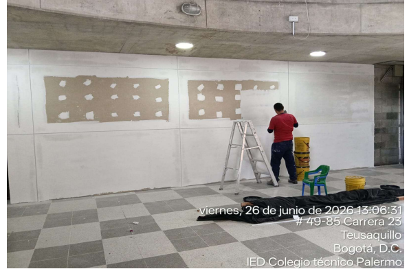
Masillado de muro
