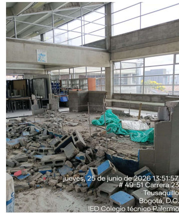
Demolicion de mamposteria estructural
