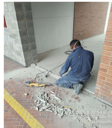
Demolición de cinta con pulidora PLANTA 3
