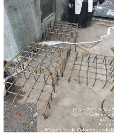
Armado acero para zapatas
