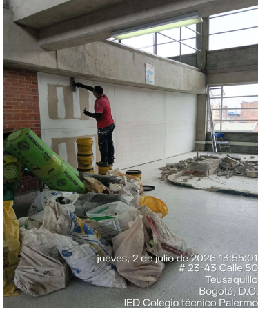
Masillado en muro de superboard PLANTA 3
