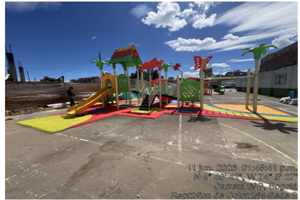
Instalacion de tapete
