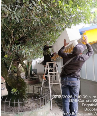
Instalación de canaleta- fachada trasera
