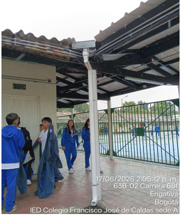
Instalación de bajantes
