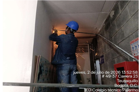
Retiro de tubería de gas PLANTA 1
