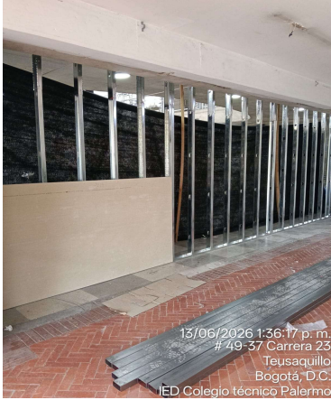
Elaboracion de muro divisor en eterboard de 8mm
