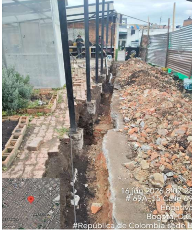
Demolicion de placa y adoquin
