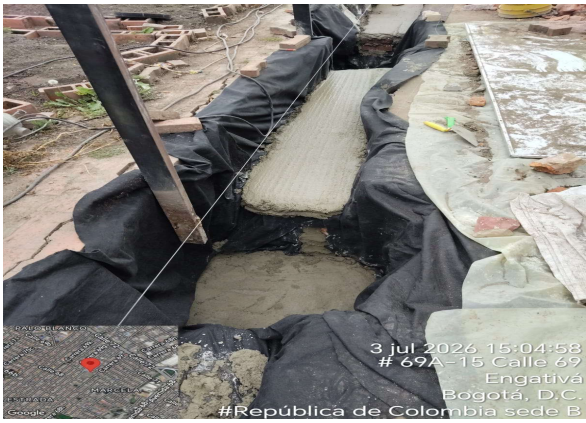
Fundido de concreto pobre
