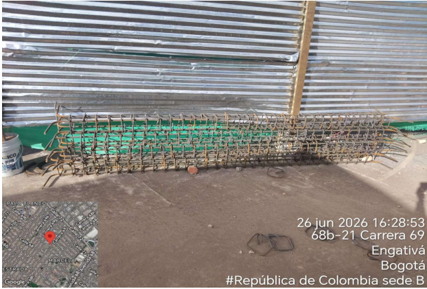
Armado acero para columnas
