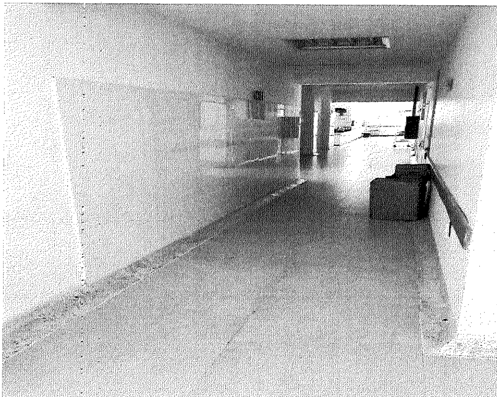
Cambio de porcelanato pasillo entre partos y urgencias.
