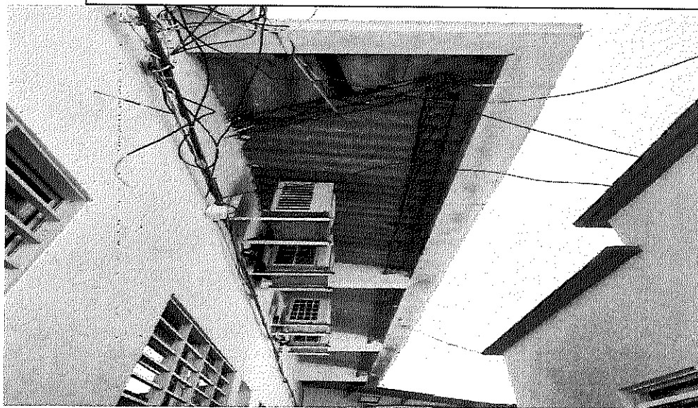
Estructura de cubierta administración y gerencia.
