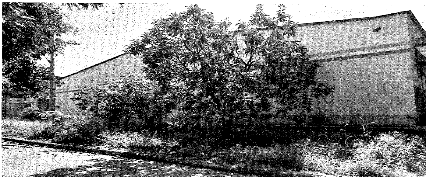
Fachada del costado
