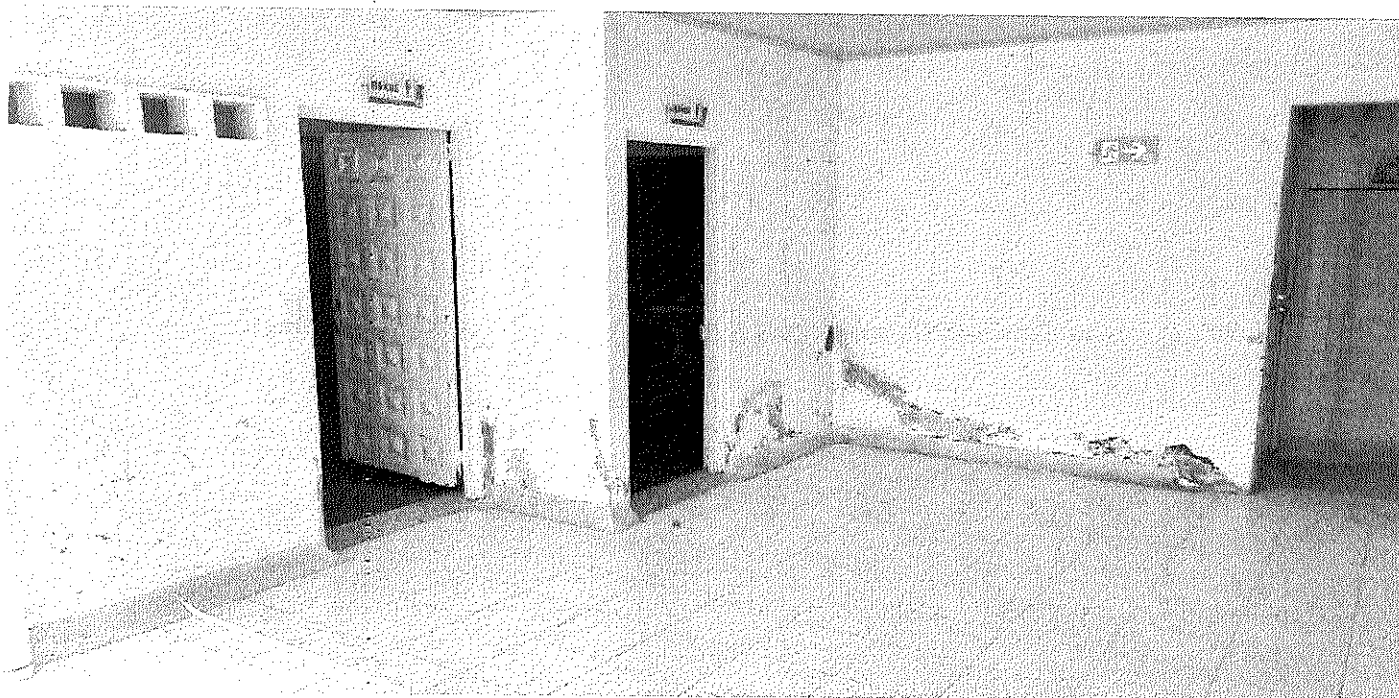
Baños Odontología – Paredes en mal estado. Puertas malas.
