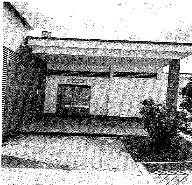
Fachada de Urgencias
