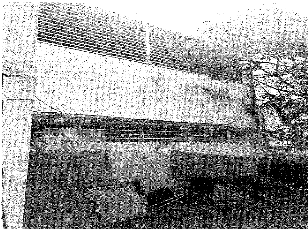
Ventana de sala de espera Urgencias - Abajo, exterior de archivo
