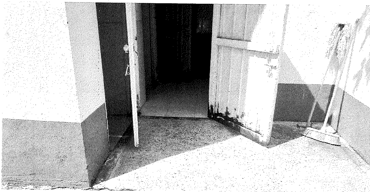
Puertas de servicios generales
