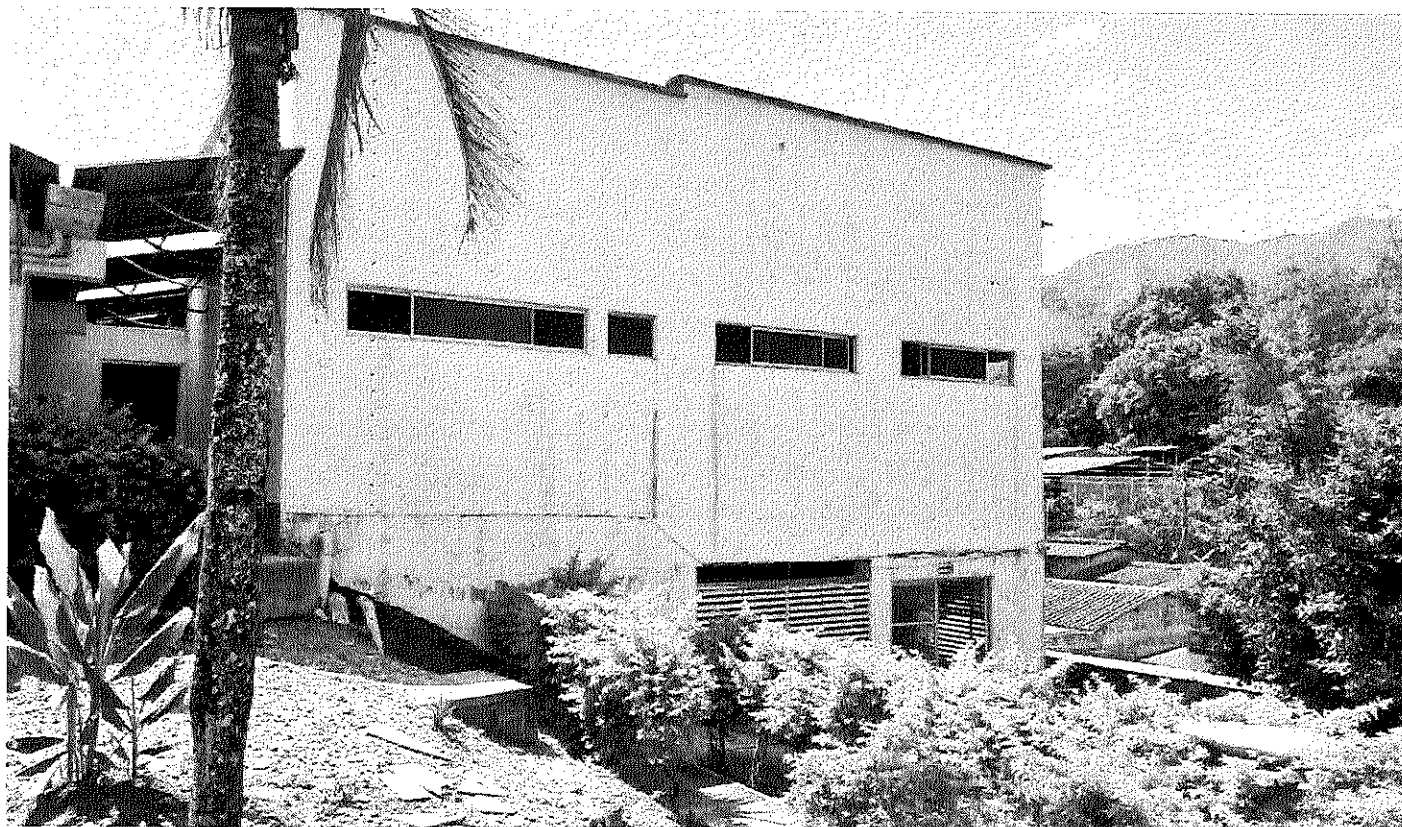
Fachada trasera Urgencias, parte inferior Auditorio
