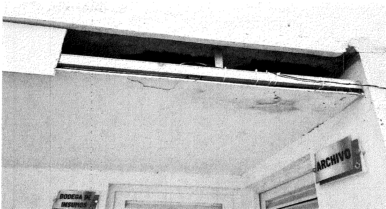
Cielo Raso pasillo archivo.
