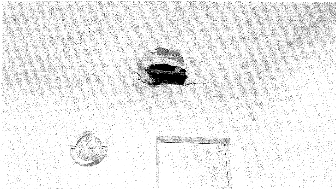
Procedimientos Urgencias – Cielo raso en mal estado.
