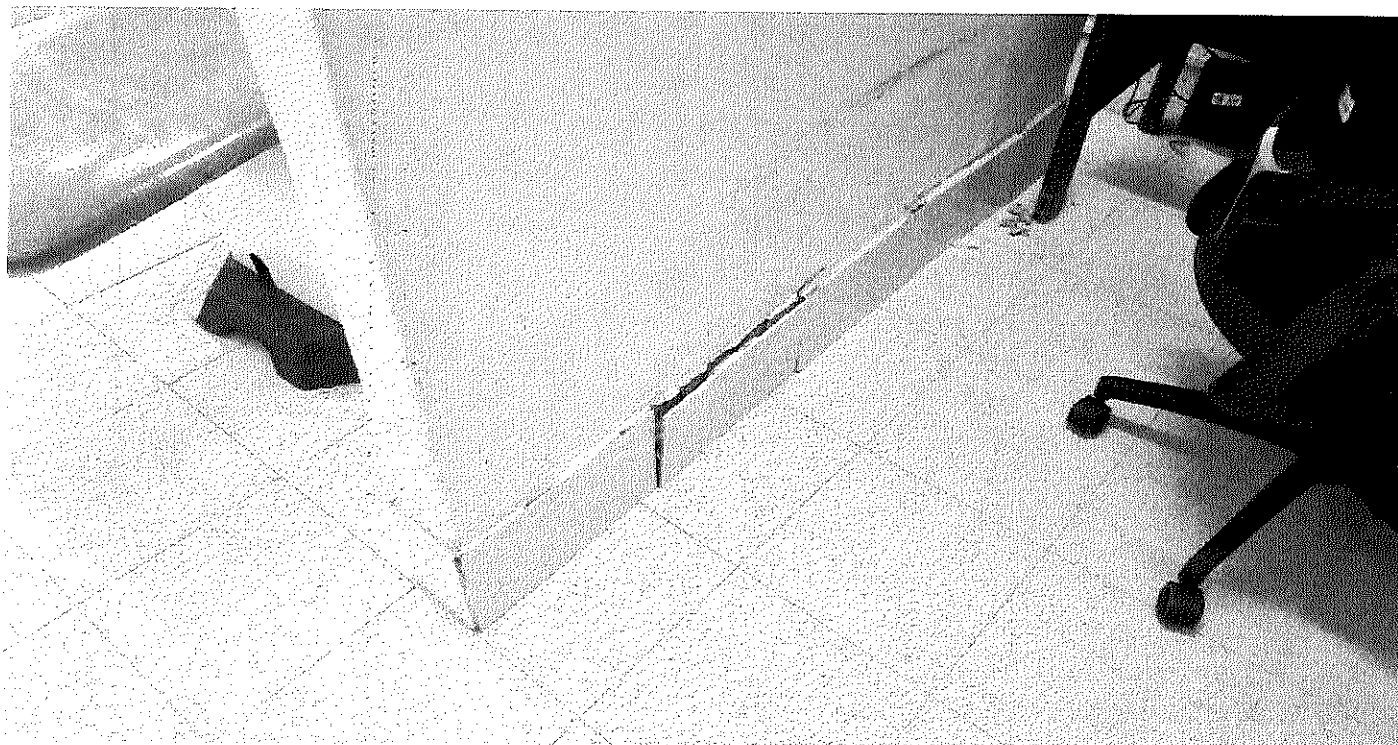
Piso para cambiar – Baldosas en mal estado.
