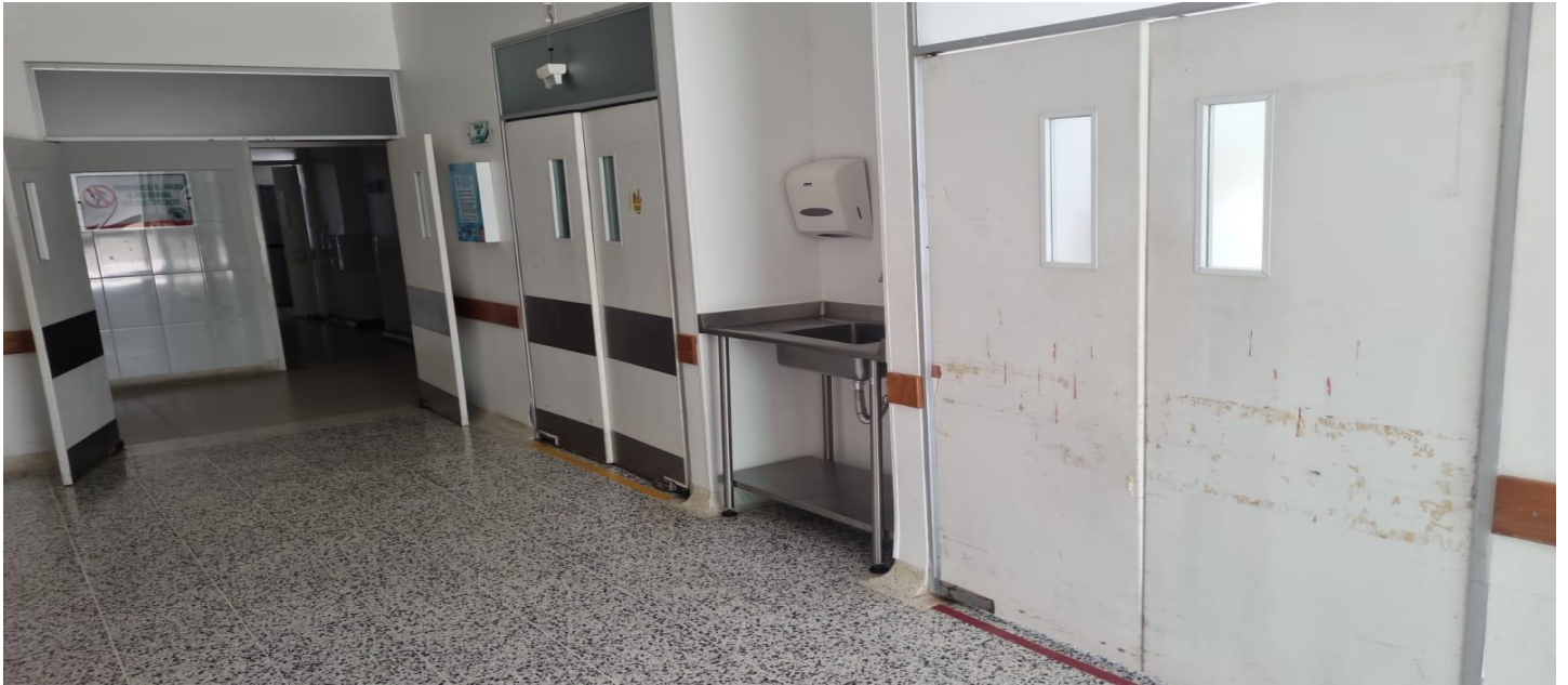
Reanimación y Sala ERA con puertas en madera, deben ser reemplazadas por mal estado.
