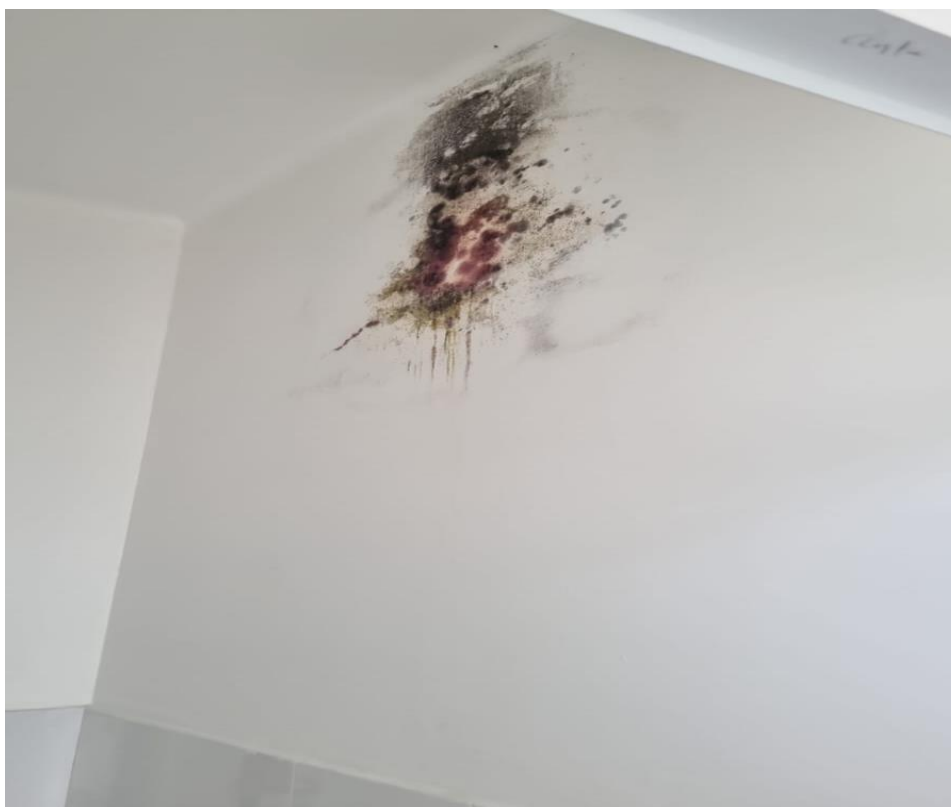
Humedad por aire acondicionado Urgencias
