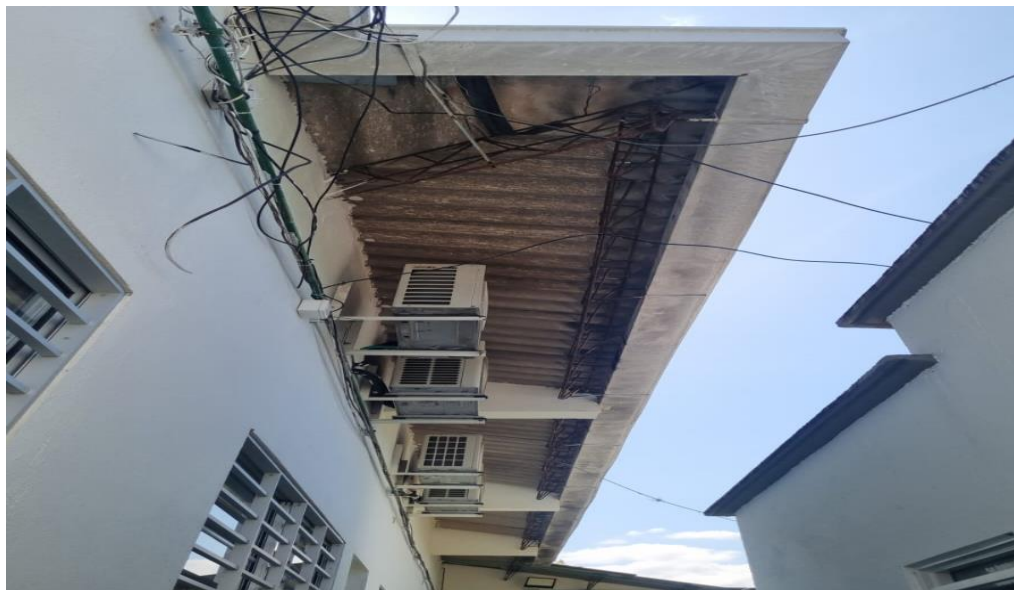
Estructura de cubierta administración y gerencia.
