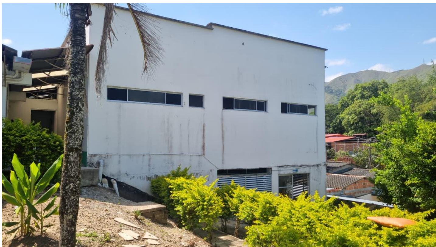
Fachada trasera Urgencias, parte inferior Auditorio
