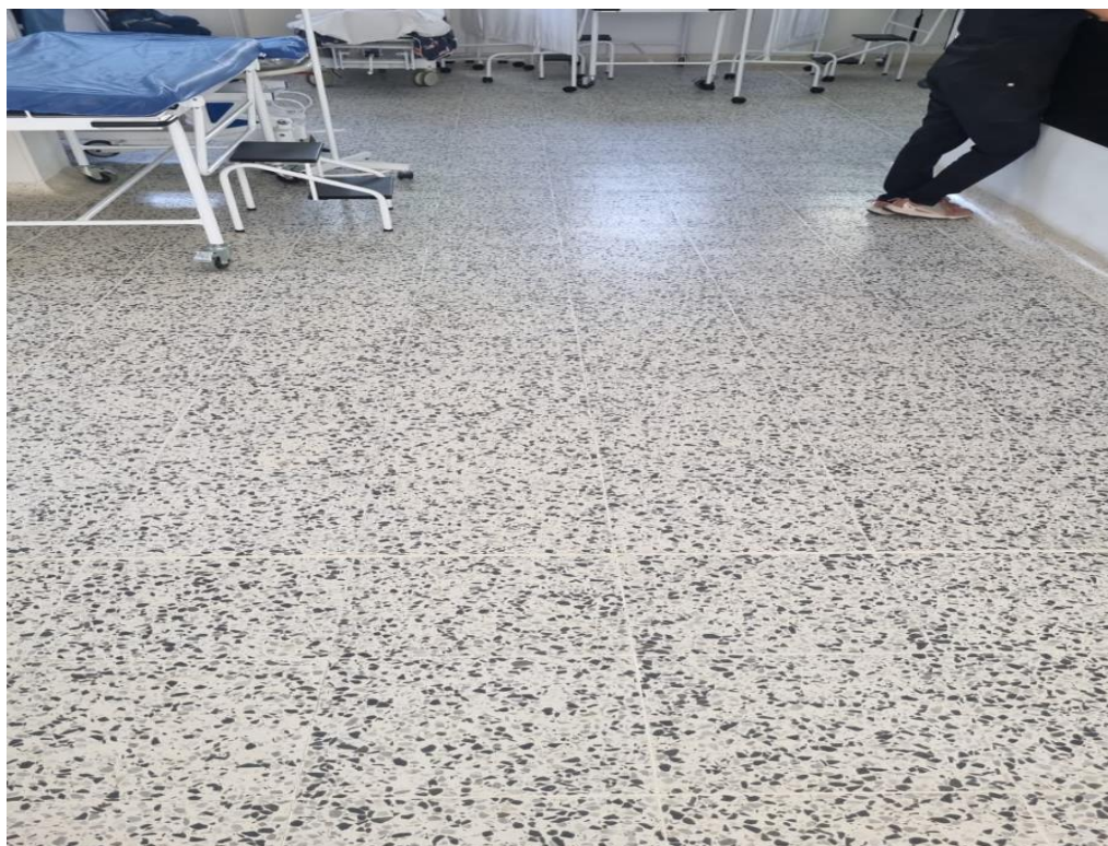
Piso de urgencias para mantenimiento. Troquelado y brillo.
