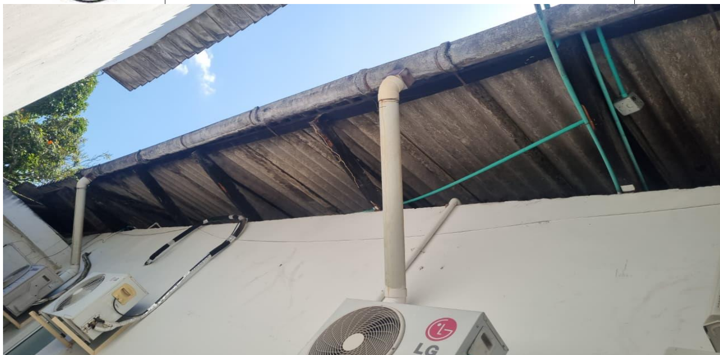
Estructura en madera para la cubierta de Laboratorio y Rayos X
