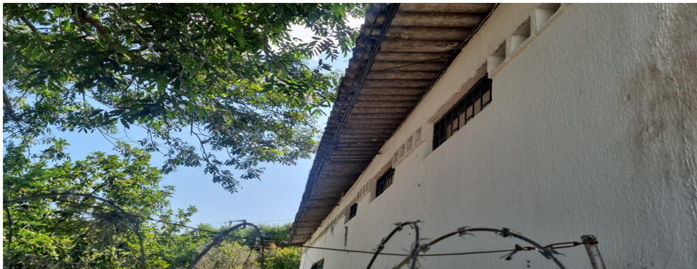
Estructura de cubierta de almacén y odontología
