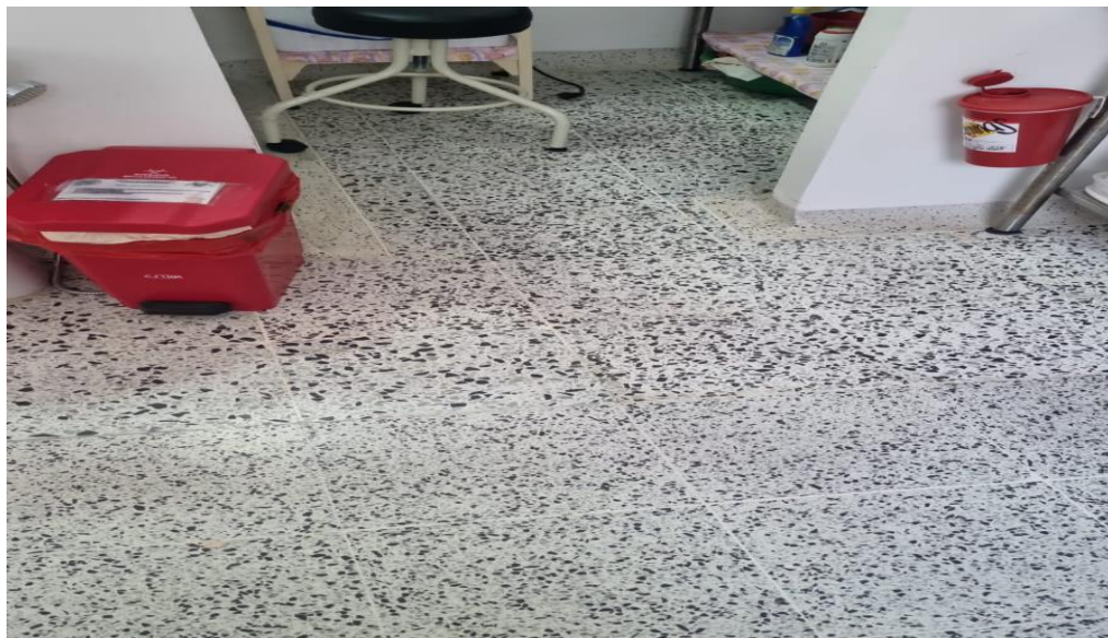
Piso laboratorio para mantenimiento. Troquelado y brillo.
