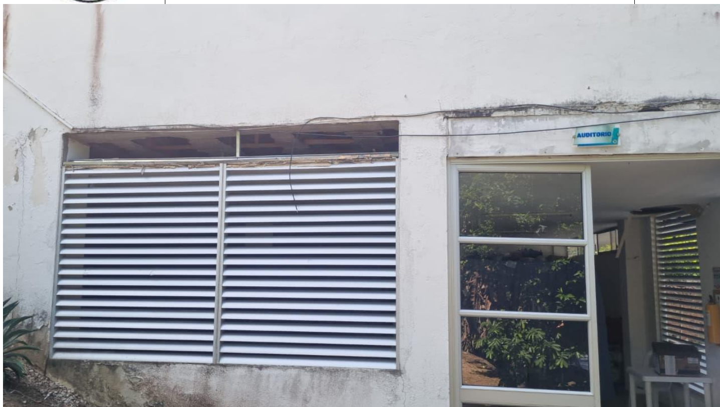
Cielo raso auditorio
