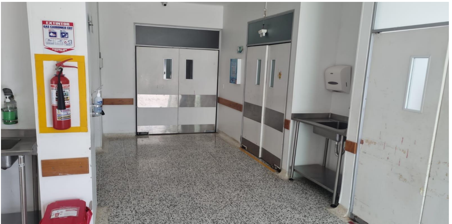
Reanimación y Sala ERA con puertas en madera, deben ser reemplazadas por mal estado.
