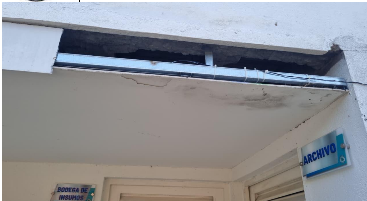
Cielo Raso pasillo archivo.
