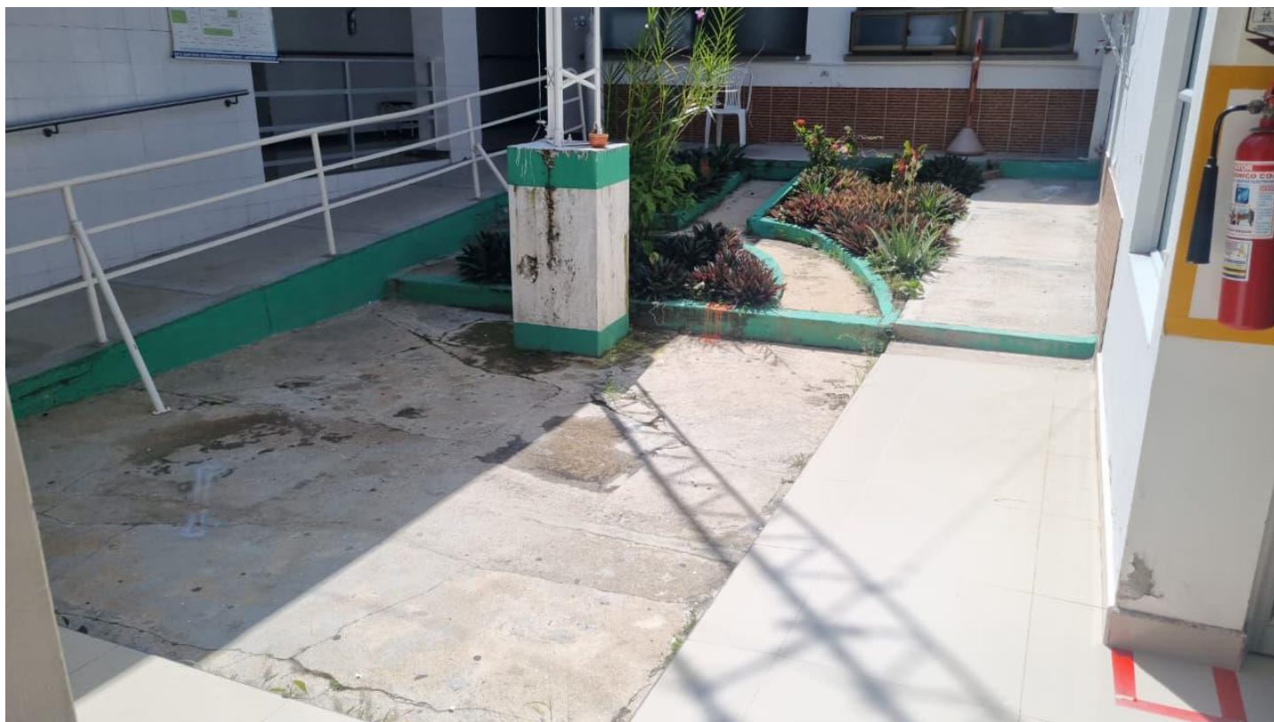
Arreglo de piso frente a gerencia y cambio de baranda de acceso
