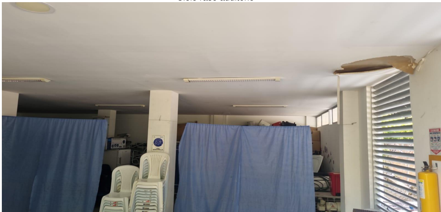
Cielo Raso Auditorio
