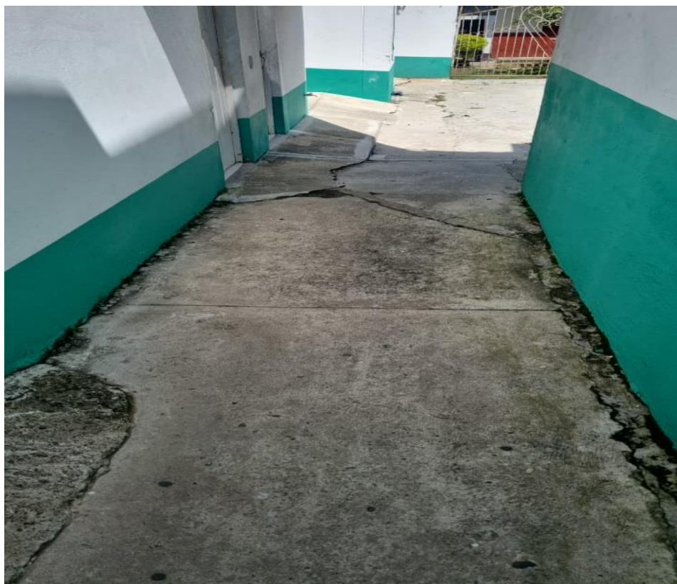
Piso de pasillo de servicios generales
