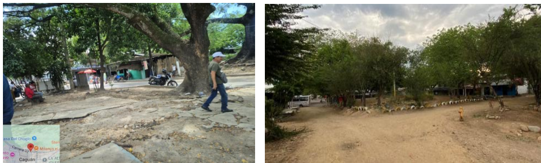
Figura 1. Estado actual del lugar de ejecución del proyecto.
