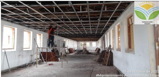
ESTRUCTURA PARA CIELO RASO ALOJAMIENTO DE TROPA PISO 2 Y MANTENIMIENTO DE ESTRUCTURA EN MADERA.
