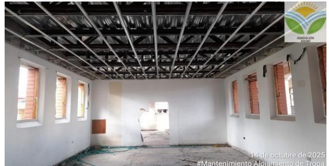
ESTRUCTURA PARA CIELO RASO PVC, ALOJAMIENTO DE TROPA PISO 1.
