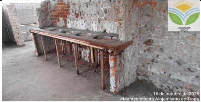
MESON EN CONCRETO PARA LAVAMANOS, BATERIA SANITARIA PISO 2.
