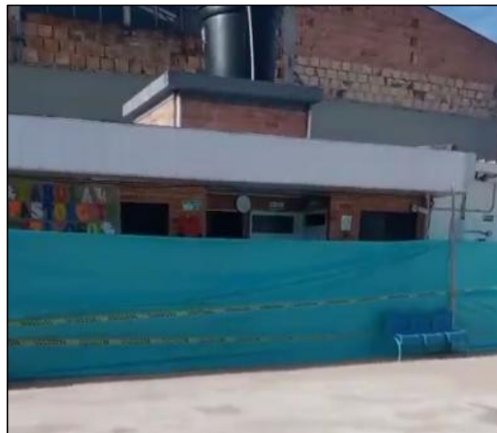
Ilustración 9. Cerramiento intervención de espacios Colegio Carlos Arturo Torres. Fuente: Autor
