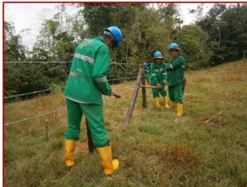
Figura 8. Forma como se realizará el templado de alambre y la colocación de piedeamigos en los predios seleccionados para el proyecto
