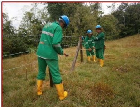
Figura 8. Forma como se realizará el templado de alambre y la colocación de piedeamigos en los predios seleccionados para el proyecto
