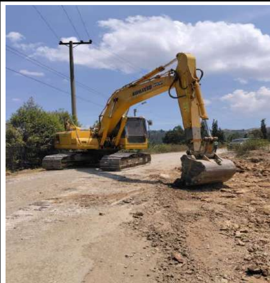
DEMOLICION PAVIMENTO ASFALTICO E<=3 CMS(INCLUYE CARGUE Y TRANSPORTE HASTA 5 KM) K0+000-K0+900
