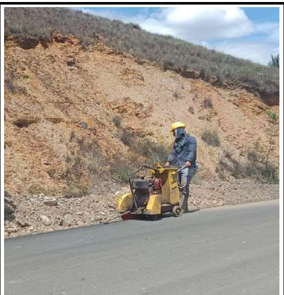
CORTE DE PAVIMENTO ASFÁLTICO DESDE K3+500 HASTA K4+400
