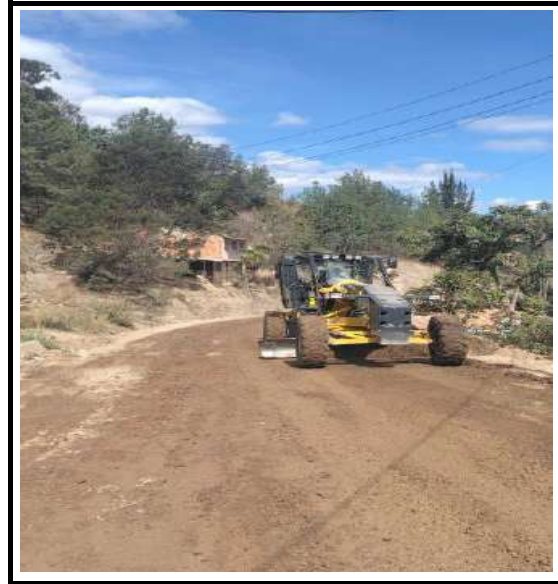
SUMINISTRO, EXTENDIDA Y COMPACTACIÓN DE MATERIAL SELECCIONADO PARA SUBBASE GRANULAR (INCLUYE ACARREO LIBRE HASTA 5KM) (**) K0+820 HASTA K0+980
