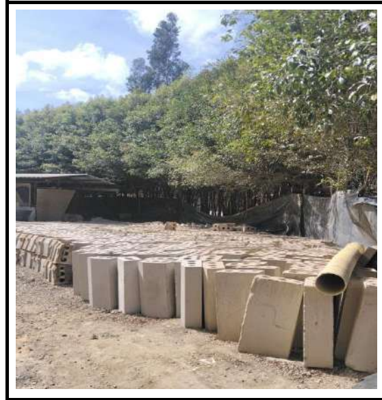
SUMINISTRO E INSTALACIÓN DE BORDILLO PREFABRICADO A-80 35*20*80
