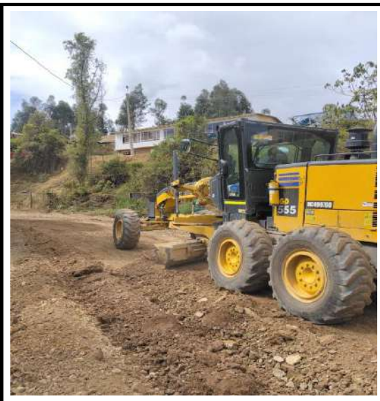
SUMINISTRO, EXTENDIDA Y COMPACTACIÓN DE MATERIAL PARA AFIRMADO HASTA UN DIÁMETRO DE 2" Y UN ÍNDICE PLÁSTICO MENOR O IGUAL 9% Y COMPACTO AL 95% PROCTOR, INCLUYE ACARREO LIBRE HASTA 5 KM (**) K0+000 hasta K0+400; Tambien desde K0+820 hasta K0+980
