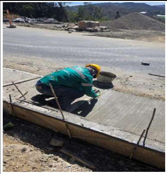
CUNETAS REVESTIDAS EN CONCRETO DE 21 MPA ( 3000 PSI) SIN REFUERZO (INCLUYE SELLO DE JUNTAS) K3+440 HASTA K3+700 COSTADO DERECHO
