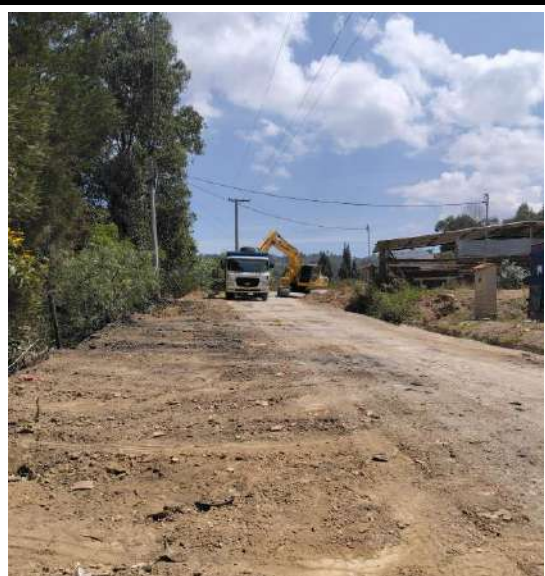
EXCAVACIÓN DE CORTES Y CANALES SIN CLASIFICAR (INCLUYE ACARREO LIBRE HASTA 5 KM.) DESDE K0+810 HASTA K0+980
