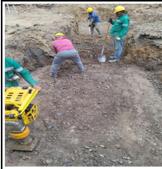
EXCAVACIÓN MANUAL EN MATERIAL COMUN K6+190
