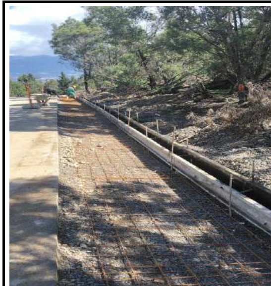
SUMINISTRO E INSTALACIÓN DE MALLA ELECTROSOLDADA DESDE K1+020 HASTA K0+980 COSTADO IZQUIERDO
