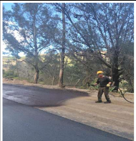
IMPRIMACIÓN CON EMULSIÓN ASFÁLTICA TIPO CRR-1 O SIMILAR DESDE K5+300 HASTA K5+400
