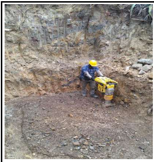
RELLENO CON MATERIAL DE AFIRMADO COMPACTADO RANA Y/O VIBROCOMPACTADOR. (INCLUYE ACARREO LIBRE HASTA 5 KM.) K6+190
