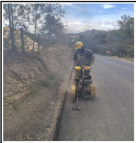
CORTE DE PAVIMENTO ASFÁLTICO K4+400 HASTA K4+700 POR AMBOS COSTADOS
