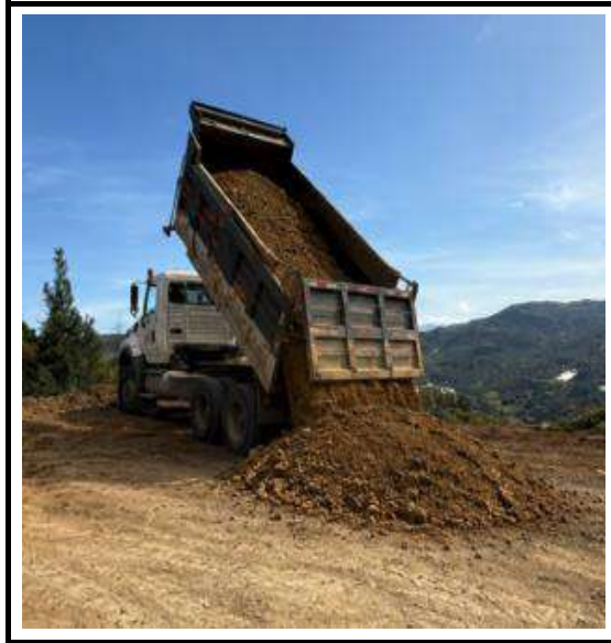
CONFORMACION DE BOTADERO O ESCOMBRERA
