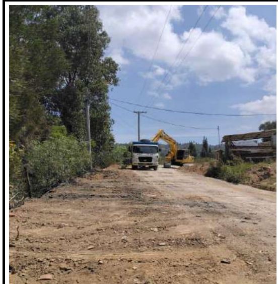
DEMOLICION PAVIMENTO ASFALTICO E<=3 CMS(INCLUYE CARGUE Y TRANSPORTE HASTA 5 KM) K0+000-K0+900
