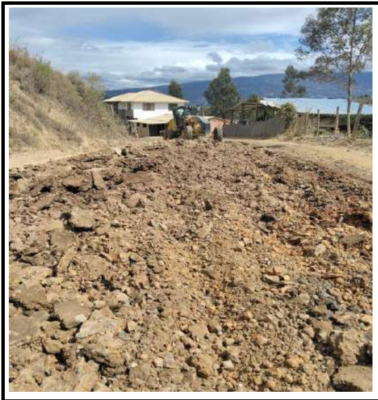
ESCARIFICACION, MEZCLADO, CONFORMACION Y COMPACTACIÓN DE SUBBASE Y/O BASE K0+820 HASTA K0+980
