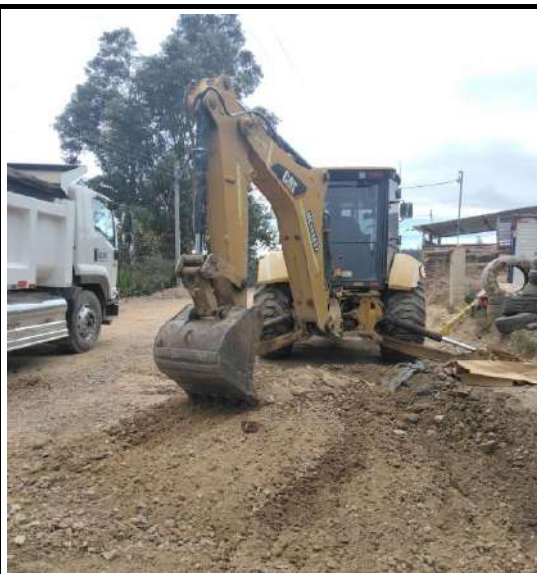
EXCAVACIÓN DE CORTES Y CANALES SIN CLASIFICAR (INCLUYE ACARREO LIBRE HASTA 5 KM.) K0+000-K0+030
