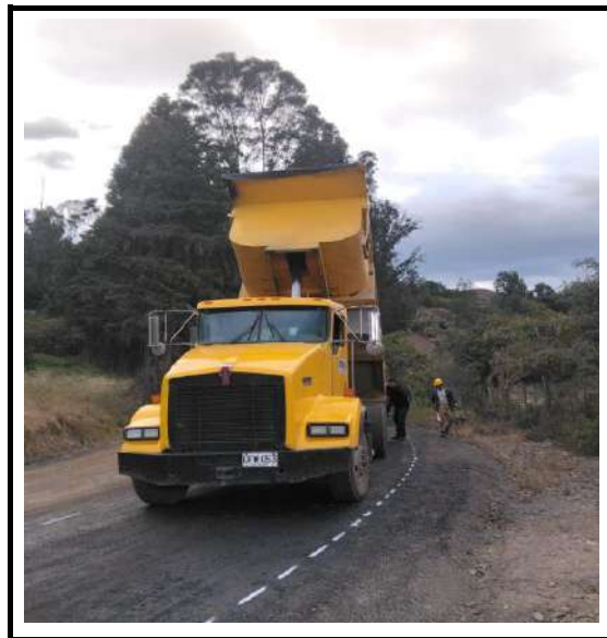
TRANSPORTE DE MEZCLA ASFALTICA DESPUES DE 5 KM, (MEDIDA EN BANCO). K5+400
