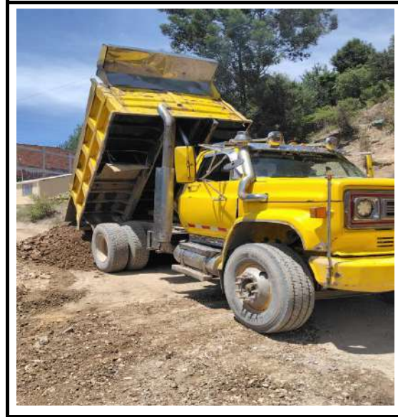
TRANSPORTE DE MATERIAL DE AFIRMADO Y/O GRANULAR SUELTO (MEDIDO EN BANCO) DESPUÉS DE 5 KM. AFIRMADO Y SUB BASE
