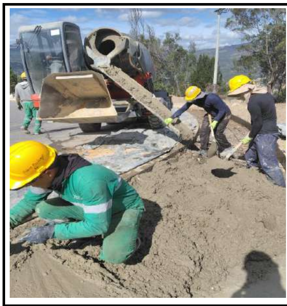
CUNETAS REVESTIDAS EN CONCRETO DE 21 MPA ( 3000 PSI) SIN REFUERZO (INCLUYE SELLO DE JUNTAS) DESDE K1+020 HASTA K0+980 COSTADO IZQUIERDO
