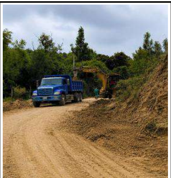
DEMOLICIÓN OBRAS EN CONCRETO SIMPLE, INCLUYE CARGUE Y RETIRO DE SOBRANTES CON ACARREO LIBRE HASTA 5 KM.) DESDE K0+000 HASTA K0+980
