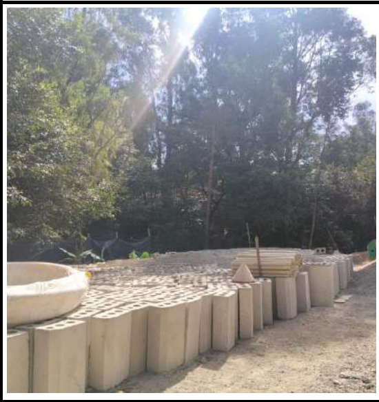
SUMINISTRO E INSTALACIÓN DE SARDINEL PREFABRICADO A-10 50*20*80
