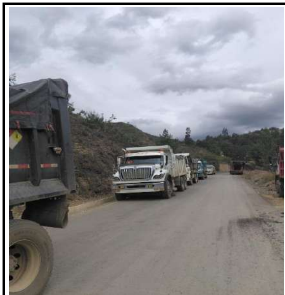
TRANSPORTE DE MEZCLA ASFALTICA DESPUES DE 5 KM, (MEDIDA EN BANCO). DESDE K4+540 HASTA K5+300
