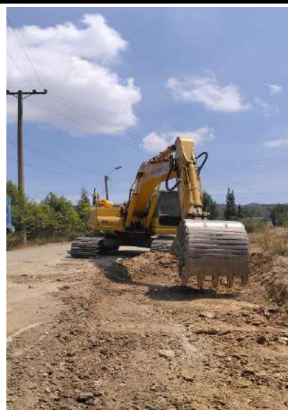
EXCAVACIÓN DE CORTES Y CANALES SIN CLASIFICAR (INCLUYE ACARREO LIBRE HASTA 5 KM.) DESDE K0+810 HASTA K0+980
