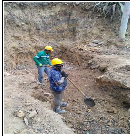
EXCAVACIÓN MANUAL EN MATERIAL COMUN K6+190
