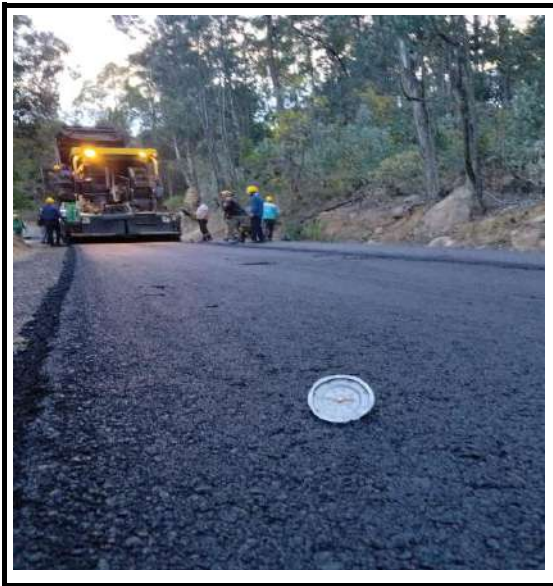
SUMINISTRO E INSTALACIÓN DE CARPETA ASFALTICA EN CALIENTE MDC-19. INCLUYE BARRIDO, SOPLADO, SUMINISTRO Y COMPACTACIÓN. (INCLUYE ACARREO LIBRE HASTA 5 KM) NORMA INVIAS (**). DESDE K5+300 HASTA K5+400
