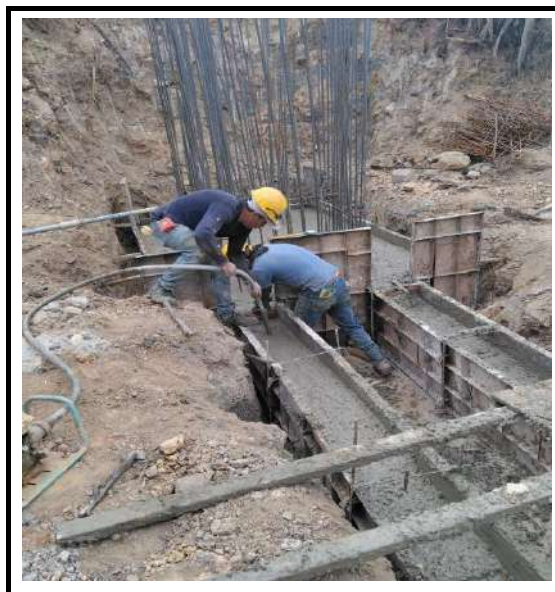
CONCRETO PARA ZAPATAS DE 21 MPa (3000 PSI) + FORMALETA MADERA
