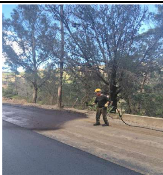
IMPRIMACIÓN CON EMULSIÓN ASFÁLTICA TIPO CRR-1 O SIMILAR DESDE K4+540 HASTA K5+300
