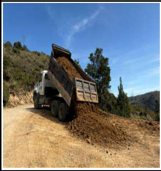
CONFORMACION DE BOTADERO O ESCOMBRERA
