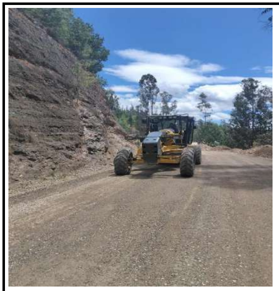
SUMINISTRO, EXTENDIDA Y COMPACTACIÓN DE MATERIAL SELECCIONADO PARA SUBBASE GRANULAR (INCLUYE ACARREO LIBRE HASTA 5KM) (**) K5+700-K6+000
