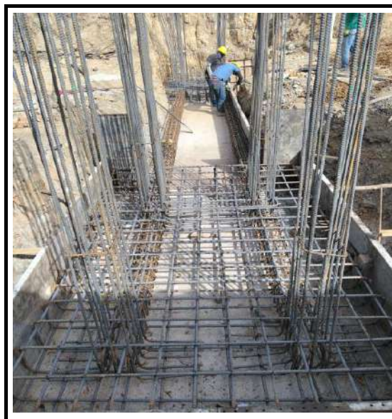
SUMINISTRO FIGURADO Y ARMADO DE ACERO DE REFUERZO 60000 PSI 420 MPA
