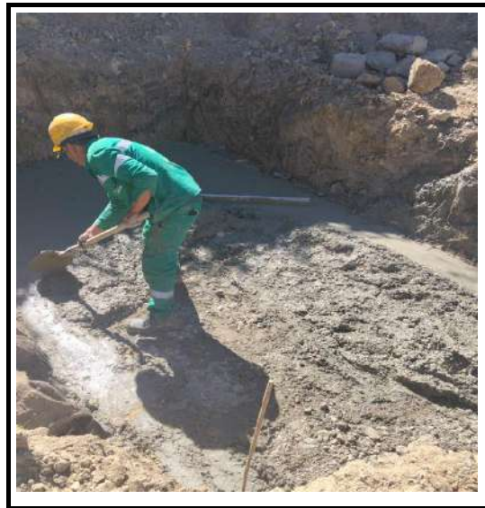
SUMINISTRO E INSTALACIÓN DE CONCRETO DE 14 MPA (2000 PSI) SOLADOS Y ATRAQUES K6+190
