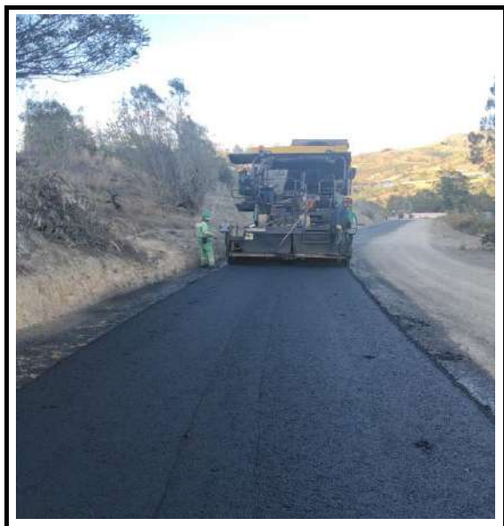
SUMINISTRO E INSTALACIÓN DE CARPETA ASFÁLTICA EN CALIENTE MDC-19. INCLUYE BARRIDO, SOPLADO, SUMINISTRO Y COMPACTACIÓN. (INCLUYE ACARREO LIBRE HASTA 5 KM) NORMA INVIA (**). DESDE K4+540 HASTA K5+300
