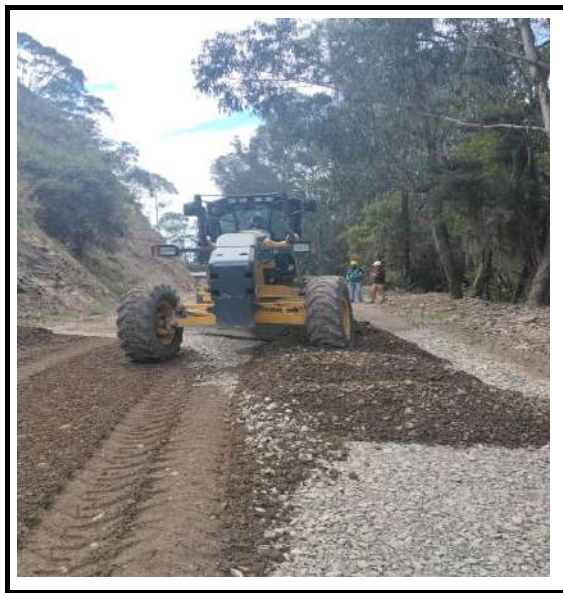
SUMINISTRO, EXTENDIDA Y COMPACTACIÓN DE MATERIAL SELECCIONADO PARA BASE GRANULAR (INCLUYE ACARREO LIBRE HASTA 5KM) (**) K5+500-K6+000
