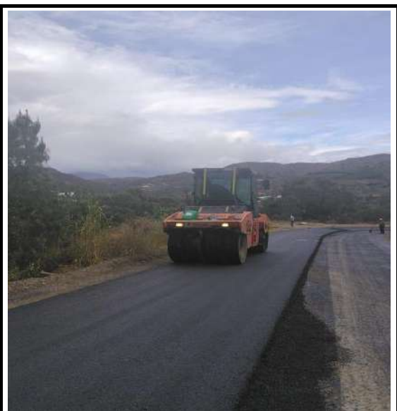
SUMINISTRO E INSTALACIÓN DE CARPETA ASFALTICA EN CALIENTE MDC-19. INCLUYE BARRIDO, SOPLADO, SUMINISTRO Y COMPACTACIÓN. (INCLUYE ACARREO LIBRE HASTA 5 KM) NORMA INVIAS (**). DESDE K4+540 HASTA K5+300
