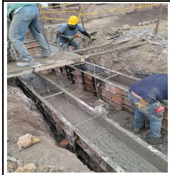
CONCRETO PARA VIGA DE AMARRE 21 MPa (3000 PSI) SECCION RECTANGULAR N -1,50 y N 0+00 K6+190
