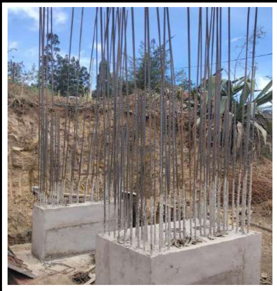
COLUMNAS Y PEDESTALES EN CONCRETO DE 21 MPa - (3000 PSI), H > 3.01 M. (FORMALETA MADERA) N-1+50 Y N0+00 K6+190
