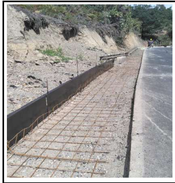
SUMINISTRO E INSTALACIÓN DE MALLA ELECTROSOLDADA DESDE K3+440 HASTA K3+700 COSTADO DERECHO
