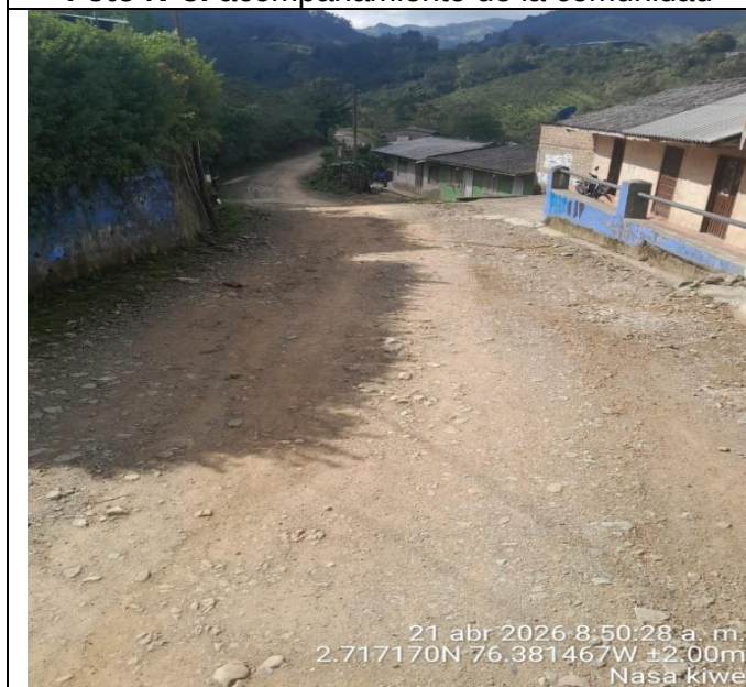
Foto N°7: Recorrido del tramo a intervenir
