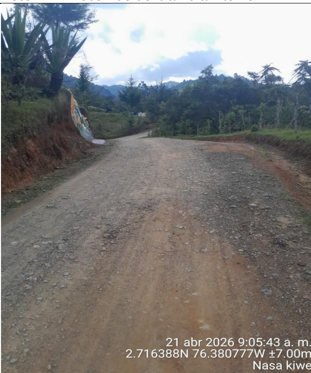
Foto N°4: Recorrido del tramo a intervenir
