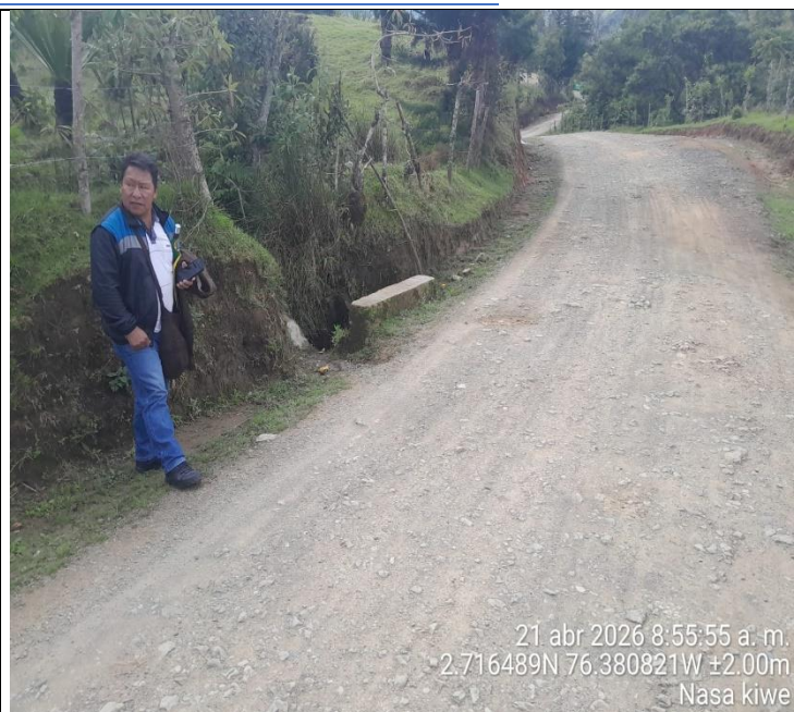
Foto N°6: Recorrido del tramo a intervenir
