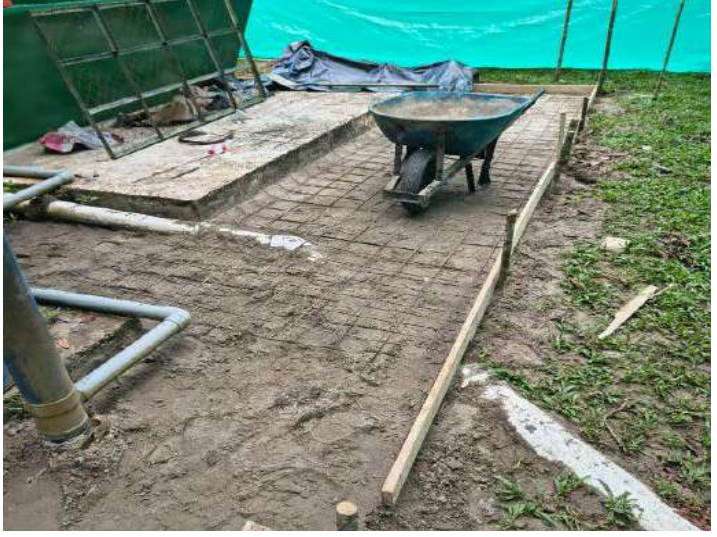
Instalación de formaletas perimetrales - SIPS Planta de Tramiento Aguas Negras
