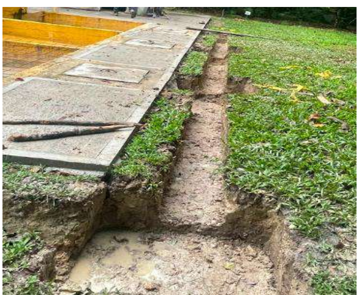
Excavación de zapatas y vigas- SIPS Planta de Tramiento Aguas Negras
