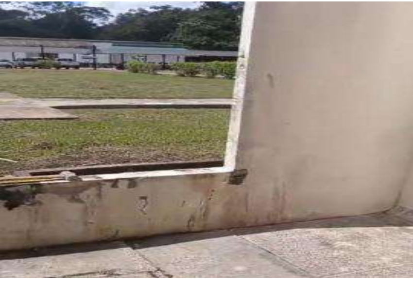
Demolición de muro - Despacho
