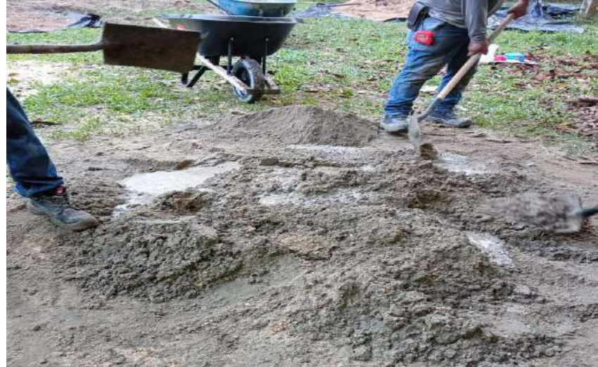
Preparación del concreto- SIPS Planta de Tramiento Aguas Negras
