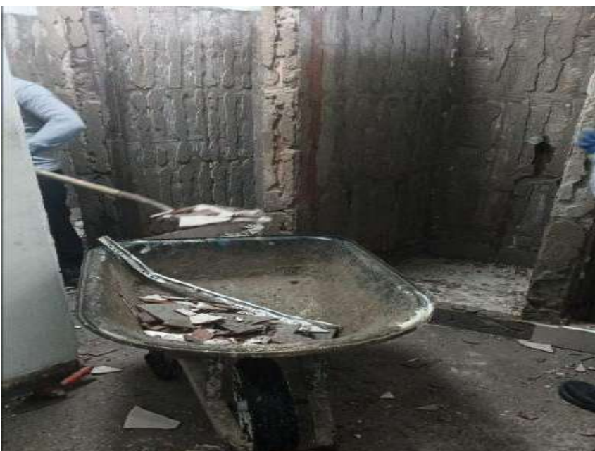
Demolición de enchape - Alojamiento soldados, Bravo
