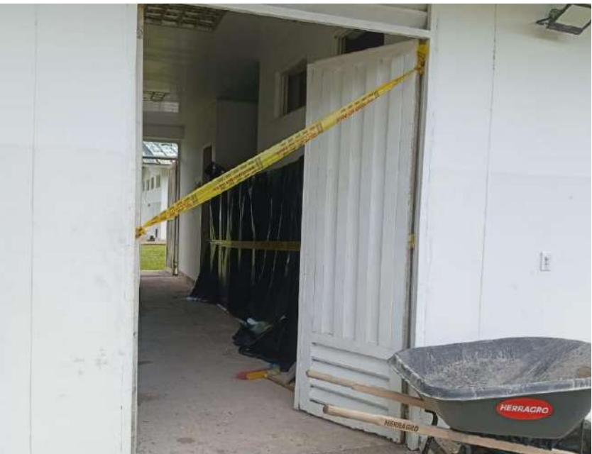
Cerramiento - Alojamiento soldados, Bravo
