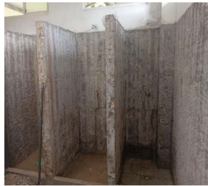
Demolición de enchape - Alojamiento soldados, Bravo
