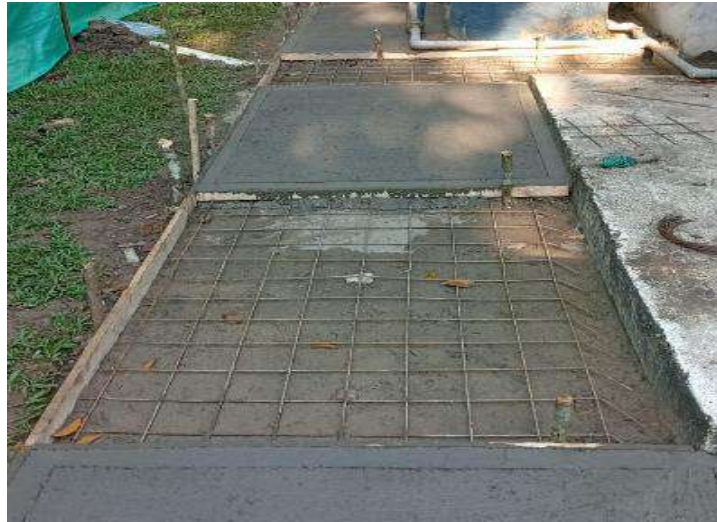
Fundición del concreto- SIPS Planta de Tramiento Aguas Negras
