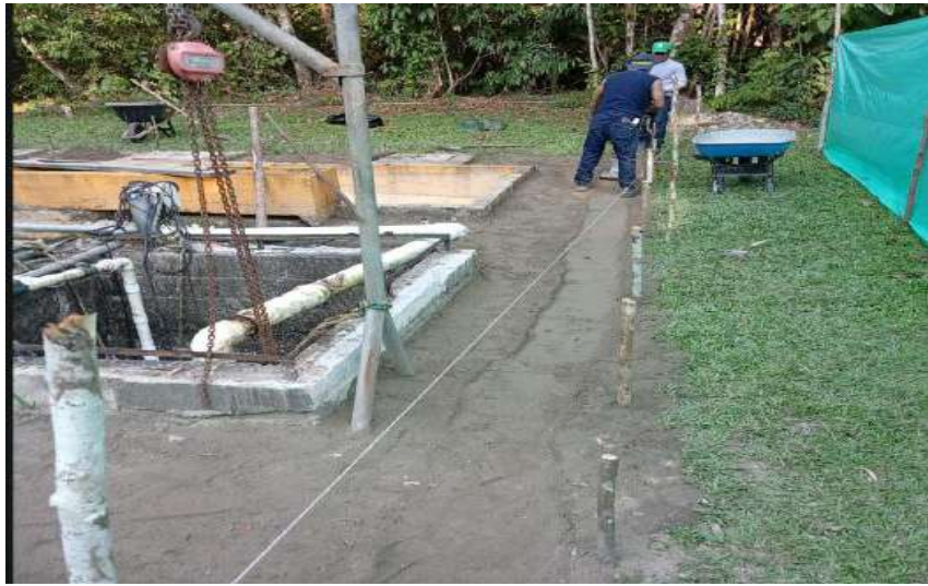
Compactación del terreno - SIPS Planta de Tramiento Aguas Negras
