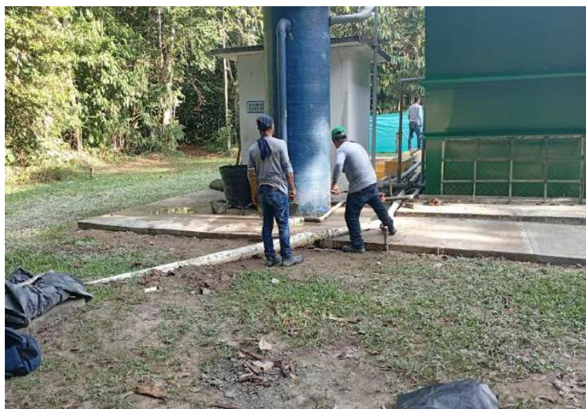
Adecuación tubería- SIPS Planta de Tramiento Aguas Negras
