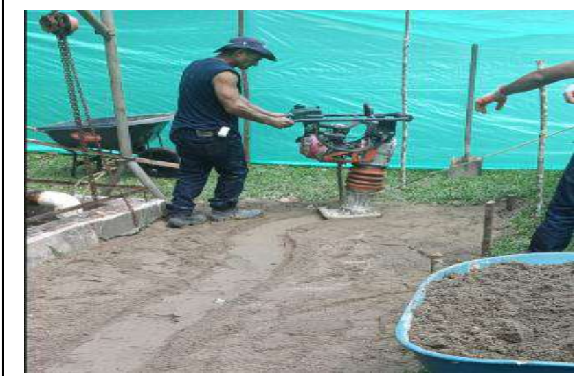
Compactación del terreno - SIPS Planta de Tramiento Aguas Negras
