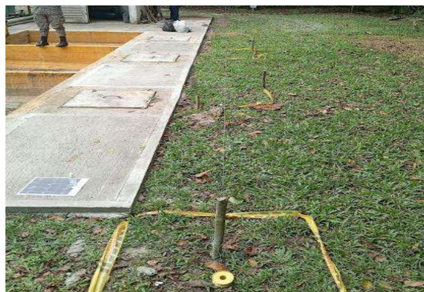
Replanteo para zapatas y vigas- SIPS Planta de Tramiento Aguas Negras
