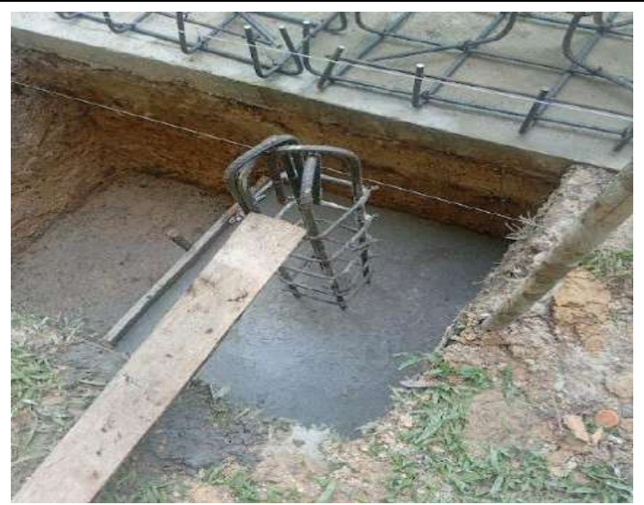
Armado de zapatas - SIPS Planta de Tramiento Aguas Negras
