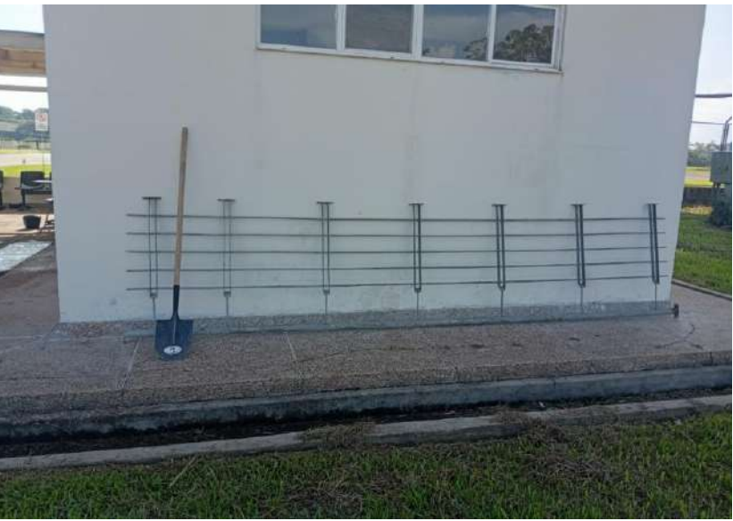
Retiro de barandas - Despacho
