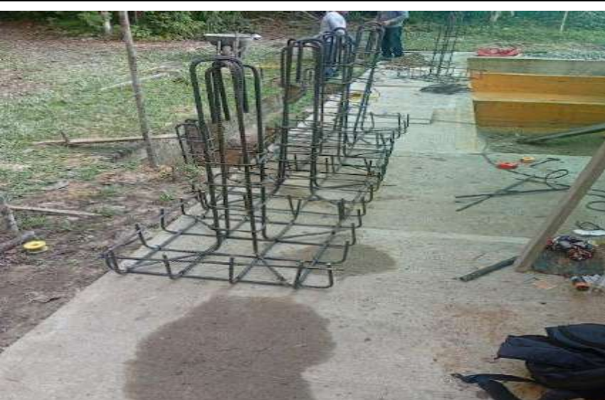
Armado de zapatas - SIPS Planta de Tramiento Aguas Negras
