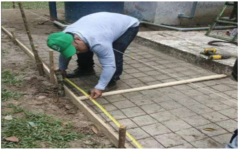
Instalación de malla - SIPS Planta de Tramiento Aguas Negras
