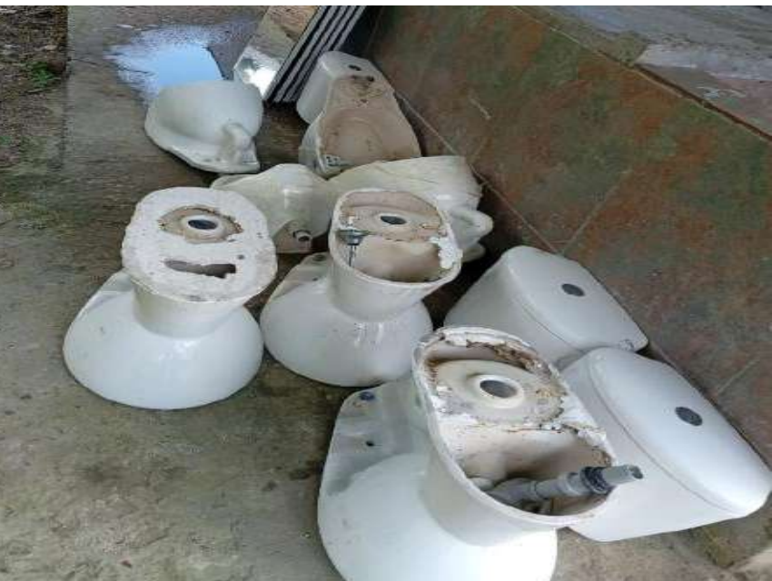
Desmorte de aparatos sanitarios - Alojamiento soldados, Bravo
