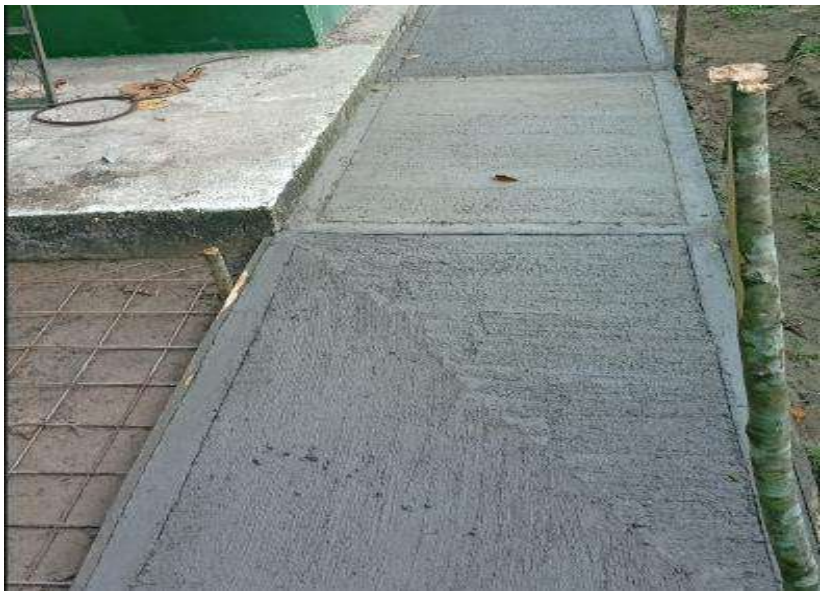
Concreto fundido- SIPS Planta de Tramiento Aguas Negras
