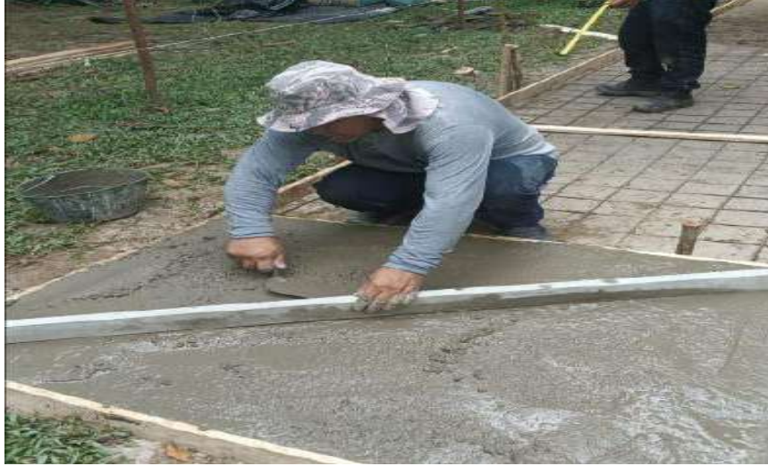
Fundición del concreto- SIPS Planta de Tramiento Aguas Negras
