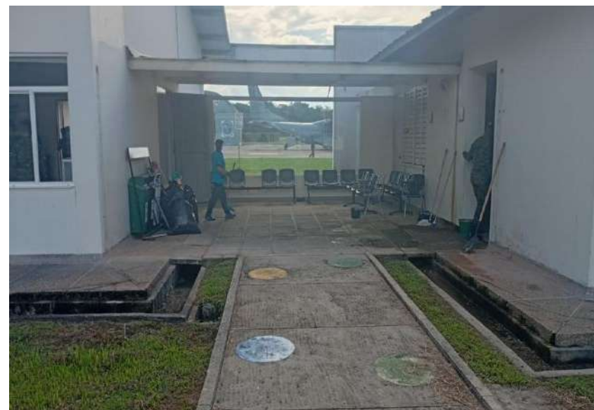
Demolición de muro - Despacho
