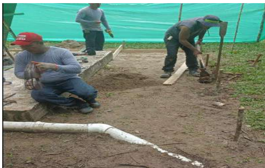
Instalación de formaletas perimetrales - SIPS Planta de Tramiento Aguas Negras
