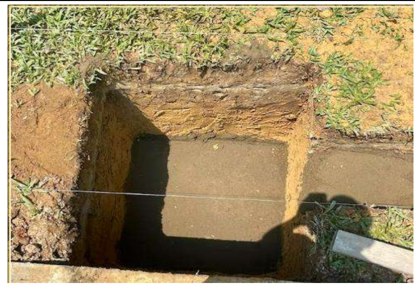
Solado en zapatas y vigas - SIPS Planta de Tramiento Aguas Negras
