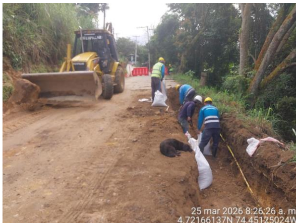
Ilustración 10. Instalación tubería 4"
