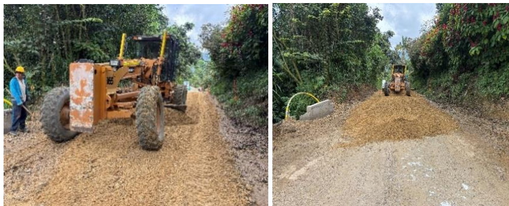
Ilustración 9. Instalación de subbase granular
