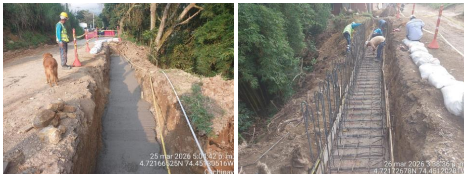
Ilustración 8. Instalación de concreto de 3000 PSI para bases
