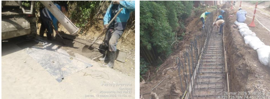
Ilustración 7. Armado de acero de refuerzo
