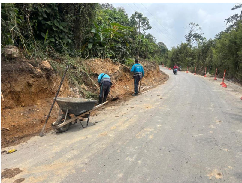
Ilustración 6. Retiro de materiales provenientes de las excavaciones.
