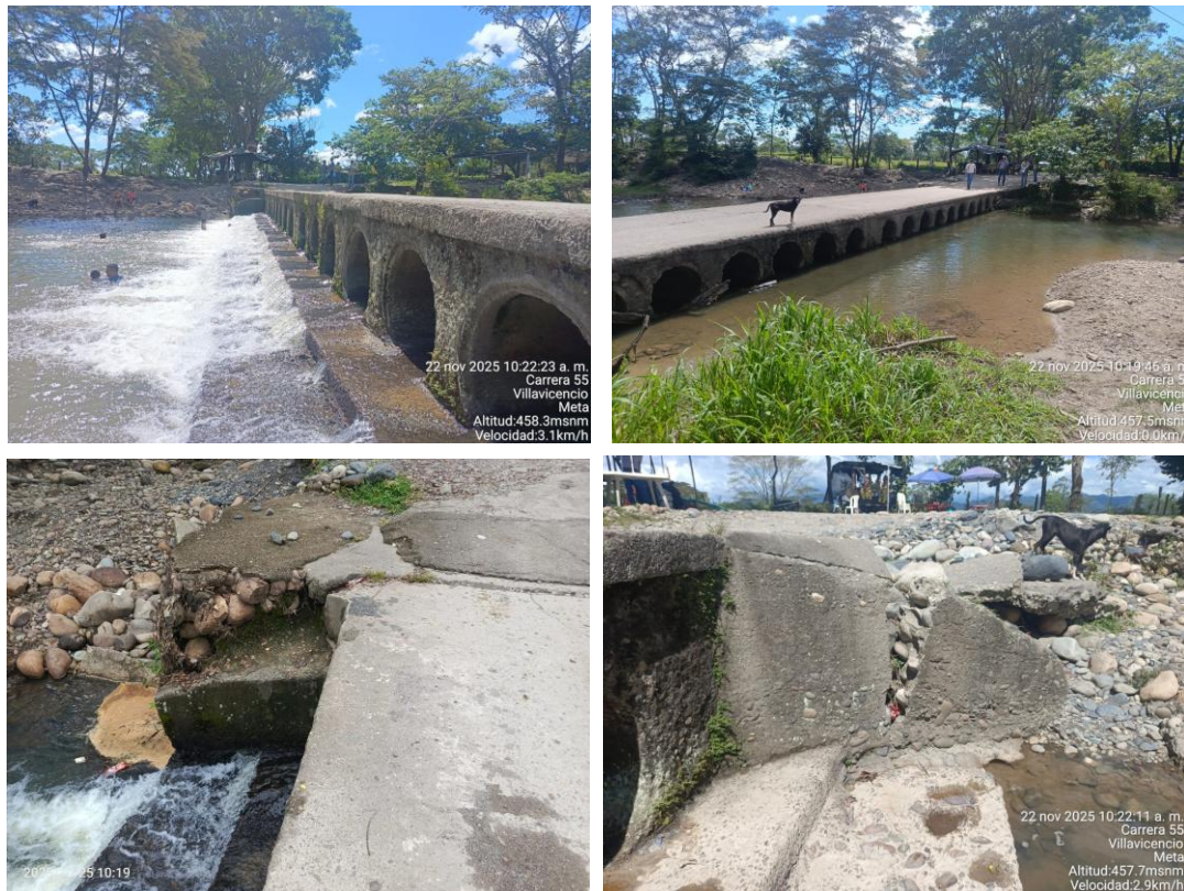
Figura 108. Fotos generales del PV-27
