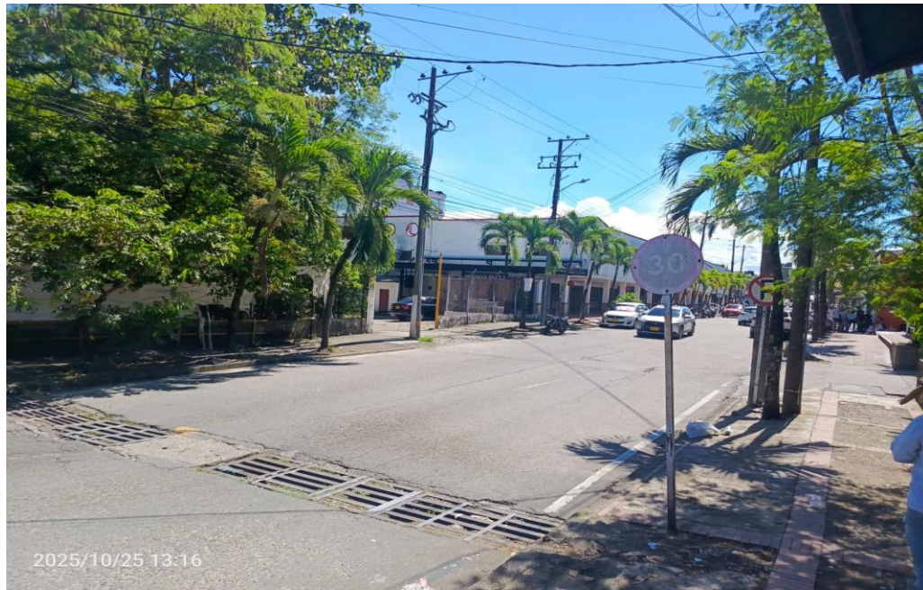
Figura 123. Foto frontal del puente PV-31
