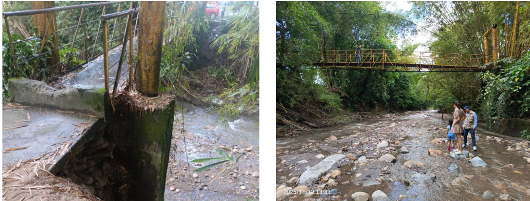
Figura 140. Fotos generales del PV-35
