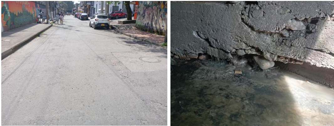
Figura 60. Fotos generales del PV-15
