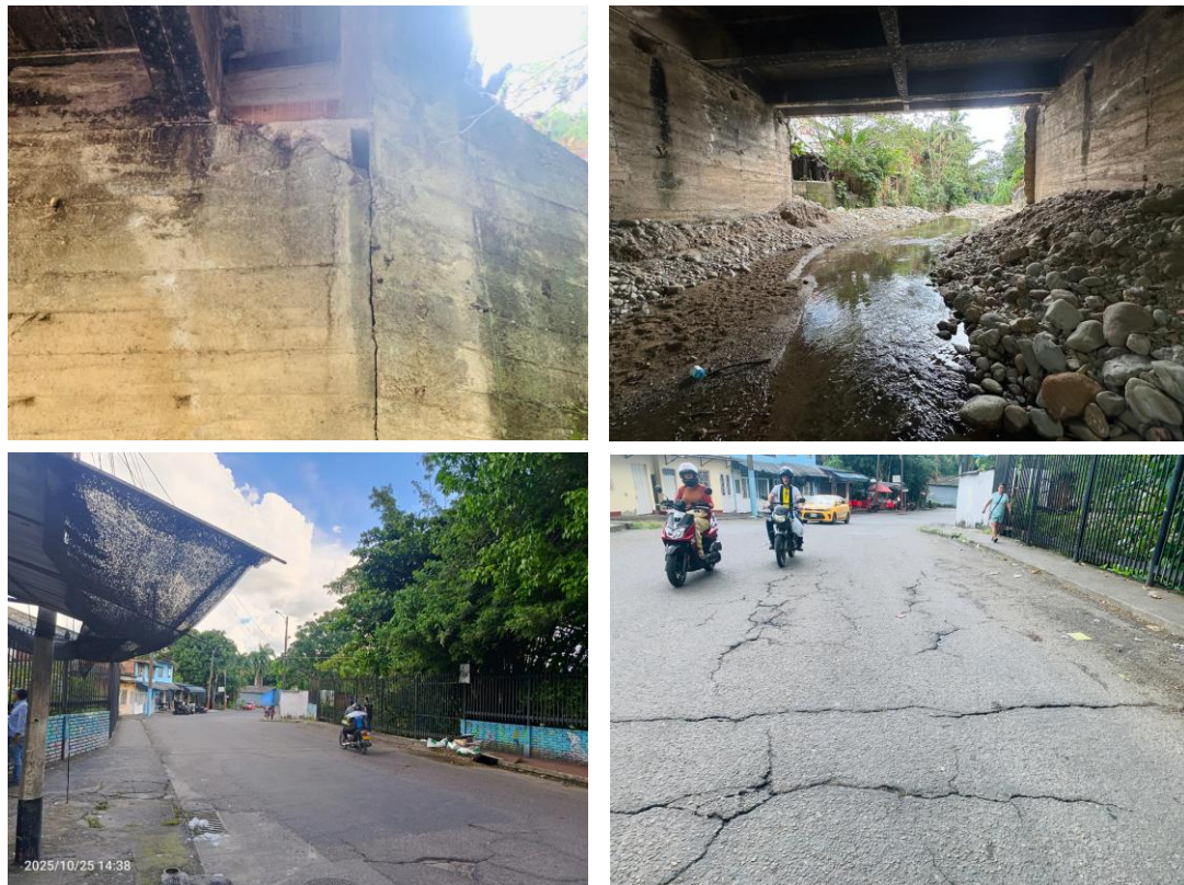
Figura 16. Fotos generales del PV-4
