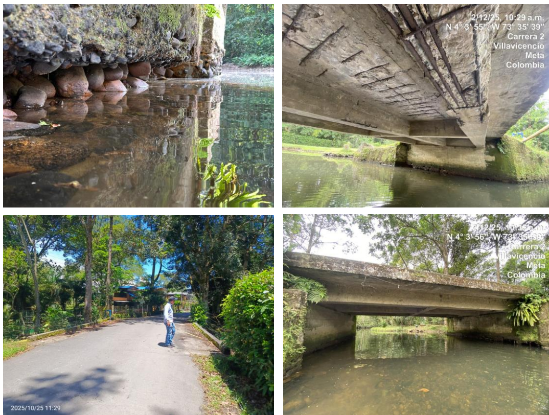
Figura 112. Fotos generales del PV-28
