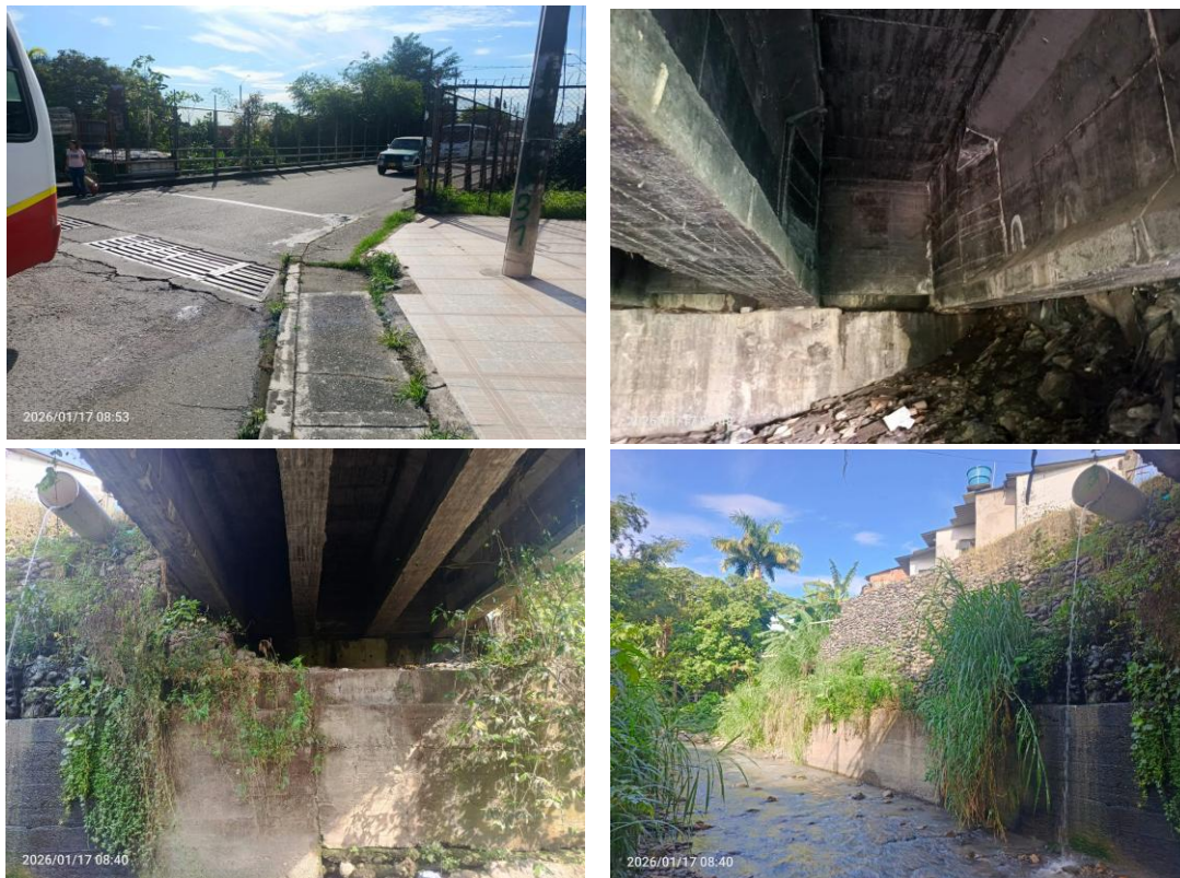
Figura 52. Fotos generales del PV-13
