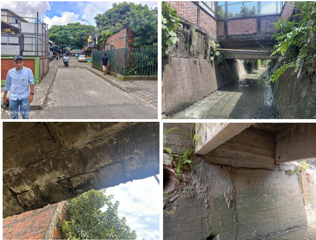
Figura 68. Fotos generales del PV-17
