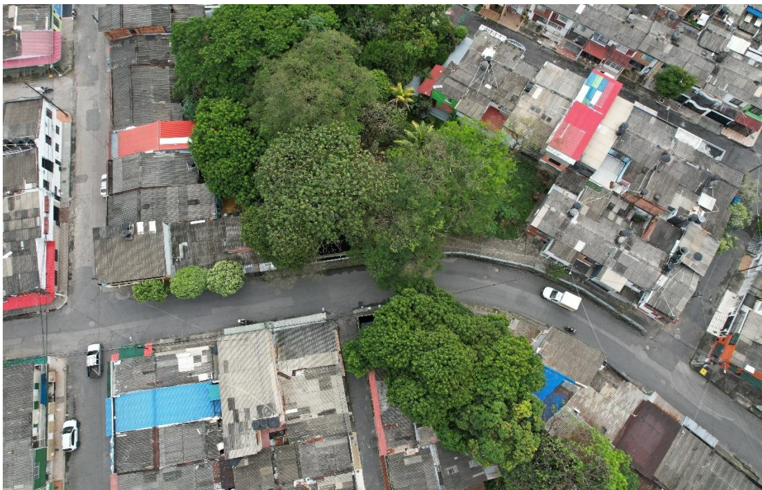
Figura 115. Foto aérea del puente PV-29
