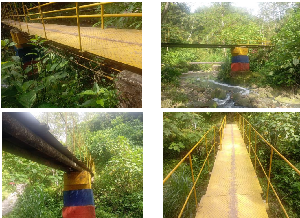
Figura 148. Fotos generales del PV-39
