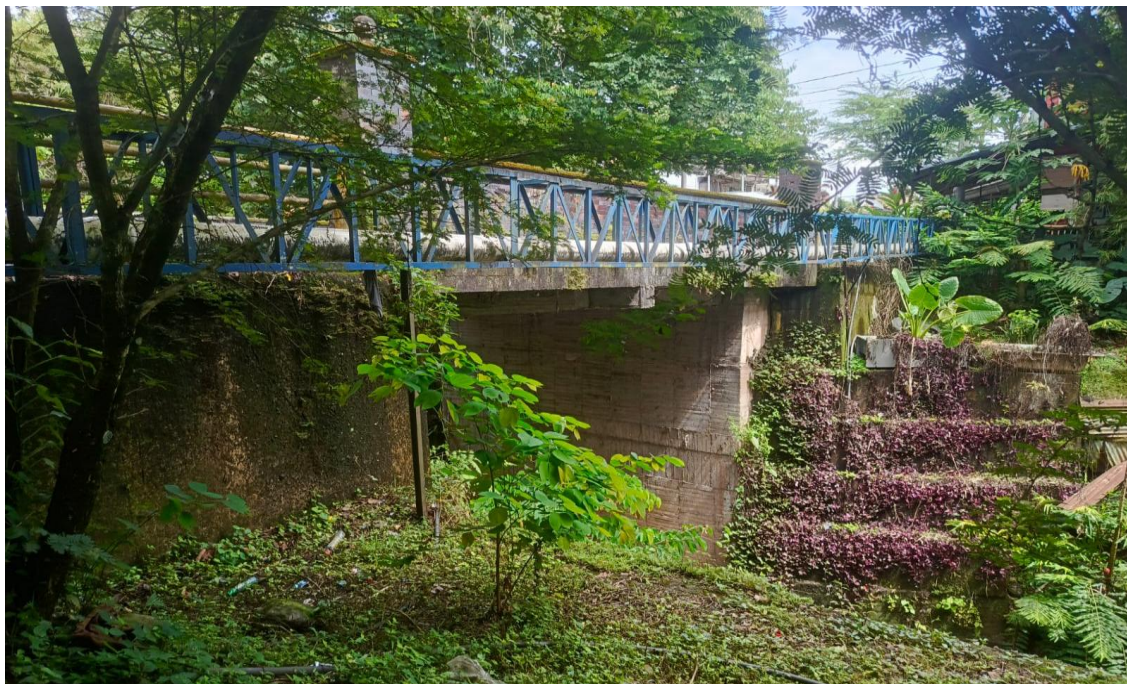
Figura 83. Foto frontal del puente PV-21
