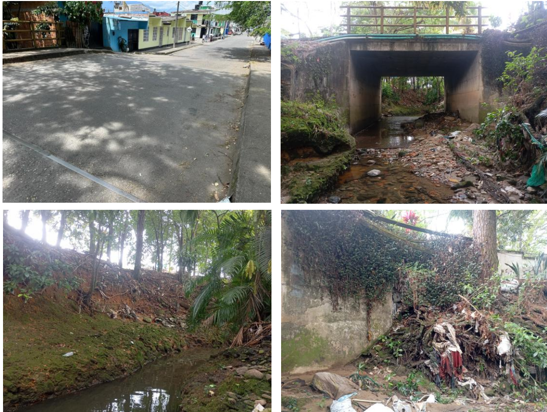
Figura 120. Fotos generales del PV-30
