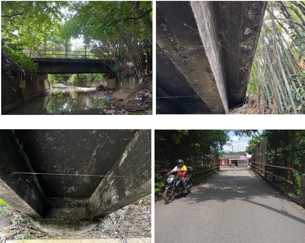
Figura 28. Fotos generales del PV-7
