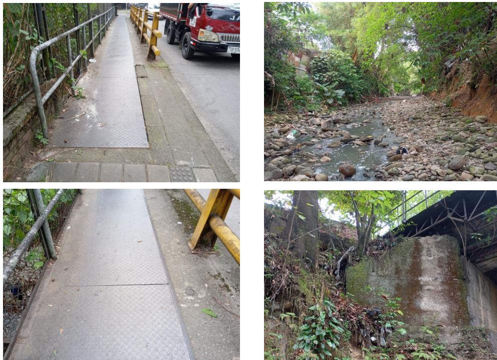
Figura 152. Fotos generales del PV-40
