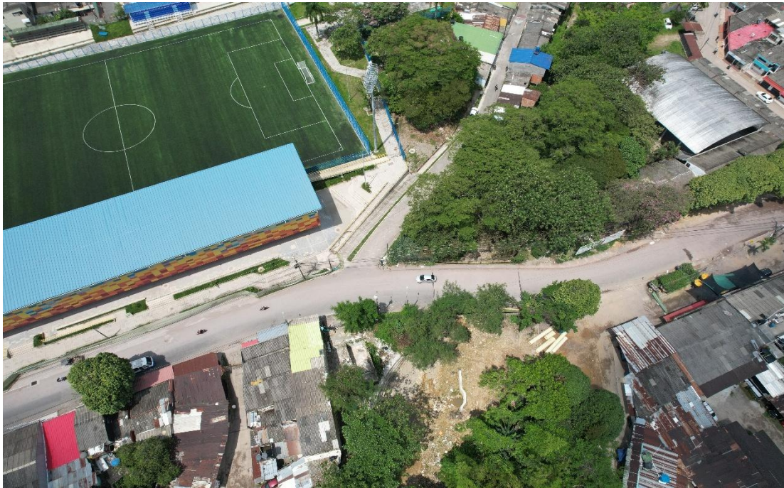
Figura 90. Foto aérea del puente PV-23
