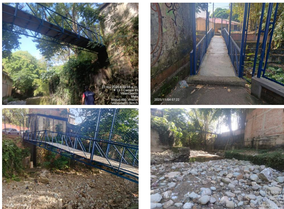
Figura 156. Fotos generales del PV-41
