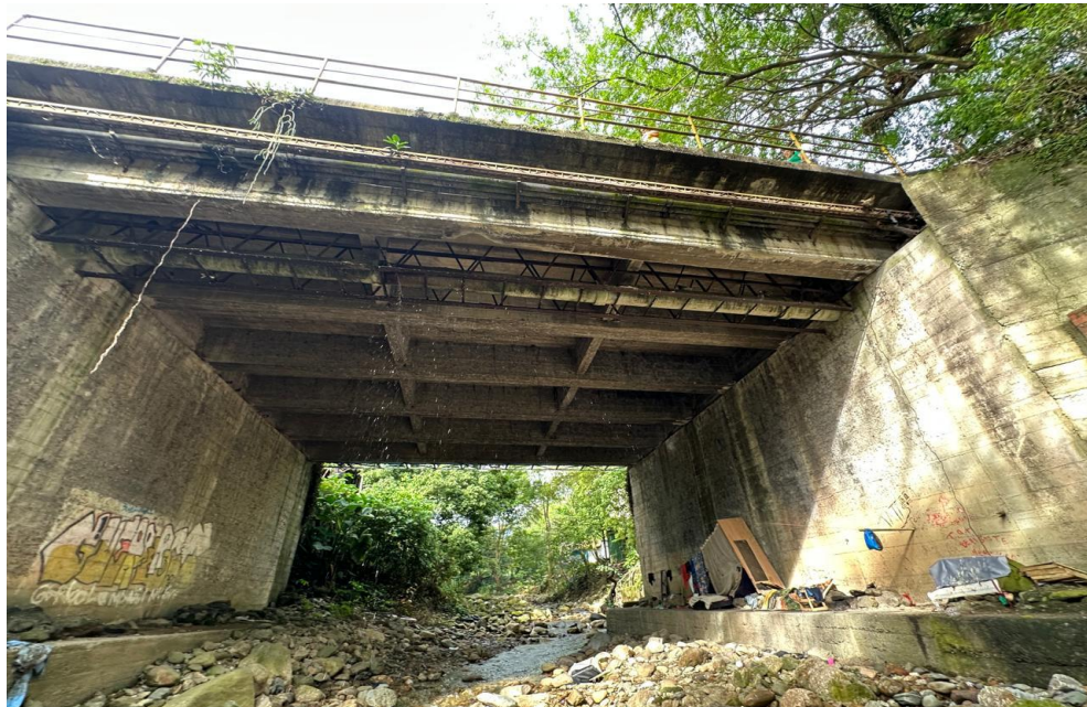
Figura 7. Foto frontal del puente PV-2
