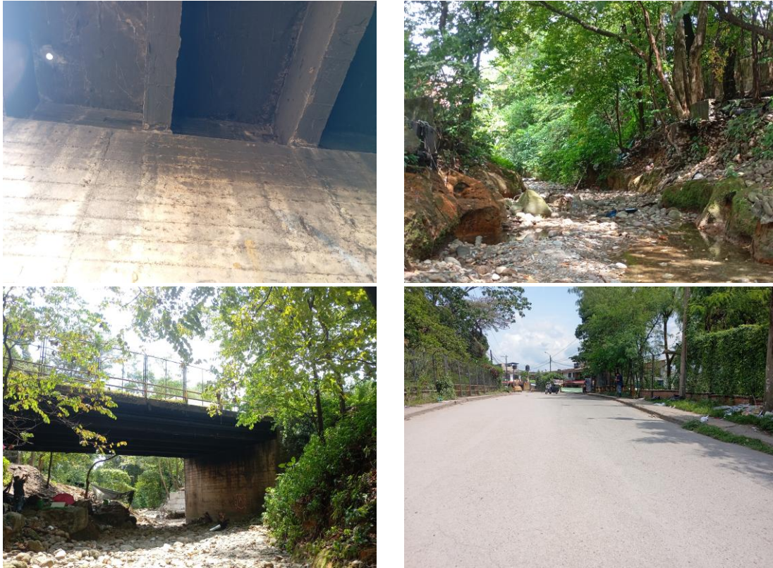
Figura 91. Fotos generales del PV-22
