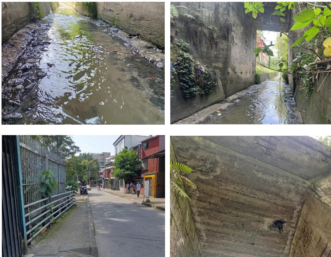
Figura 56. Fotos generales del PV-14
