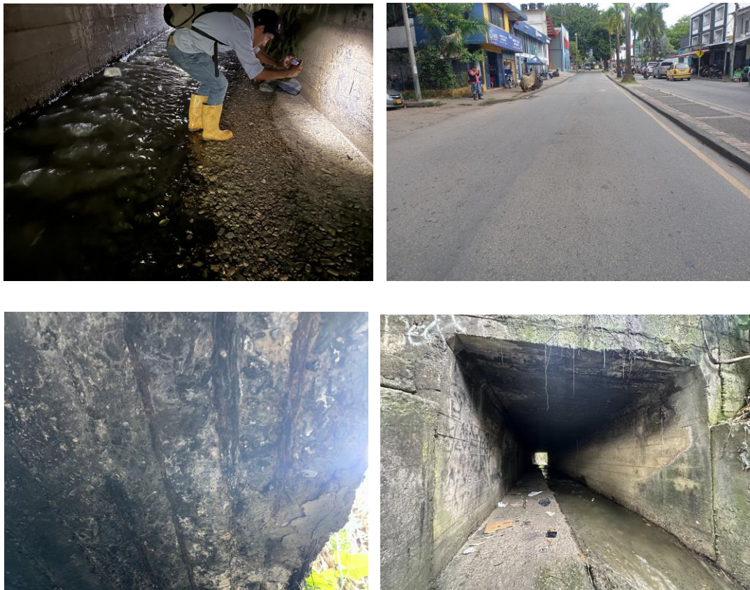
Figura 64. Fotos generales del PV-16
