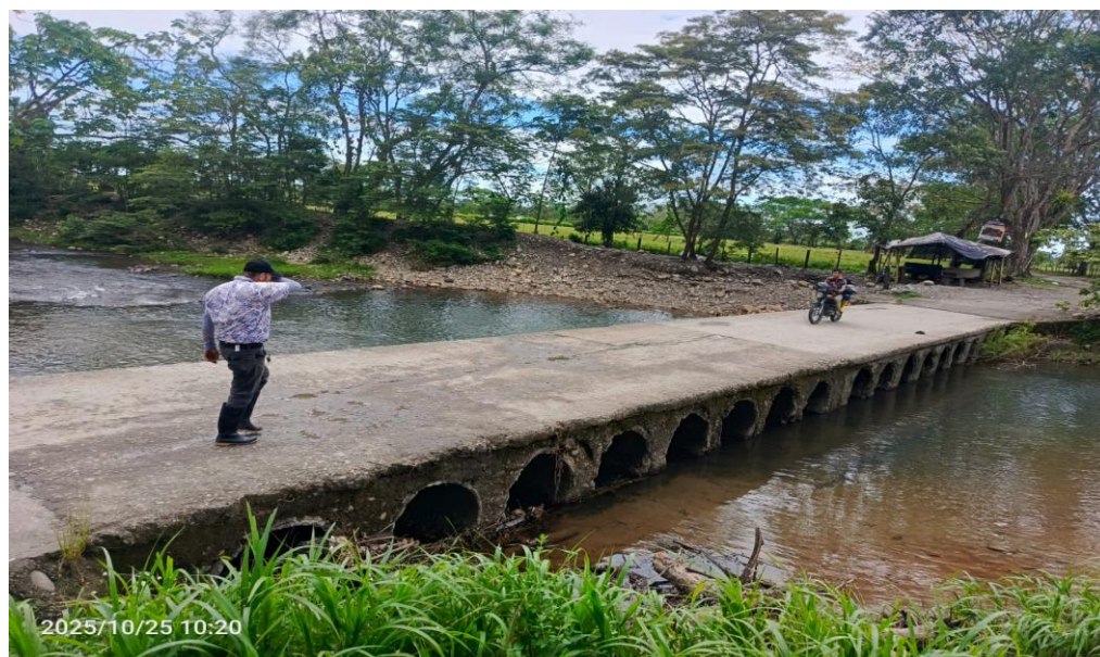
Figura 107. Foto frontal del puente PV-27
