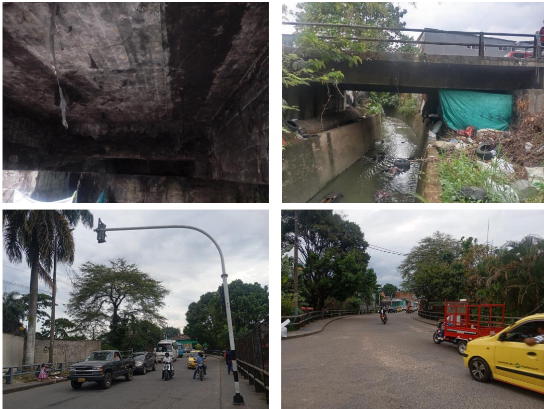
Figura 76. Fotos generales del PV-19
