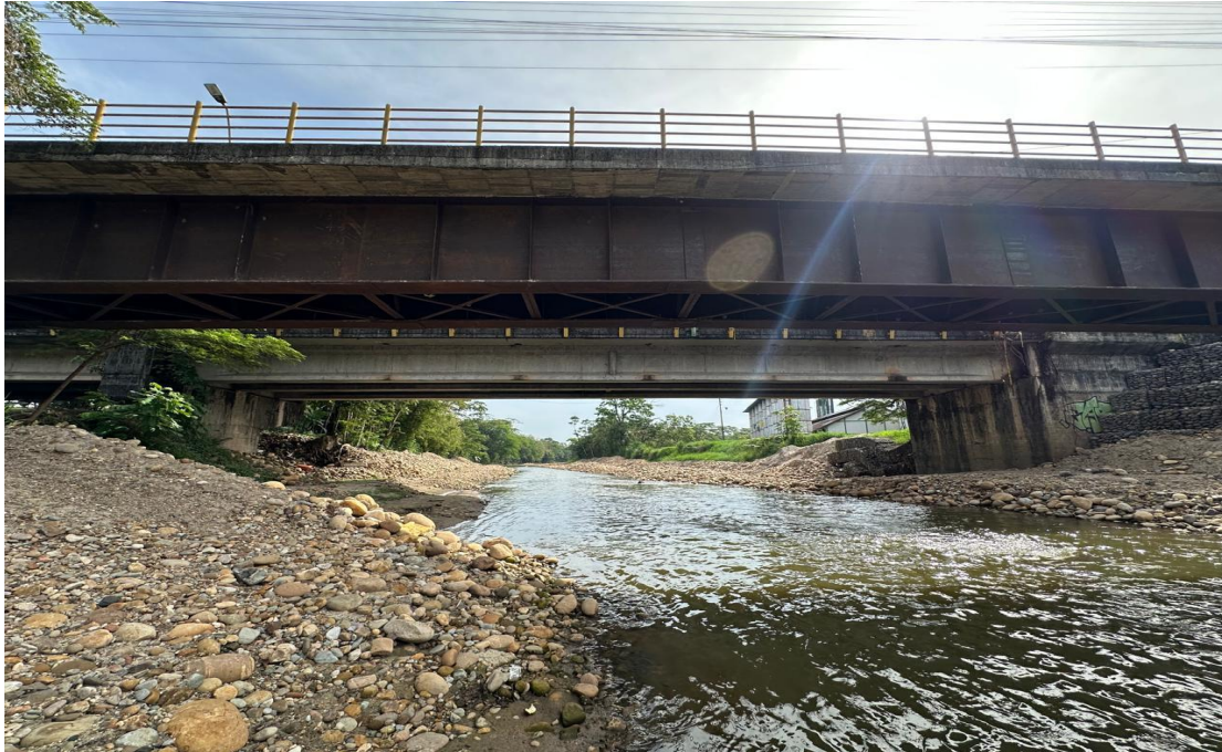
Figura 94. Foto frontal del puente PV-24
