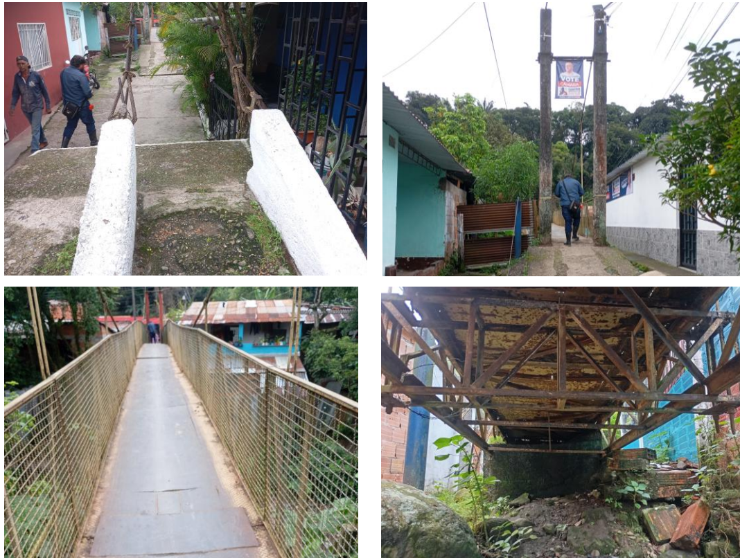
Figura 132. Fotos generales del PV-33
