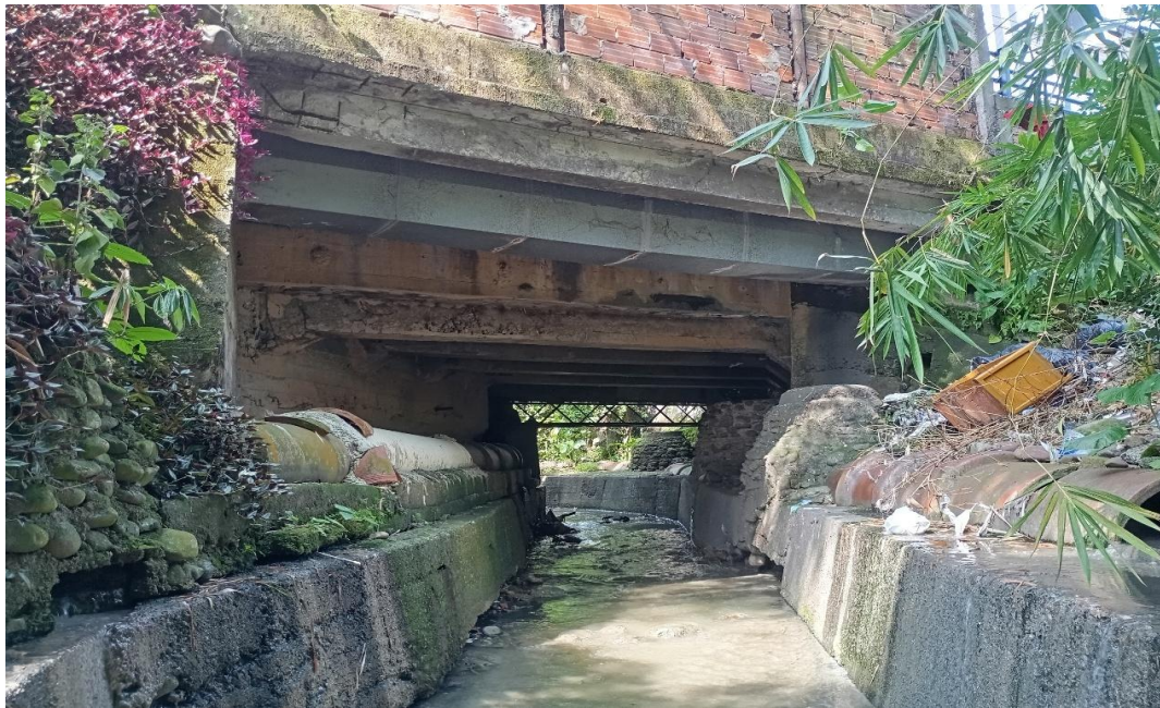
Figura 59. Foto frontal del puente PV-15
