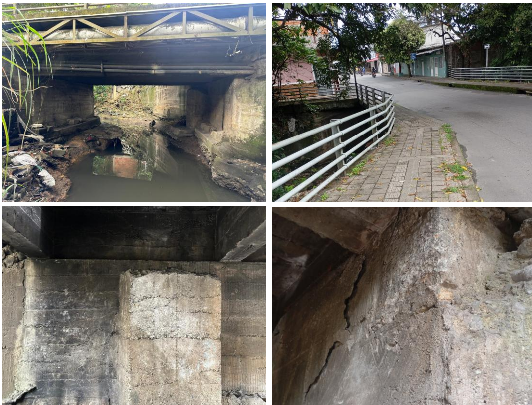
Figura 116. Fotos generales del PV-29
