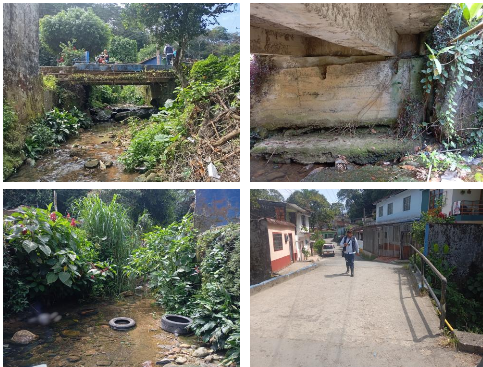
Figura 80. Fotos generales del PV-20
