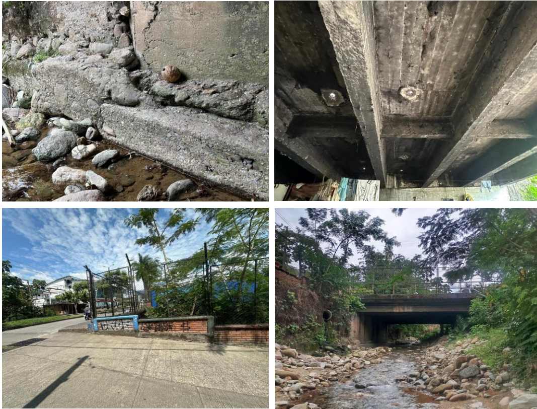
Figura 4. Fotos generales del PV-1
