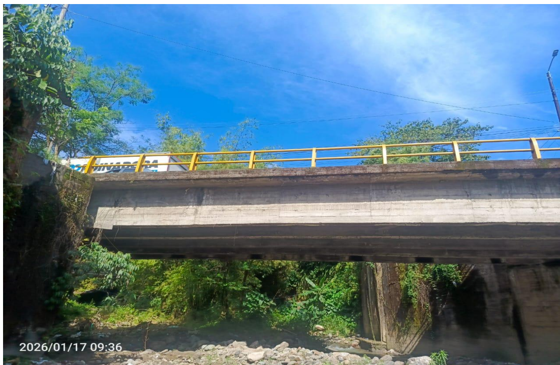
Figura 43. Foto frontal del puente PV-11
