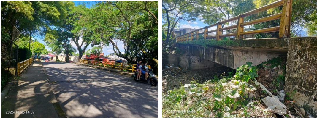
Figura 24. Fotos generales del PV-6
