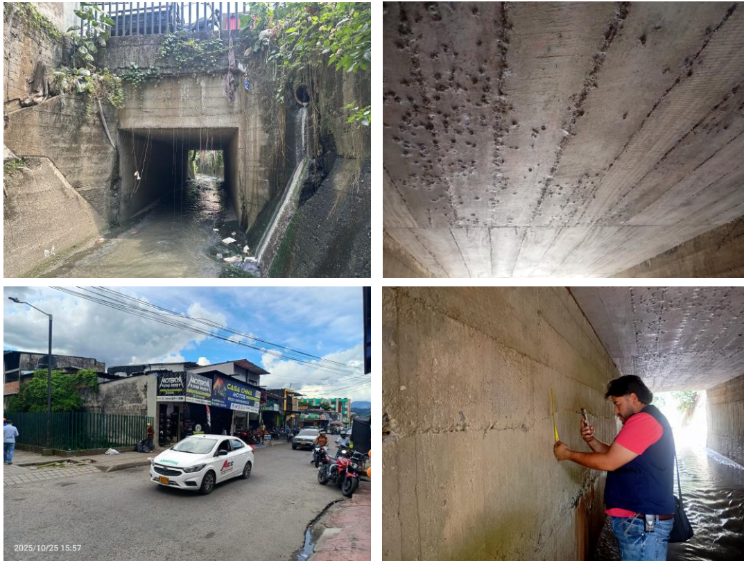
Figura 72. Fotos generales del PV-18
