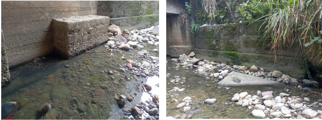
Figura 32. Fotos generales del PV-8
