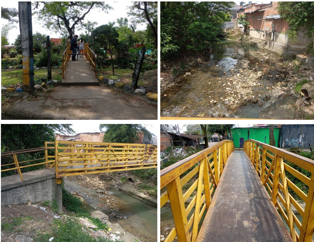
Figura 160. Fotos generales del PV-42
