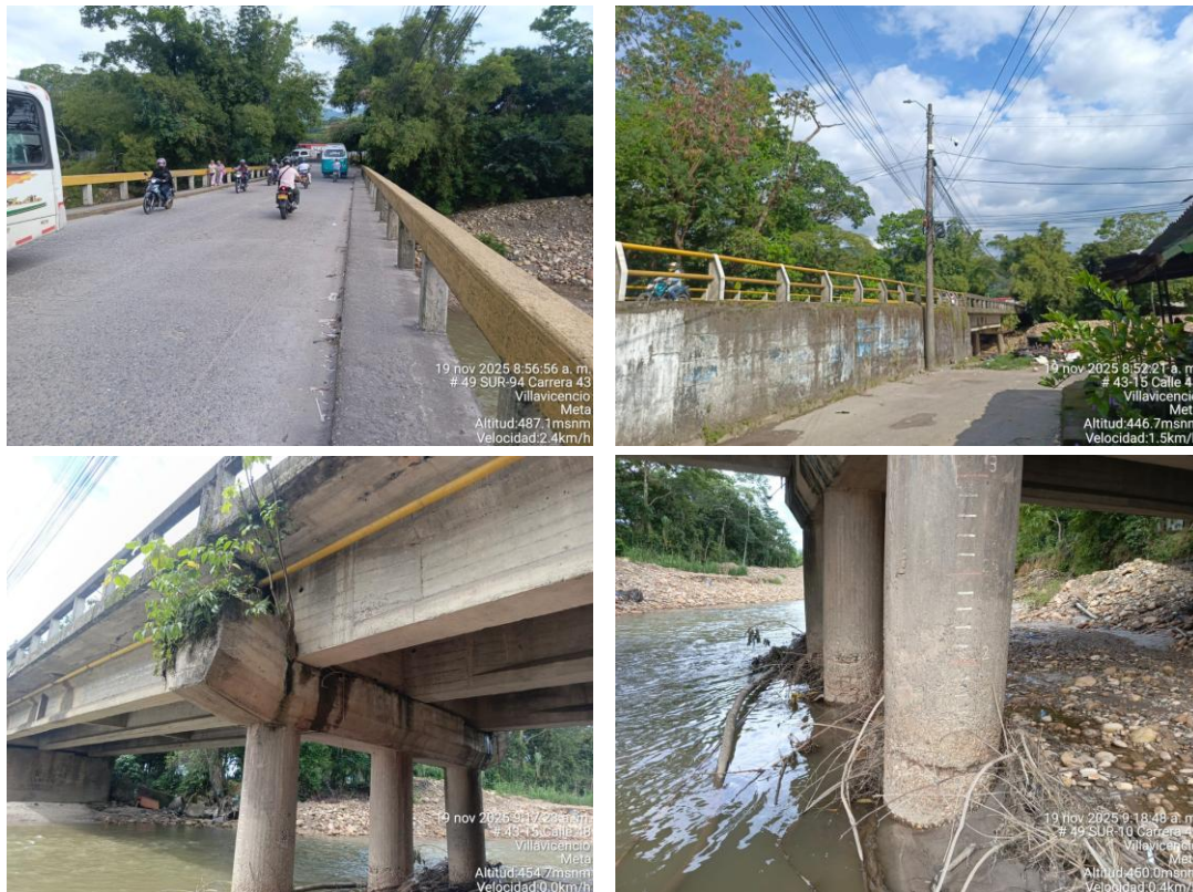
Figura 100. Fotos generales del PV-25
