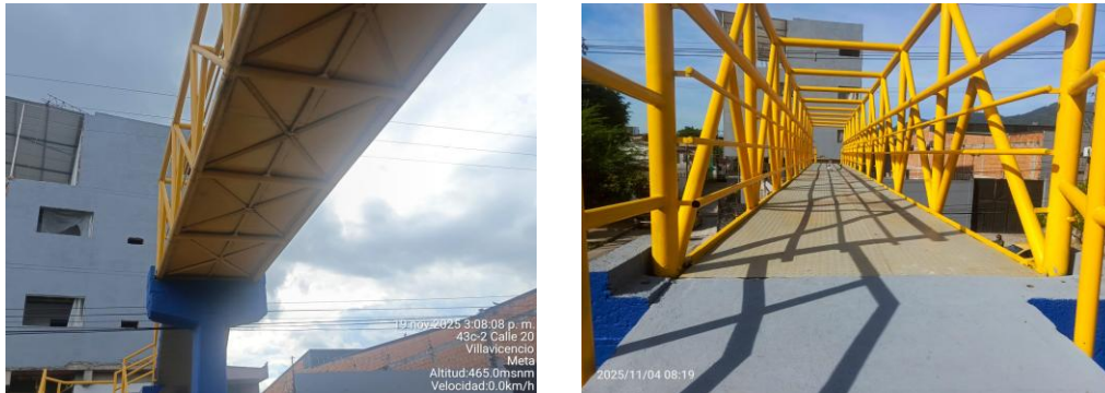
Figura 144. Fotos generales del PV-36
