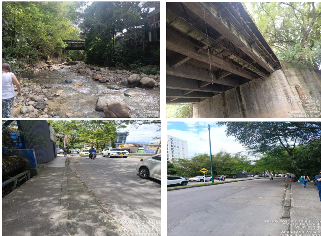
Figura 8. Fotos generales del PV-2
