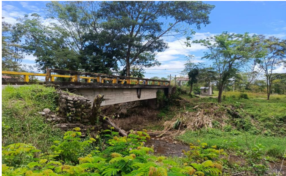
Figura 103. Foto frontal del puente PV-26
