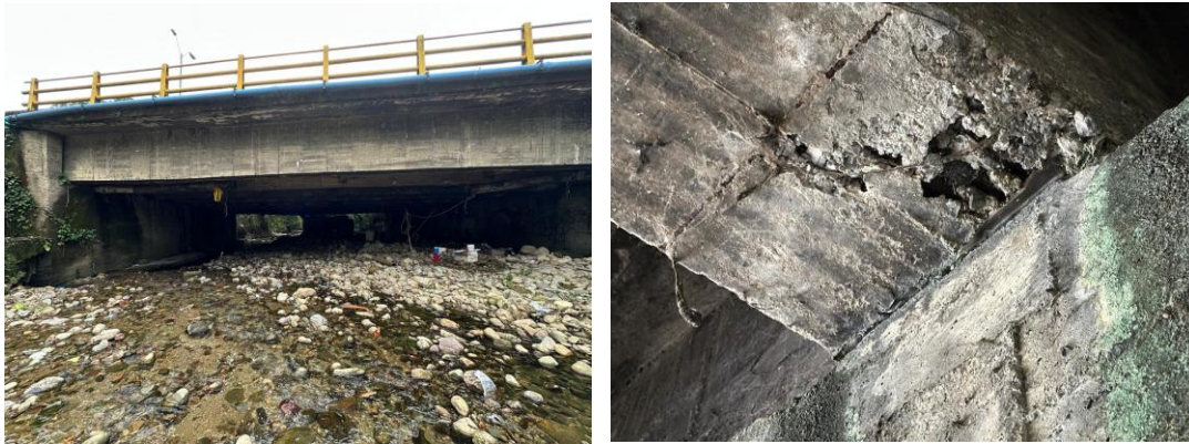
Figura 20. Fotos generales del PV-5
