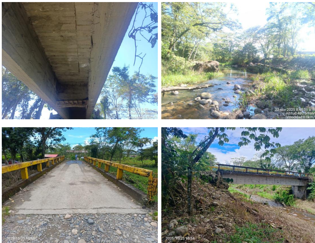
Figura 104. Fotos generales del PV-26
