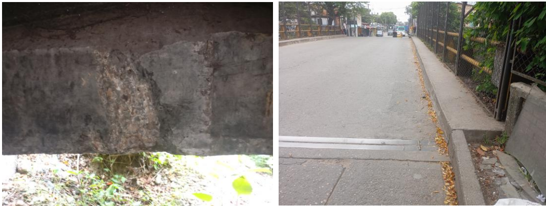
Figura 36. Fotos generales del PV-9
