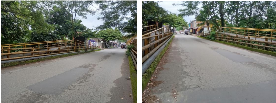
Figura 128. Fotos generales del PV-32
