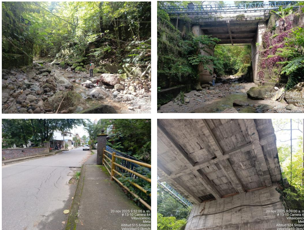
Figura 84. Fotos generales del PV-21
