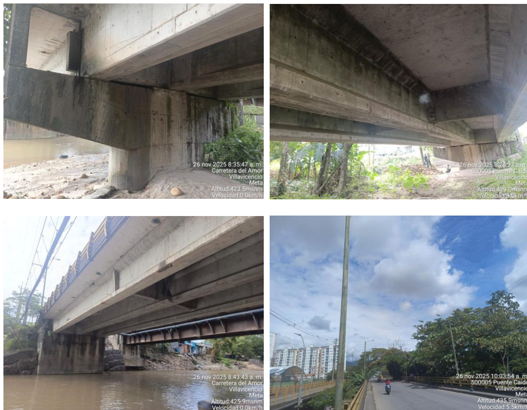
Figura 95. Fotos generales del PV-24
