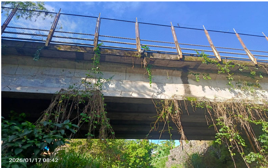
Figura 51. Foto frontal del puente PV-13
