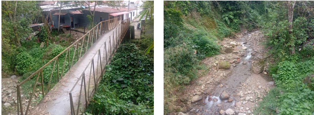
Figura 136. Fotos generales del PV-34
