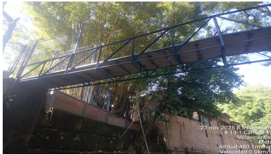
Figura 155. Foto del puente PP-41
