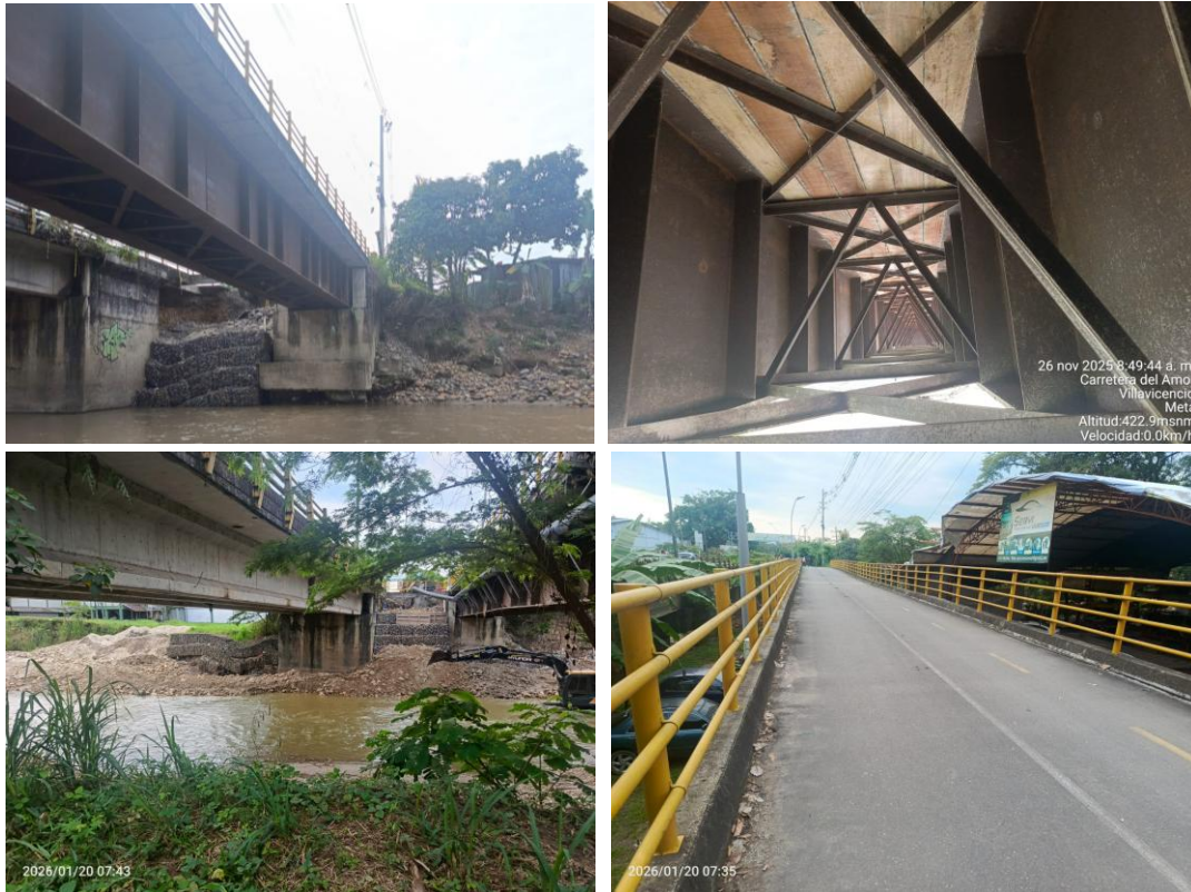
Figura 96. Fotos generales del PV-24
