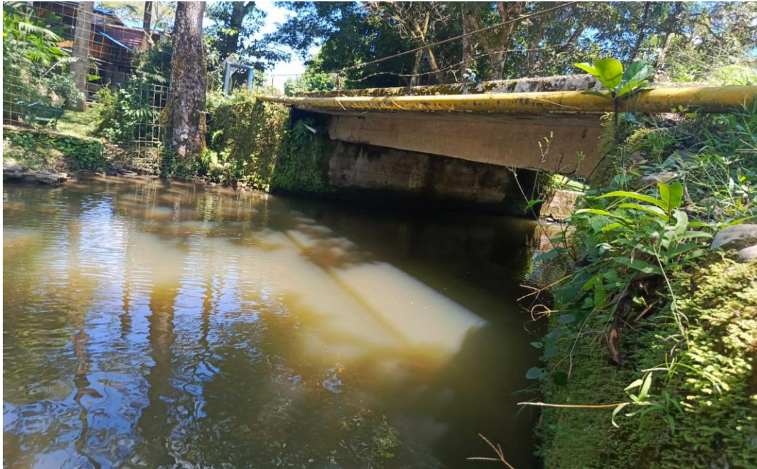
Figura 111. Foto frontal del puente PV-28
