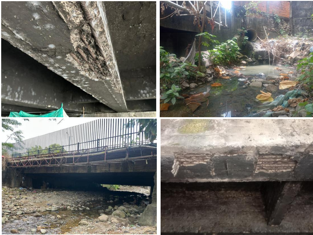
Figura 12. Fotos generales del PV-3
