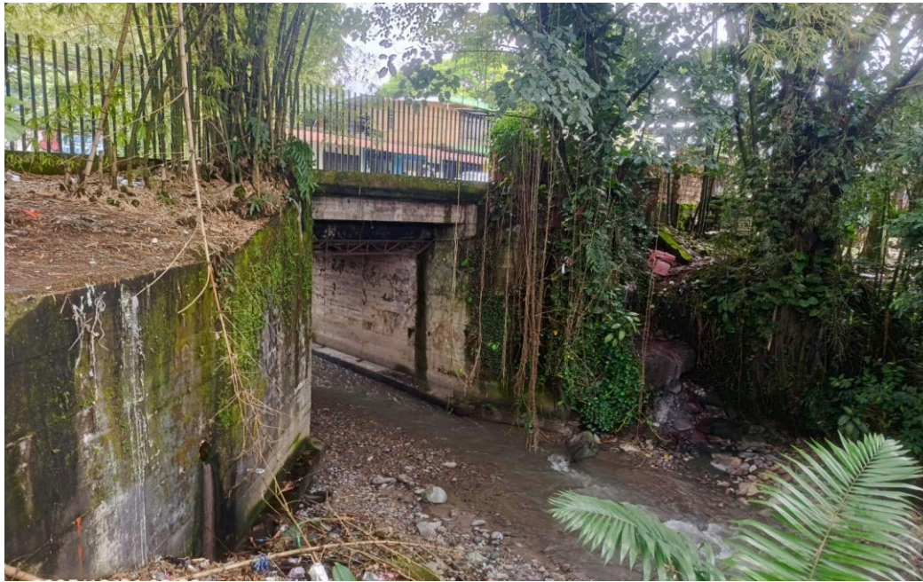
Figura 39. Foto frontal del puente PV-10
