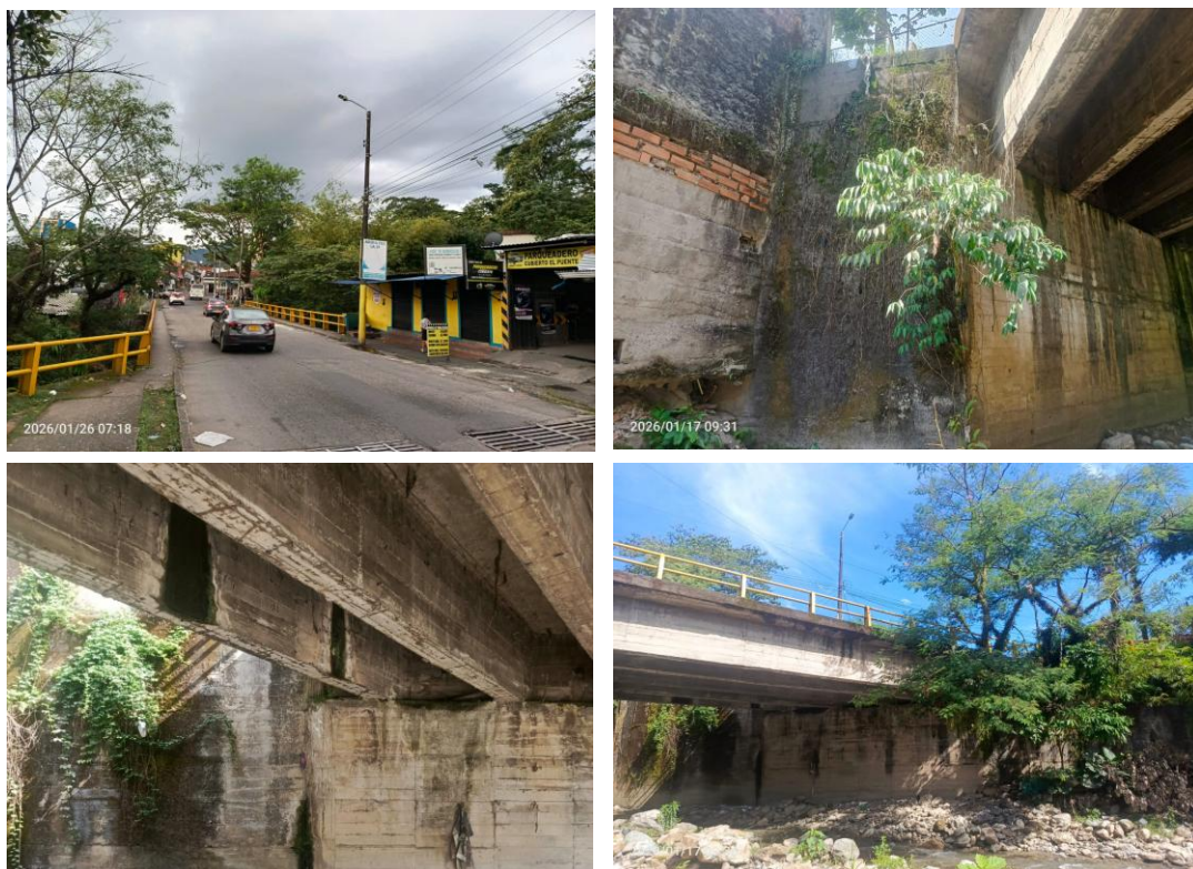
Figura 44. Fotos generales del PV-11
