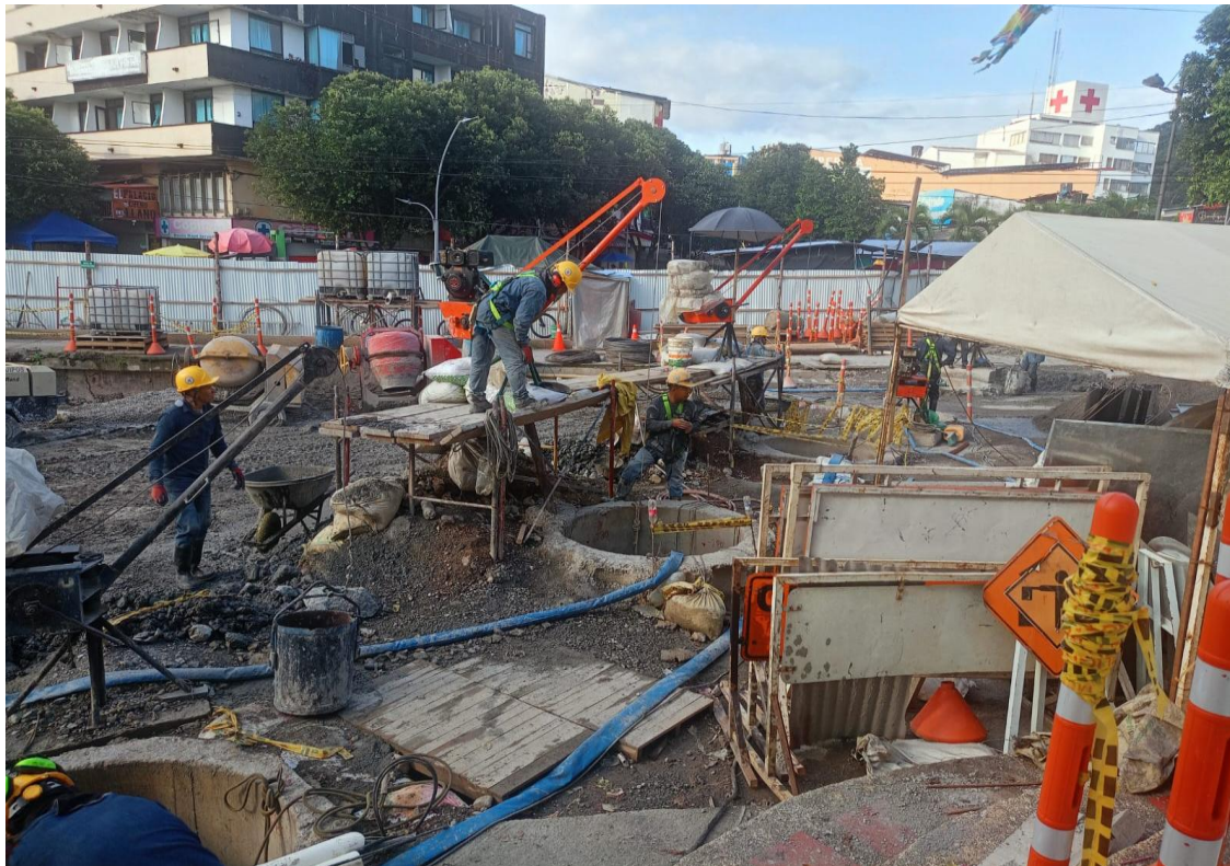
Figura 48. Foto avance de la estructura Villa Julia. Adoptado de: Periodico del Meta, 2026
