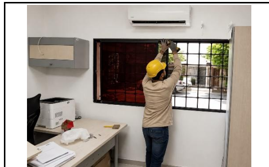
Descripción: Proceso de ejecucion.
