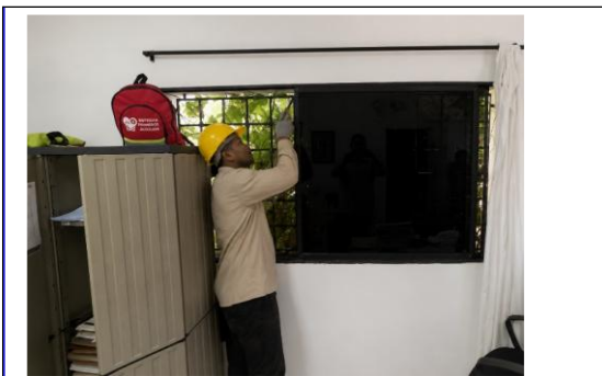
Descripción: Proceso de ejecucion.
