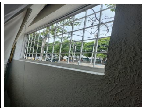
Descripción: Proceso de ejecución.
