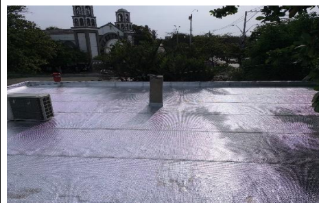
Descripción: Proceso de ejecución.
