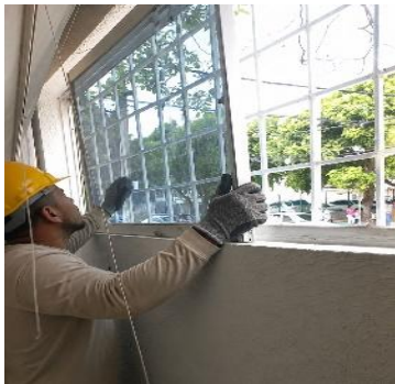
Descripción: Proceso de ejecución.
