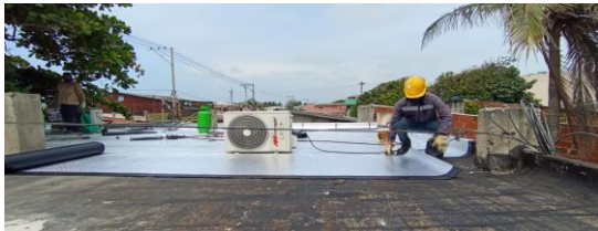
Descripción: Proceso de ejecución.
