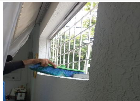
Descripción: Proceso de ejecución.
