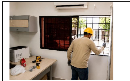
Descripción: Proceso de ejecucion.
