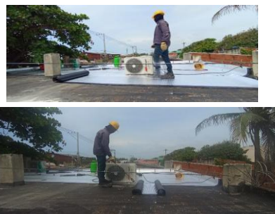
Descripción: Proceso de ejecución.
