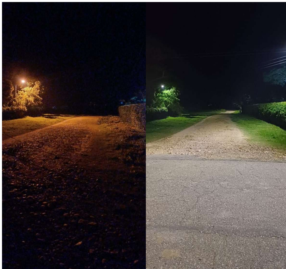
Figura N°17. Foto: Iluminación en sodio y después en LED
