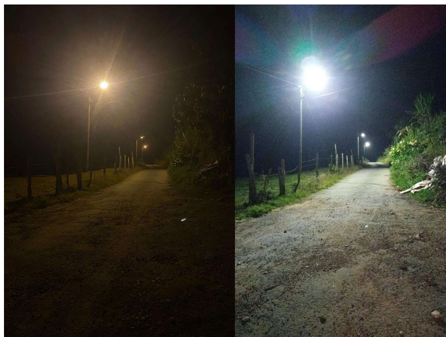
Figura N°16. Foto: Iluminación de calle, ante en sodio y después en LED
