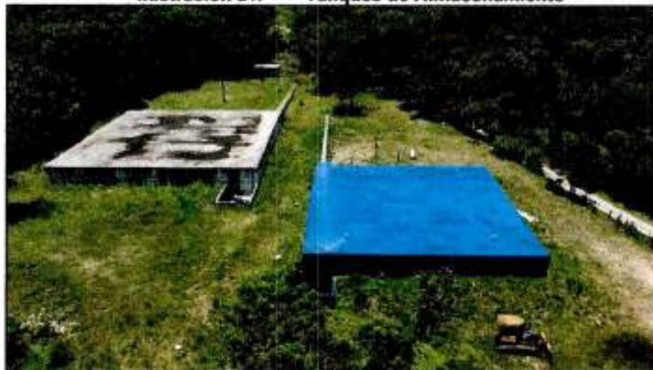
Ilustración 21. Tanques de Almacenamiento
