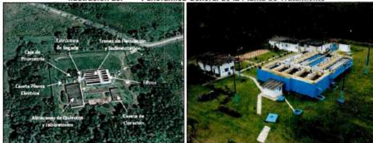
Ilustración 20. Panorámica General de la Planta de Tratamiento
