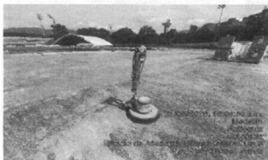
Preparación superficie pista Alfonso Galvis.
