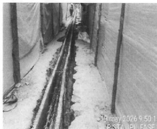
Demolición y construcción viga cerramiento externo fase 3.
