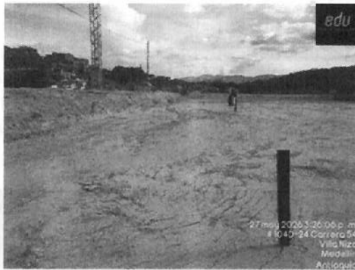
Instalación niveletas Cancha Villa Niza.
