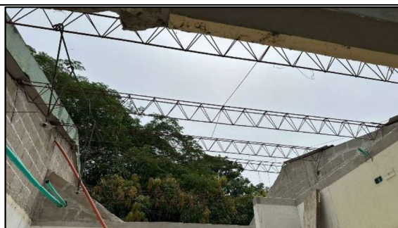
ITEM A3-N. P 39 Desmonte de cubierta en asbesto
