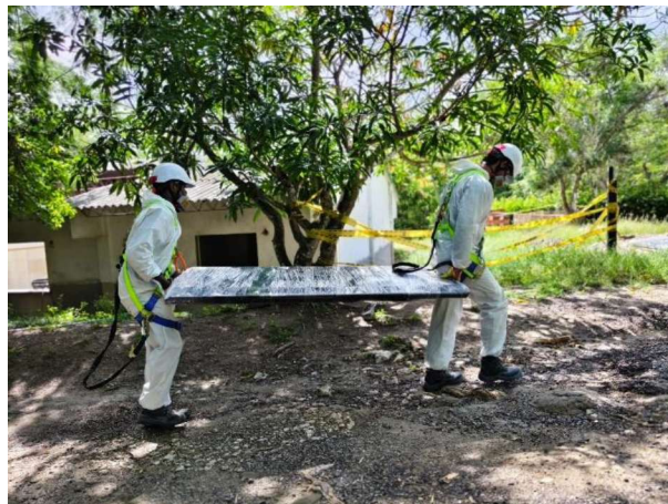
ITEM A3-N. P 39 Desmonte de cubierta en asbesto
