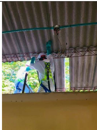
ITEM A3-N. P 39 Desmonte de cubierta en asbesto
