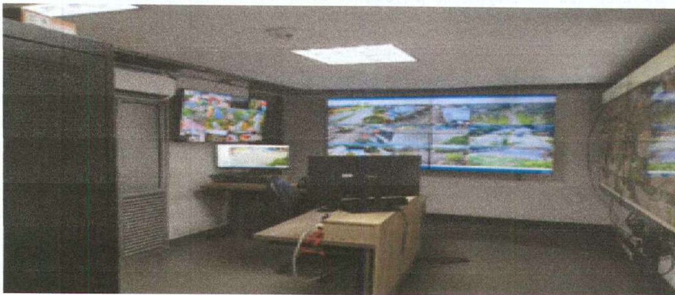
Registro fotográfico del actual centro de monitoreo el cual no cumple con el espacio para la ampliación del sistema de video vigilancia "CCTV"
