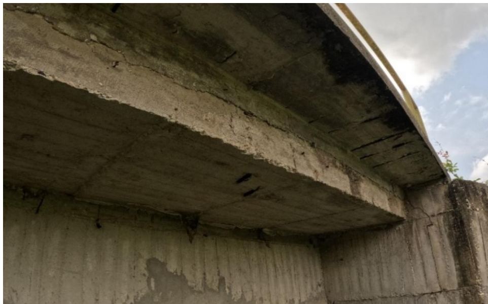
Ilustración 14. Exposición de acero de refuerzo Pontón K1+550
