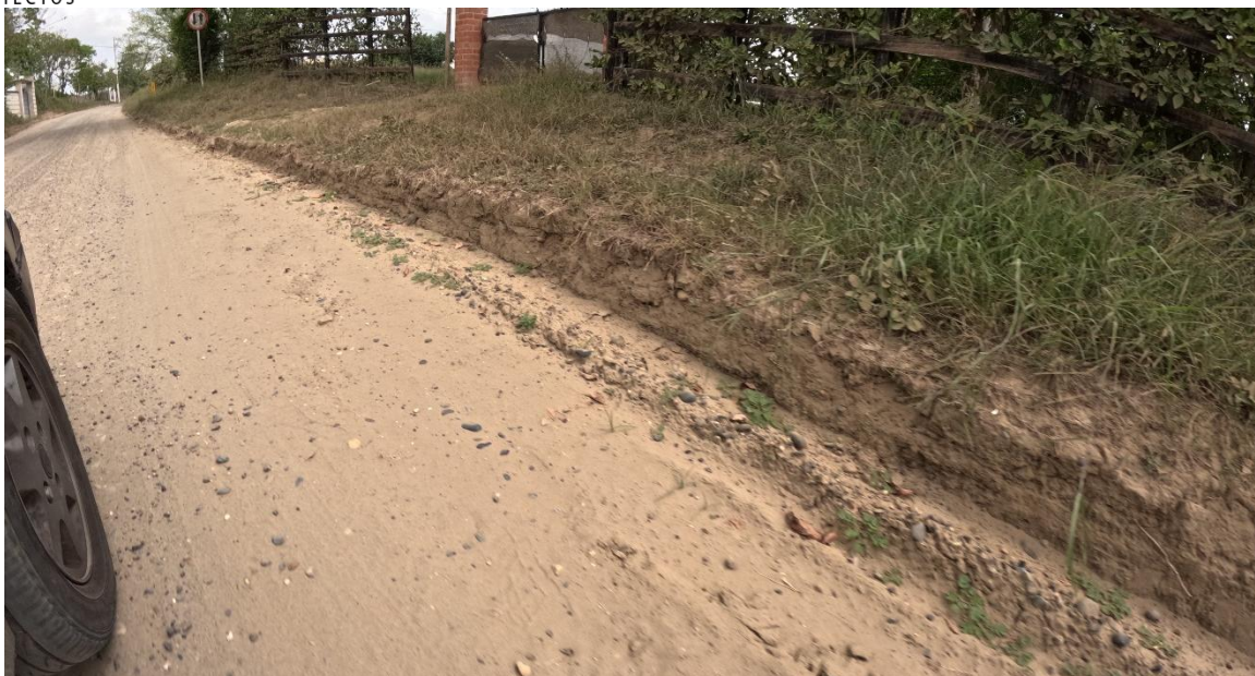
Ilustración 42. Cunetas perfiladas entre K9+200 y K6+400
