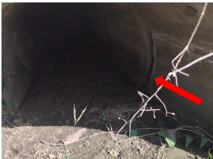
Ilustración 19. Perdida de mortero de pega y juntas entre secciones de la alcantarilla. Alcantarilla K6+937
