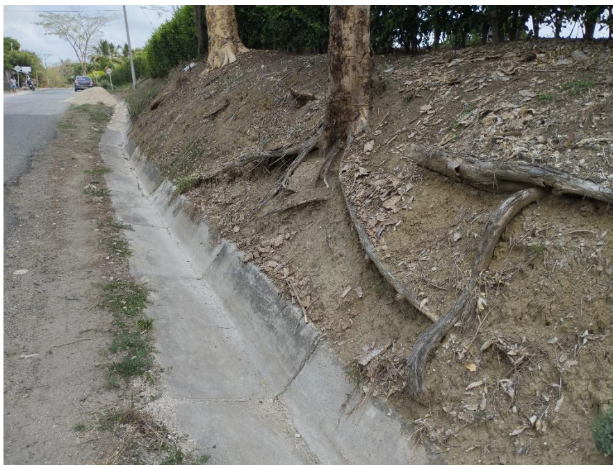
Ilustración 39. Talud entre K9+950 y el K10+150
