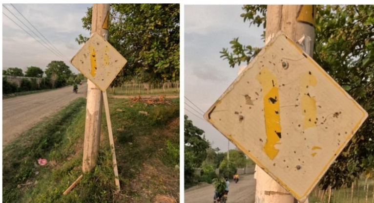
Evidencia 6. Perdida de la película reflectiva señal SP-38. Abscisa K5+970
