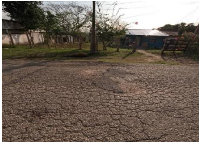
Evidencia 2. Fisura de piel de cocodrilo K9+040
