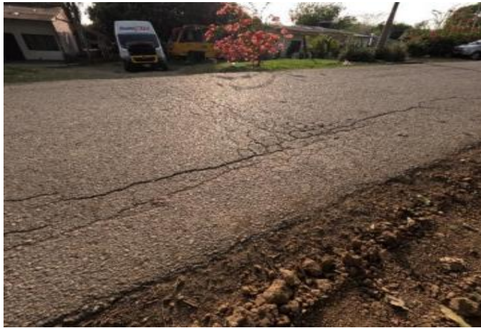
Evidencia 2. Fisura de piel de cocodrilo K9+040
