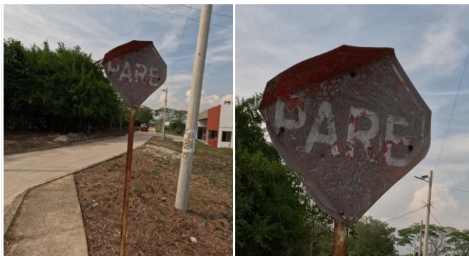
Evidencia 8. Señal con el tablero manchado SR-26. Abscisa: K3+675
