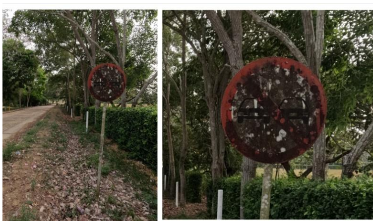
Evidencia 8. Señal con el tablero manchado SR-26. Abscisa: K3+675
