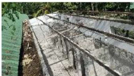
ITEM A3-1.40: Desmonte de canal y/o bajante en cualquier material
