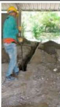
ITEM A3-3.13:Tubería sanitaria PVC 4"
