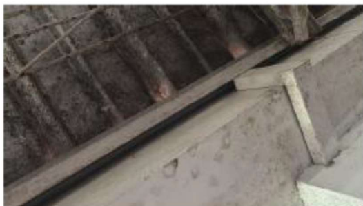
ITEM A3-11.21. Suministro e instalación de canal metálica
