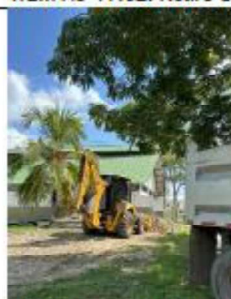
ITEM A3-17.02: Retiro de escombros
