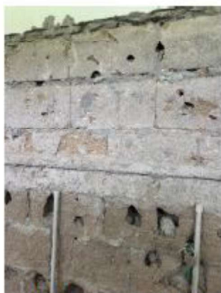
ITEM A3-1.36: Desmonte de pañete
