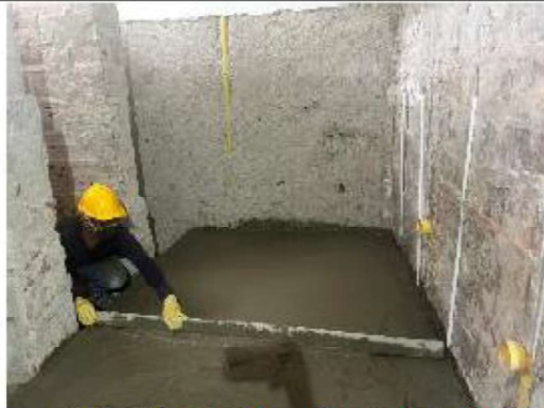
ITEM A3-12.04. Suministro e instalación de concreto Suministro e instalación de concreto 3000 PSI
