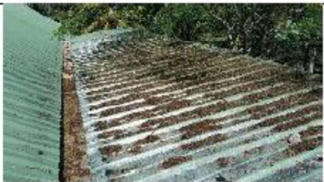
ITEM A3-1.16: Desmonte Cubierta en cualquier material
