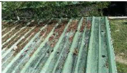
ITEM A3-1.16: Desmonte Cubierta en cualquier material
