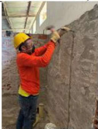
ITEM A3-1.36: Desmonte de pañete
