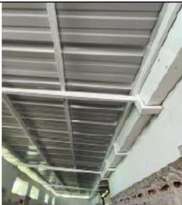
ITEM A3-11.21. Suministro e instalación de canal metálica
