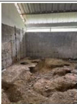
ITEM A3-3.14:Tubería sanitaria PVC 6"
