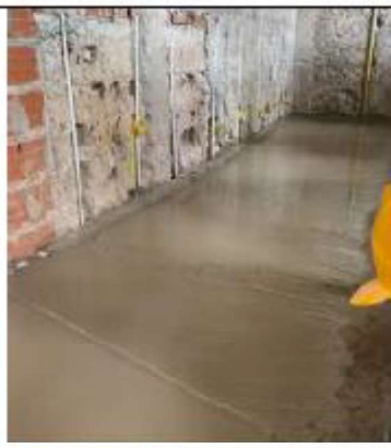
ITEM A3-12.04. Suministro e instalación de concreto Suministro e instalación de concreto 3000 PSI
