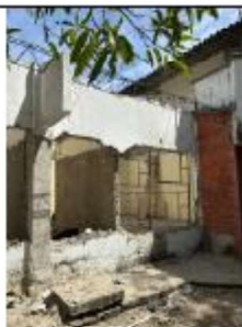
ITEM A3-1.09: Desmonte de muro en bloque
