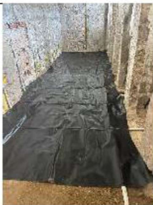
ITEM A3-12.36. Suministro e instalación de malla electrosoldada
