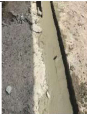
ITEM A3-6.22: Viga de cemento
