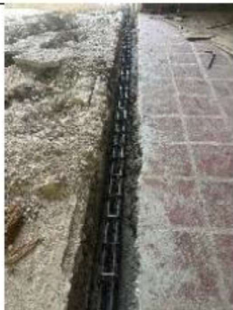
ITEM A3-6.22: Viga de cemento
