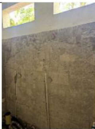
ITEM A3-1.36: Desmonte de pañete
