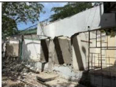
ITEM A3-1.09: Desmonte de muro en bloque
