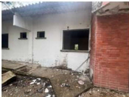
ITEM A3-1.09: Desmonte de muro en bloque
