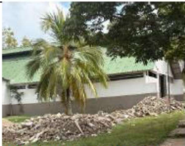
ITEM A3-17.02: Retiro de escombros
