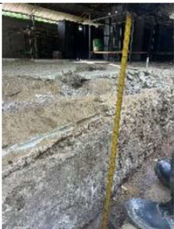
ITEM A3-1.05: Excavación manual
