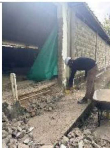
ITEM A3-1.05: Excavación manual
