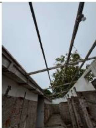
ITEM A3-1.16: Desmonte Cubierta en cualquier material
