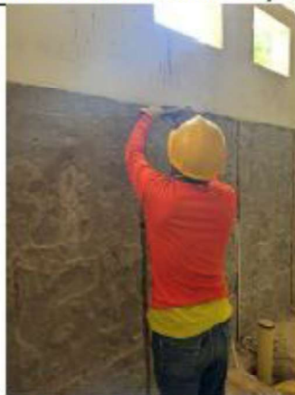
ITEM A3-1.36: Desmonte de pañete
