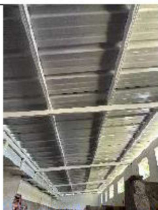
ITEM A3-2.07. Suministro e instalación de cubierta arquitectónica
