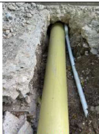
ITEM A3-3.14: Tubería sanitaria PVC 6"
