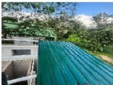
ITEM A3-2.07. Suministro e instalación de cubierta arquitectónica
