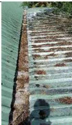
ITEM A3-1.40: Desmonte de canal y/o bajante en cualquier material
