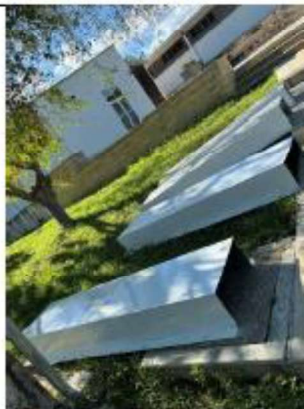
ITEM A3-11.21. Suministro e instalación de canal metálica
