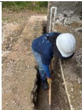
ITEM A3-1.05: Excavación manual
