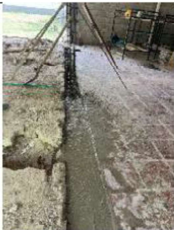
ITEM A3-6.22: Viga cimienta
