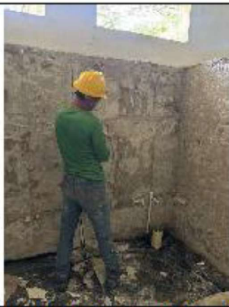
ITEM A3-1.36: Desmonte de pañete
