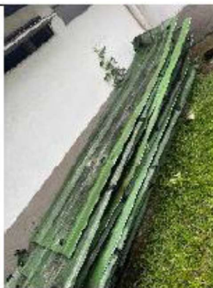
ITEM A3-1.16: Desmonte Cubierta en cualquier material
