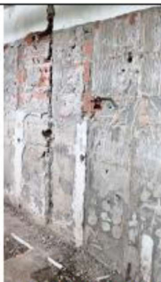
ITEM A3-1.36: Desmonte de pañete
