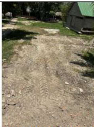
ITEM A3-17.02: Retiro de escombros
