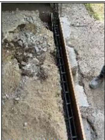
ITEM A3-6.22: Viga cimienta
