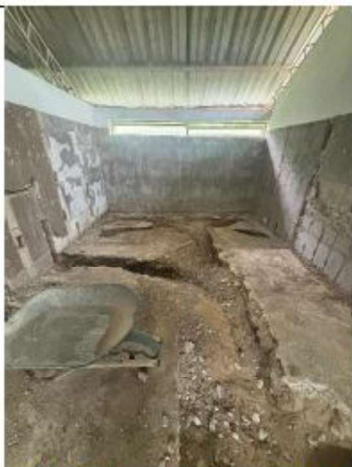
ITEM A3-3.13:Tubería sanitaria PVC 4"
