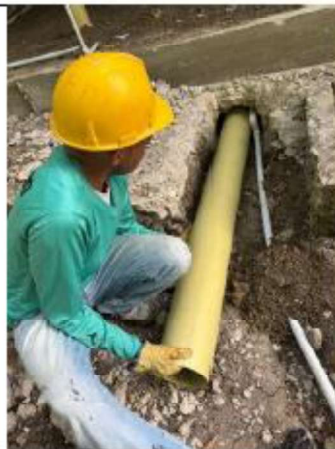
ITEM A3-3.14: Tubería sanitaria PVC 6"
