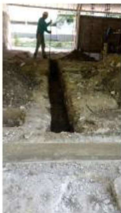
ITEM A3-3.14: Tubería sanitaria PVC 6"
