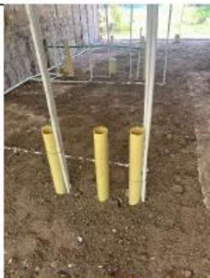
ITEM A3-3.13:Tubería sanitaria PVC 4"
