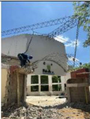
ITEM A3-1.09: Desmonte de muro en bloque
