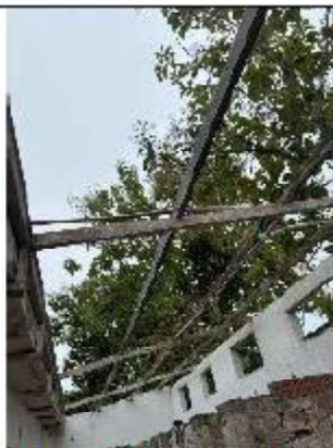
ITEM A3-1.16: Desmonte Cubierta en cualquier material
