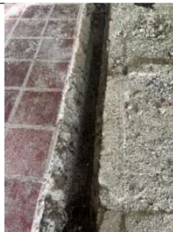
ITEM A3-1.05: Excavación manual
