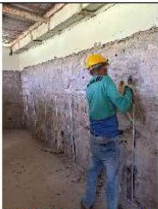
ITEM A3-1.36: Desmonte de pañete
