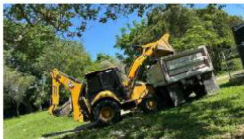
ITEM A3-17.02: Retiro de escombros
