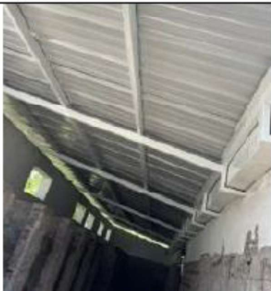
ITEM A3-11.21. Suministro e instalación de canal metálica
