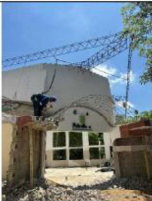
ITEM A3-1.09: Desmonte de muro en bloque
