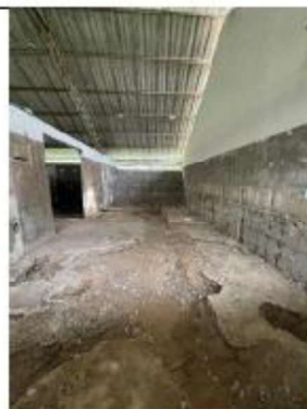
ITEM A3-3.30: Punto de agua fría
