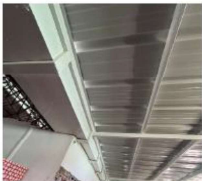
ITEM A3-11.21. Suministro e instalación de canal metálica
