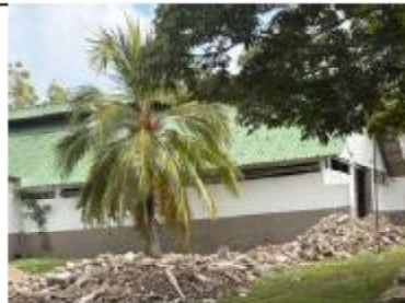
ITEM A3-17.02: Retiro de escombros
