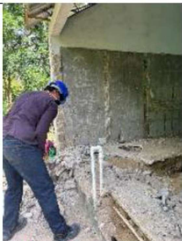
ITEM A3-1.05: Excavación manual
