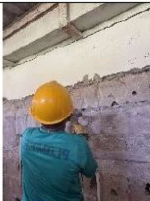
ITEM A3-1.36: Desmonte de pañete
