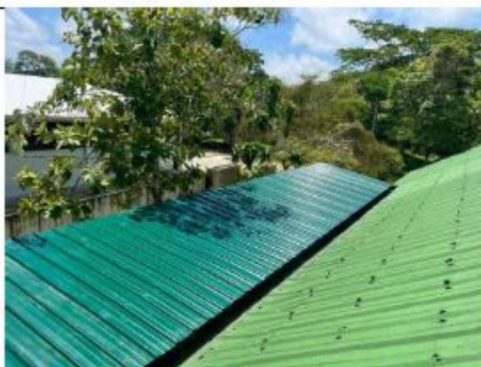
ITEM A3-2.07. Suministro e instalación de cubierta arquitectónica
