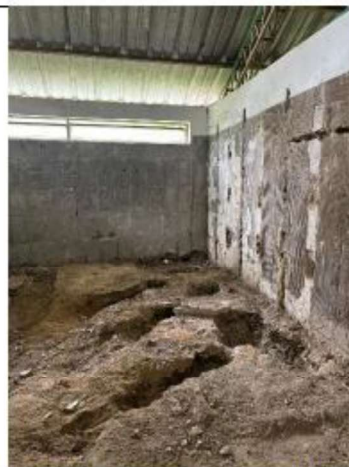
ITEM A3-3.13:Tubería sanitaria PVC 4"
