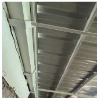
ITEM A3-11.21. Suministro e instalación de canal metálica
