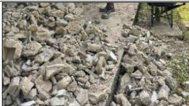
ITEM A3-17.02: Retiro de escombro
