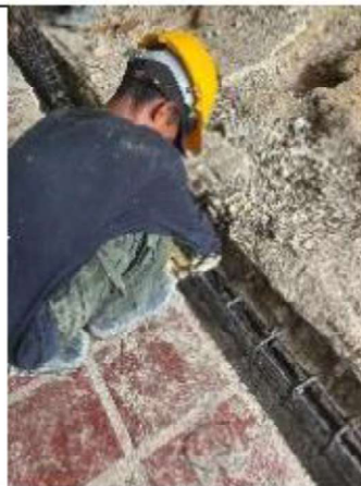
ITEM A3-6.22: Viga de cemento
