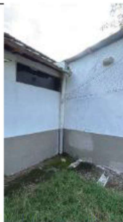
ITEM A3-11.21. Suministro e instalación de canal metálica
