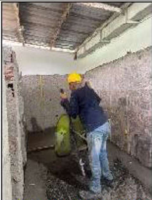
ITEM A3-12.04. Suministro e instalación de concreto Suministro e instalación de concreto 3000 PSI
