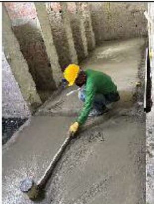
ITEM A3-12.04. Suministro e instalación de concreto Suministro e instalación de concreto 3000 PSI
