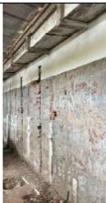
ITEM A3-1.36: Desmonte de pañete
