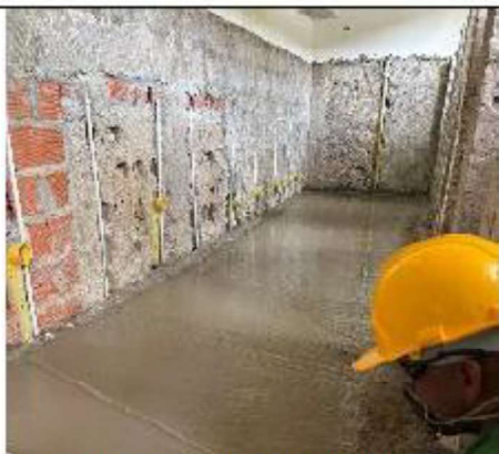
ITEM A3-12.04. Suministro e instalación de concreto Suministro e instalación de concreto 3000 PSI
