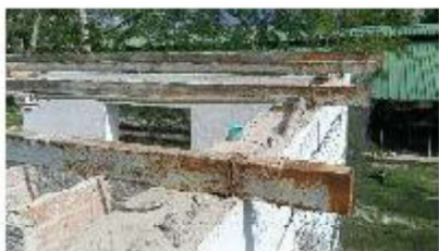
ITEM A3-1.16: Desmonte Cubierta en cualquier material
