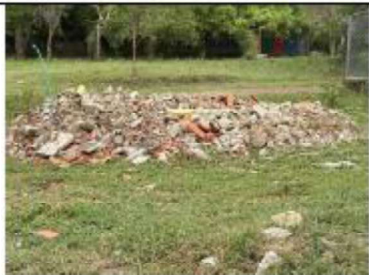
ITEM A3-17.02: Retiro de escombros
