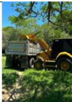
ITEM A3-17.02: Retiro de escombros
