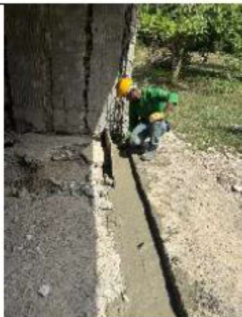
ITEM A3-6.22: Viga cimienta
