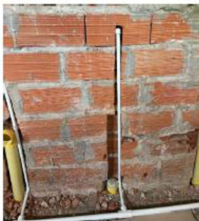
ITEM A3-1.36: Desmonte de pañete
