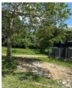
ITEM A3-17.02: Retiro de escombros
