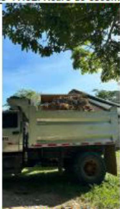
ITEM A3-17.02: Retiro de escombros
