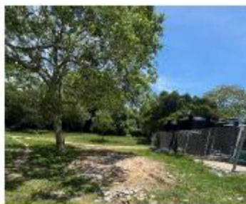
ITEM A3-17.02: Retiro de escombros
