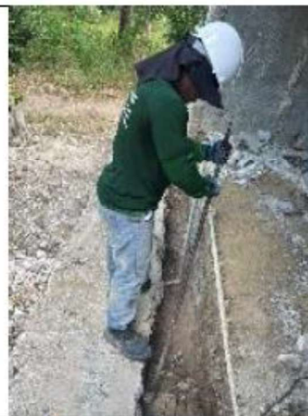
ITEM A3-1.05: Excavación manual
