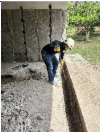
ITEM A3-1.05: Excavación manual
