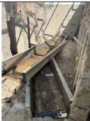
ITEM A3-1.40: Desmonte de canal y/o bajante en cualquier material
