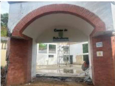
ITEM A3-1.09: Desmonte de muro en bloque
