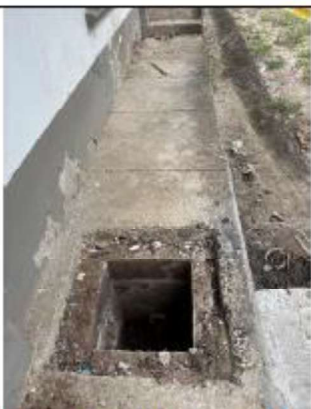
ITEM A3-1.12: Desmonte de placa maciza
