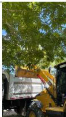
ITEM A3-17.02: Retiro de escombros
