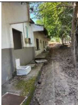
ITEM A3-1.12: Desmonte de placa maciza
