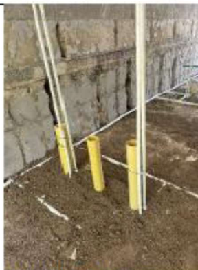
ITEM A3-3.13:Tubería sanitaria PVC 4"
