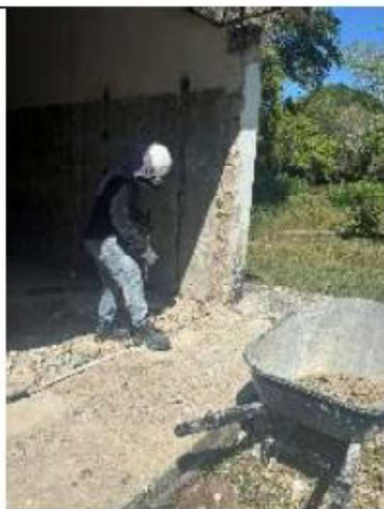
ITEM A3-1.05: Excavación manual
