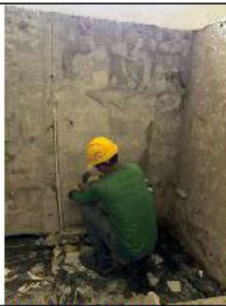
ITEM A3-1.36: Desmonte de pañete
