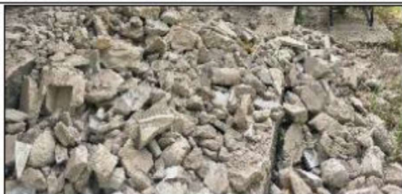
ITEM A3-17.02: Retiro de escombro
