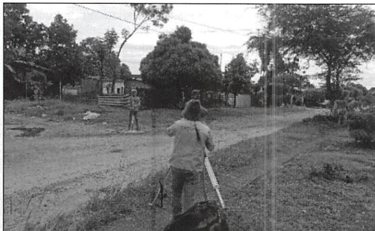
ESTADO ACTUAL CALLE 1ª
