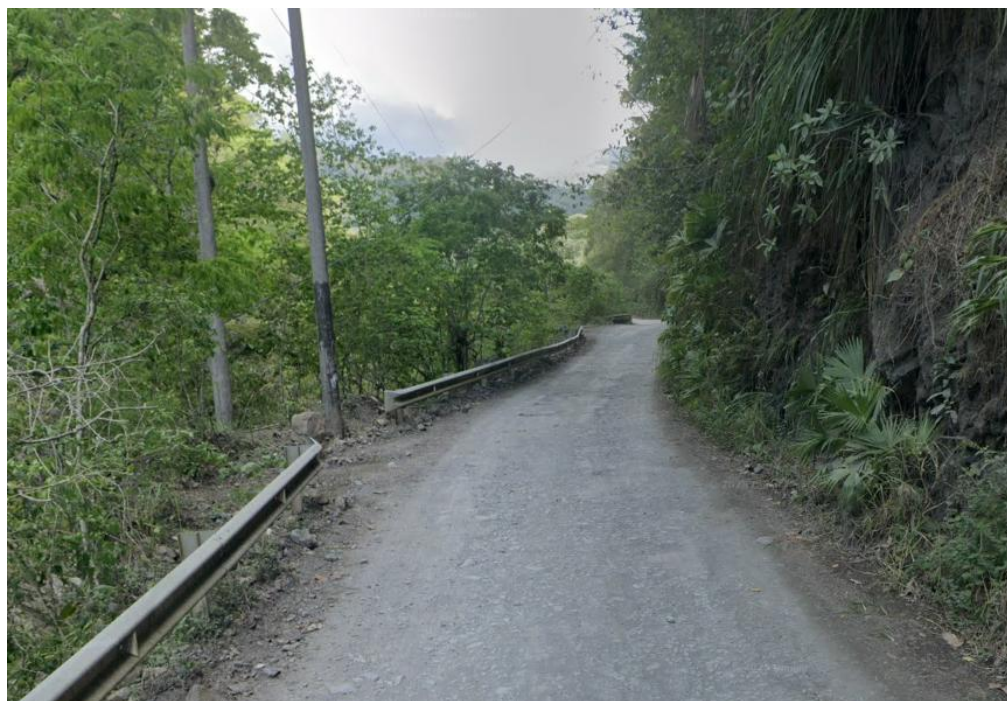
Fotografía 1. Sector de la vía en afirmado
