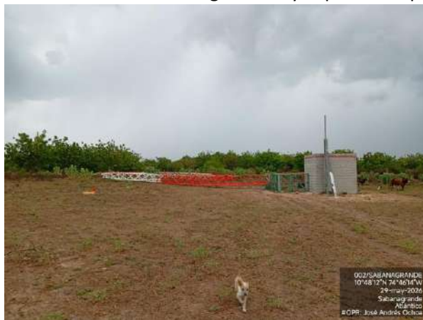
Registro fotográfico: torre AM colapsada — Estación 002 Sabanagrande, Atlántico (29/05/2026).
