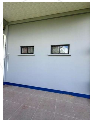
Ambiente interior con acabados finales
