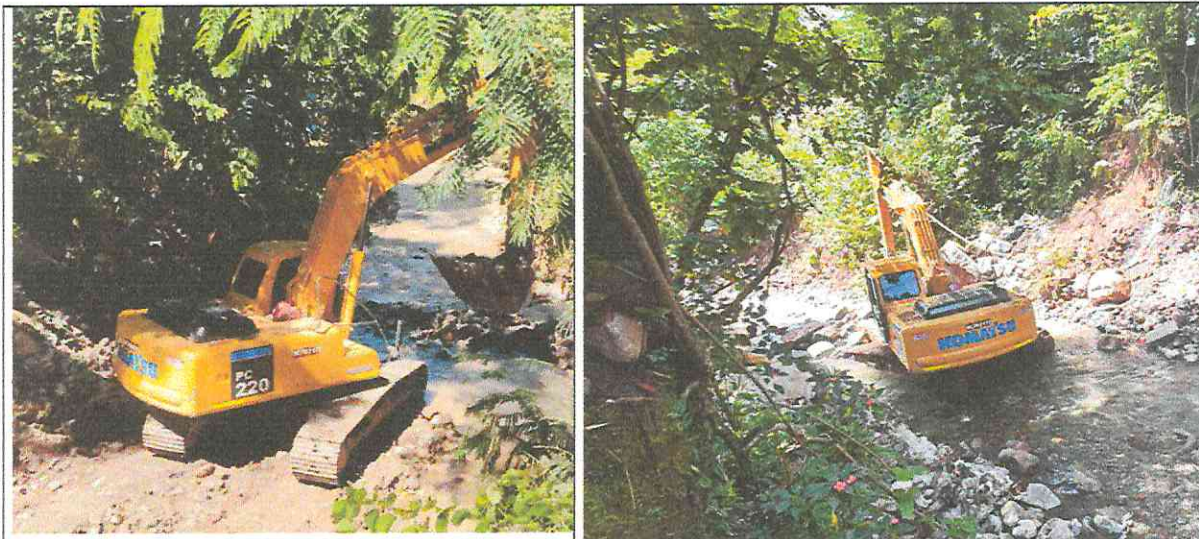
Canalización de Río sector puente Neil Armstrong sobre Caño Buque
