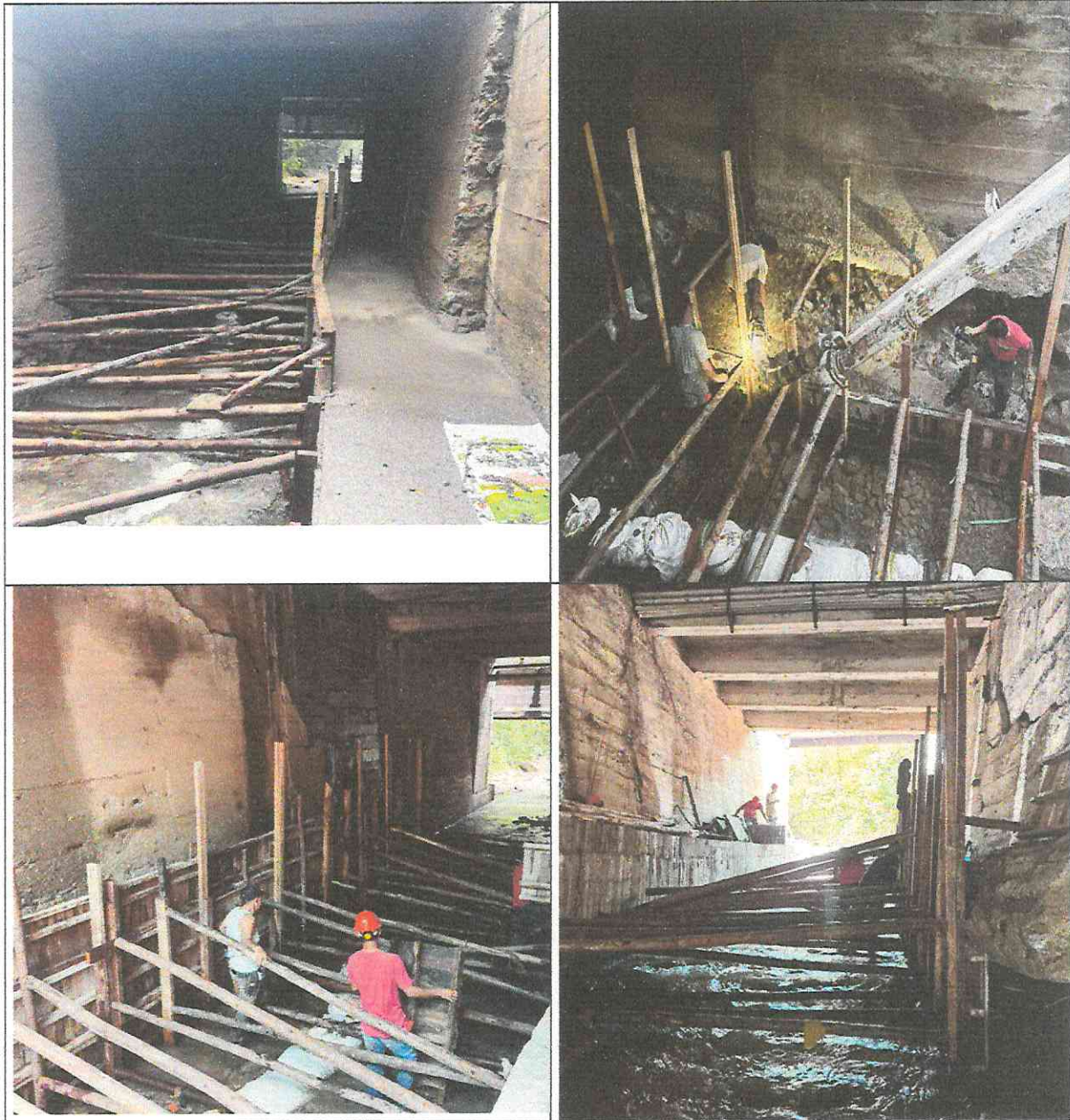
Concreto premezclado de 4000 PSI Sector Villacento - Caño Buque
