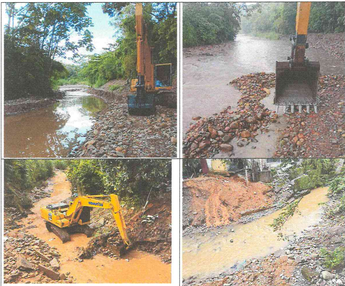
Canalización de Río sectores Cámbulos y La Rosita - Caño Buque
