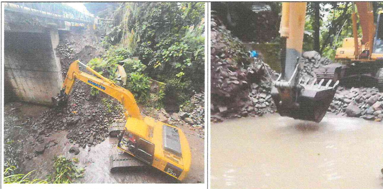
Excavación Mecánica Sector de Niel Armstrong – Caño Buque
