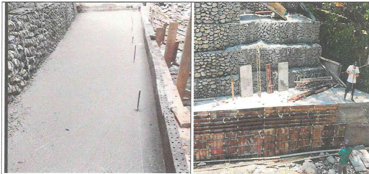
Concreto premezclado de 4000 PSI Sector Puente Neil Armstrong - Caño Buque
