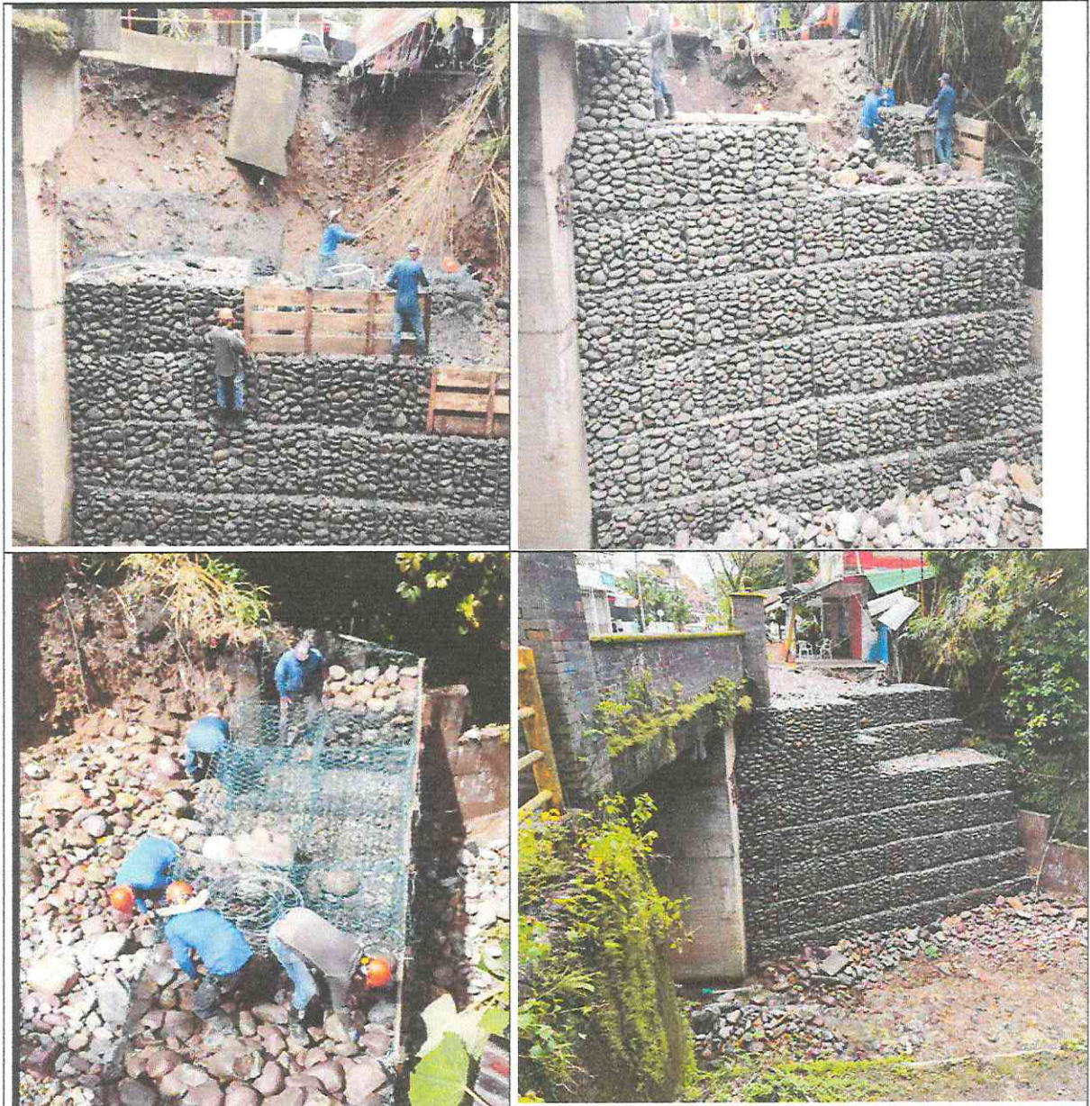
Construcción de gaviones en el sector de Niel Armstrong
