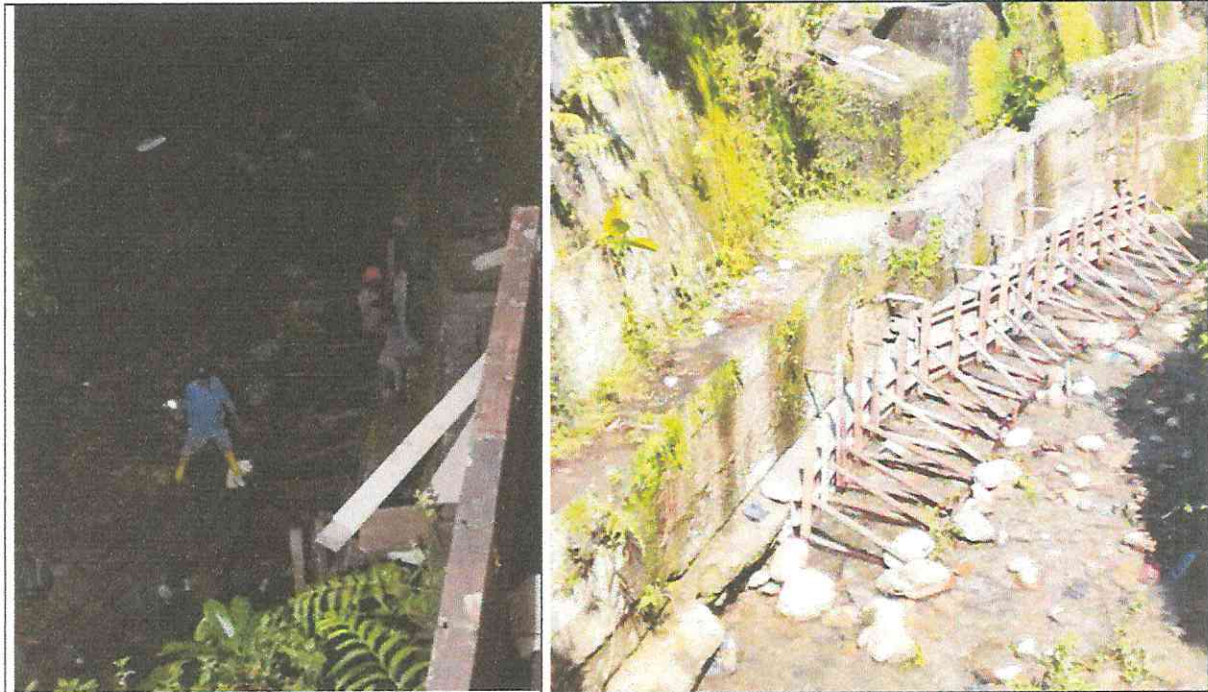
Concreto premezclado de 4000 PSI Sector Cámbulos - Caño Buque
