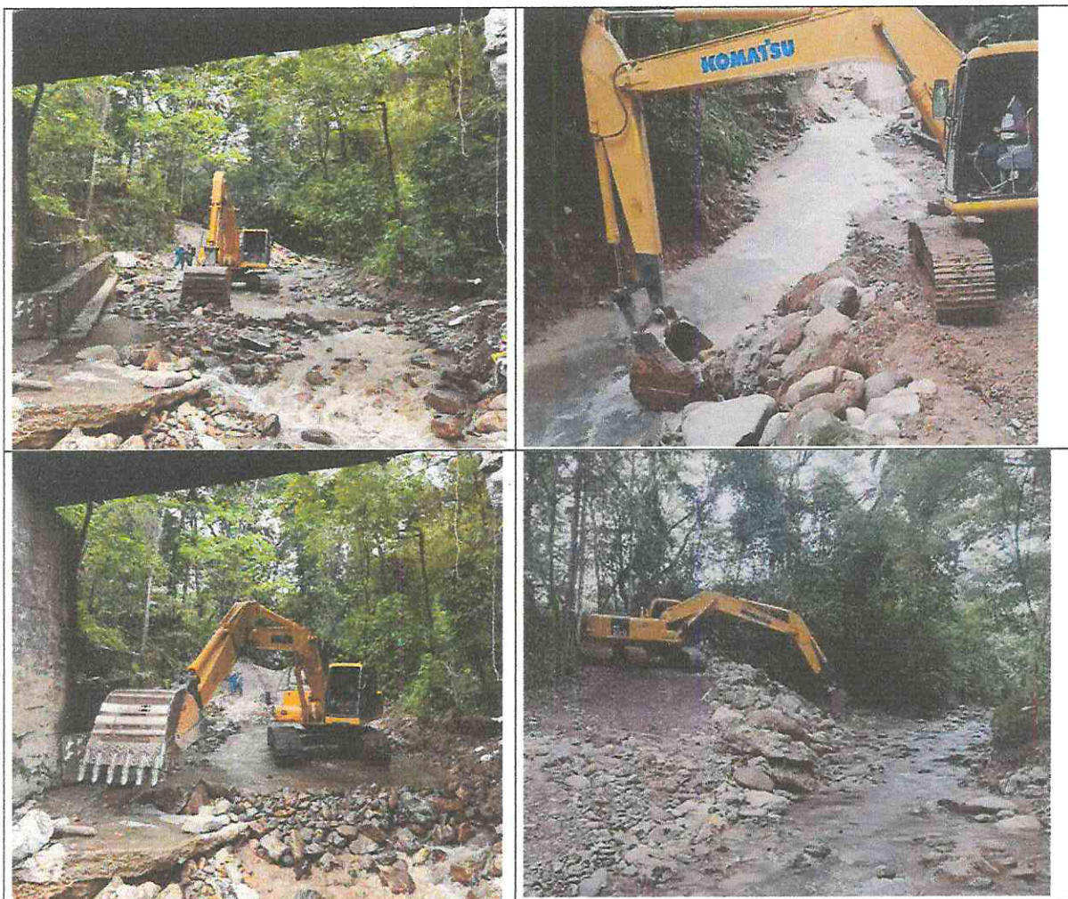
Canalización de Río sector puente villacentro sobre Caño Buque
