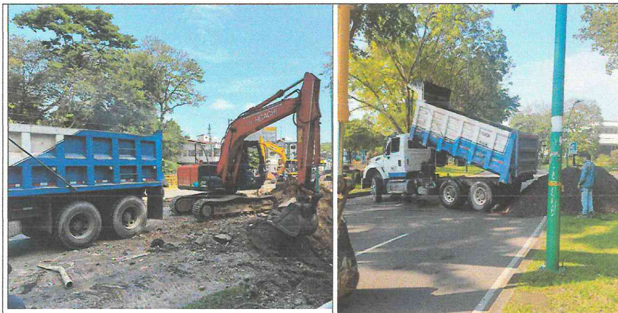
Transporte de material en los diferentes frentes de obras
