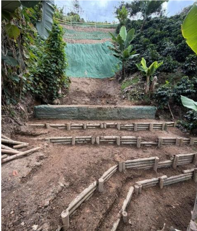
Muro vivo, filtro y terrazas en nacimiento.
