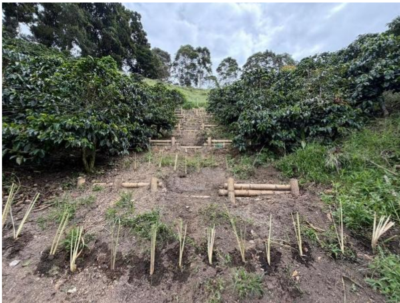
Trinchos con vertedero en drenaje natural y siembra de barreras transversales
