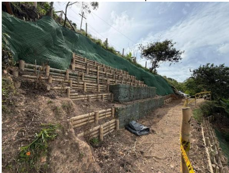
Intervención parte alta de la vía
