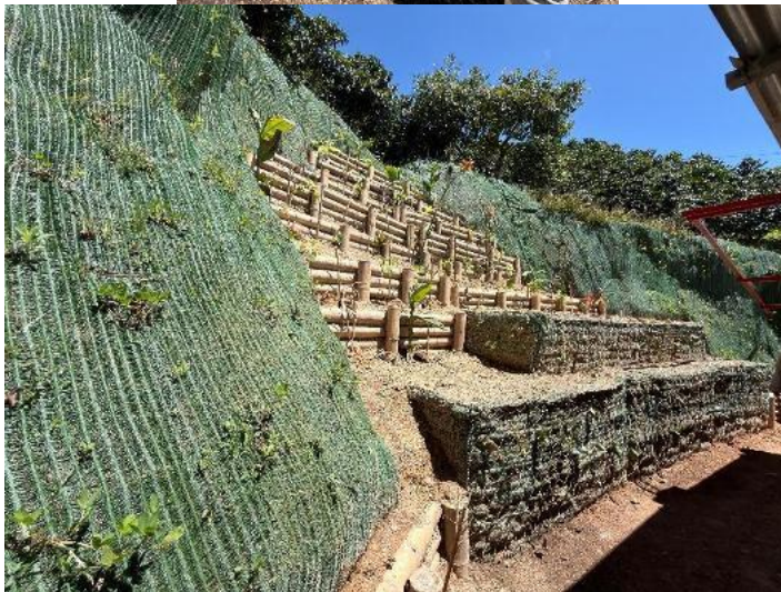
Siembras zona vivienda y drenaje natural.
