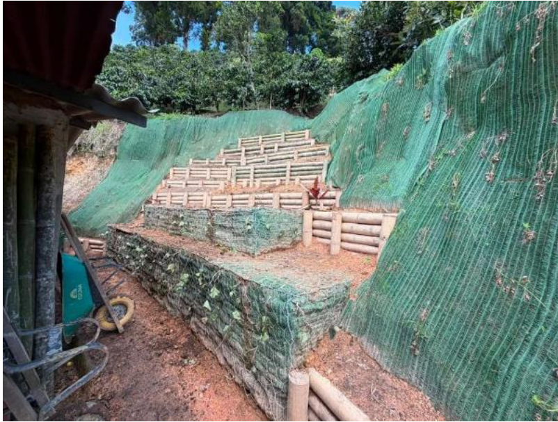
Intervención detrás de la vivienda en deslizamiento.
