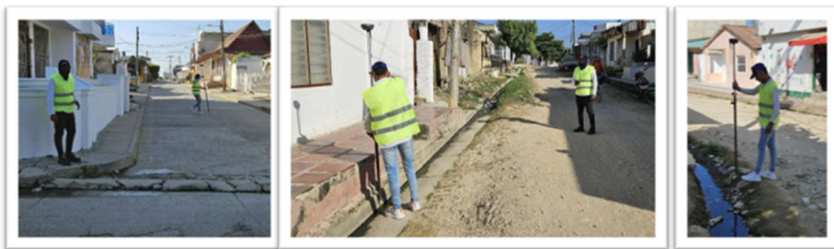
Figura 1. Estado actual de las vías Arjona, Bolívar.
