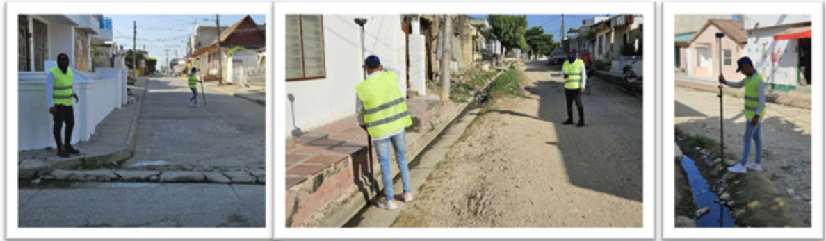
Figura 1. Estado actual de las vías Arjona, Bolívar.
