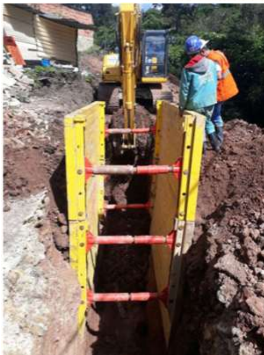
Figura 13. Método de instalación de entibado tipo cajón.
