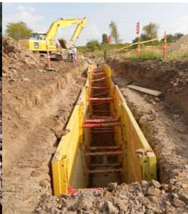
Figura 13. Método de instalación de entibado tipo cajón.
