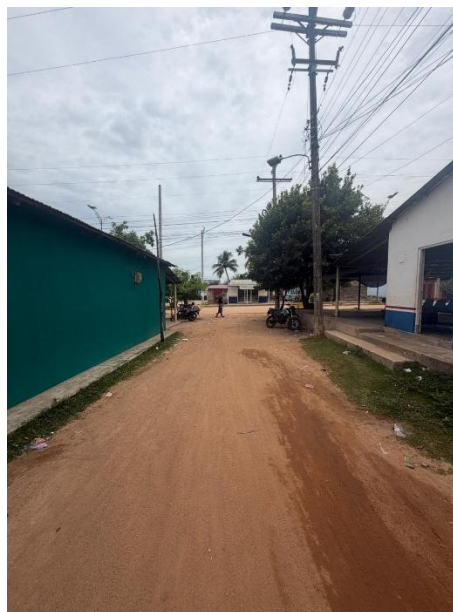
Foto 8. Intersección de calle 8B y carrera 4
