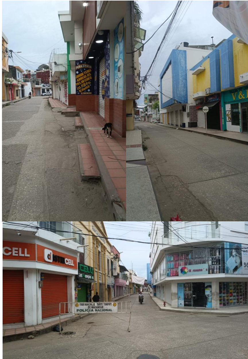
Foto 1. Estado actual del tramo a intervenir
