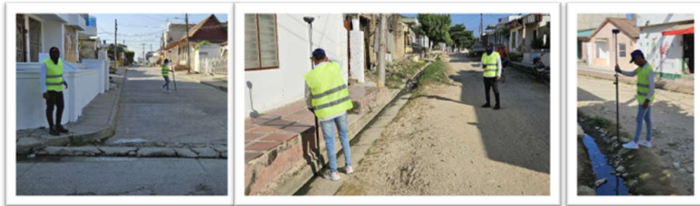
Figura 1. Estado actual de las vías Arjona, Bolívar.
