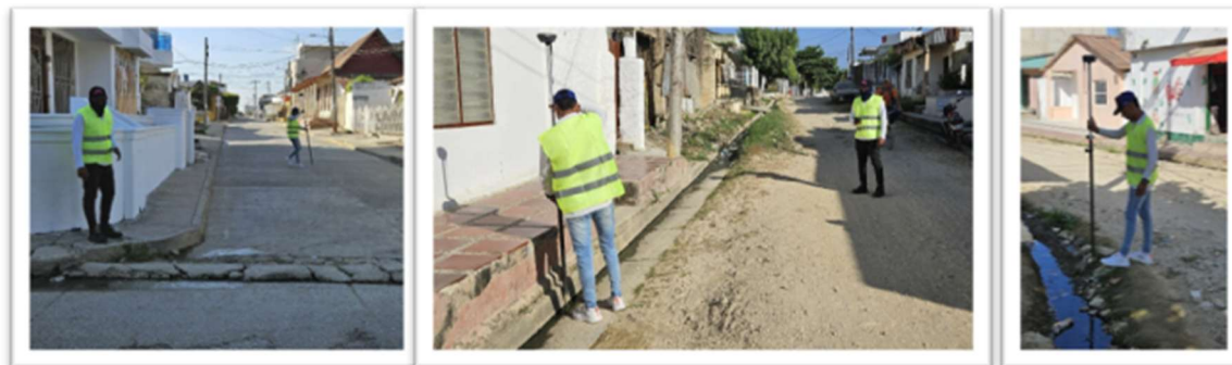
Figura 1 Estado actual de las vías Arjona, Bolívar..
