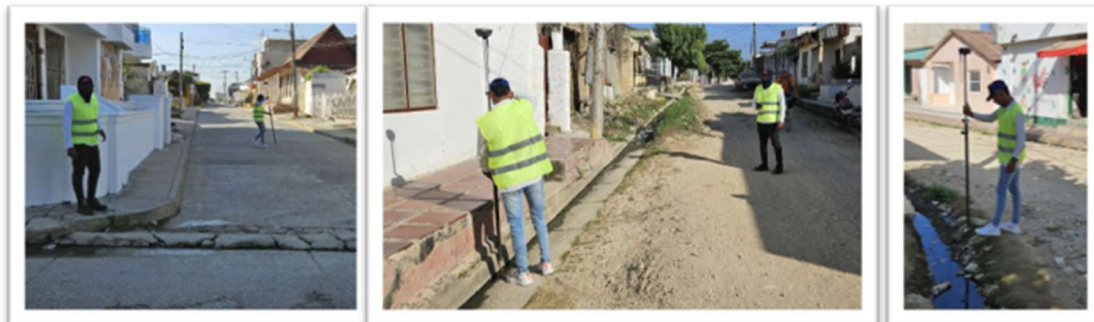
Figura 1. Estado actual de las vías Arjona, Bolívar.
