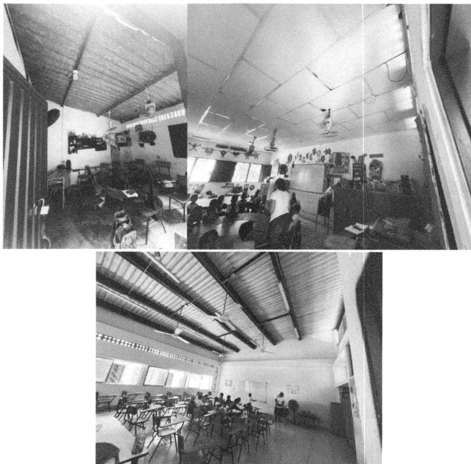
Ilustración 6. Cambio de cubierta de asbesto cemento, construcción de sistema eléctrico en general y construcción de cielo raso en drywall, incluye pintura general (todas las aulas)
