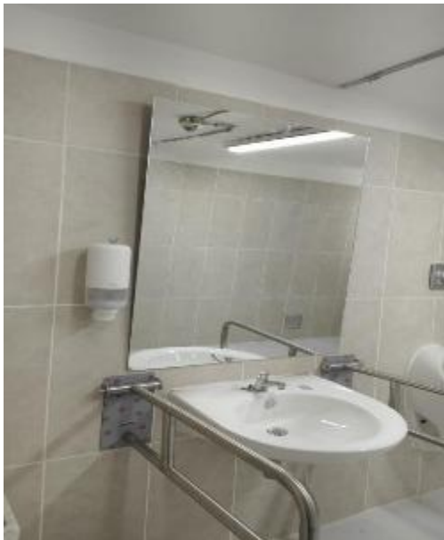
3.11 SUMINISTRO E INSTALACION DE CAMBIADOR DE PAÑALES /H
