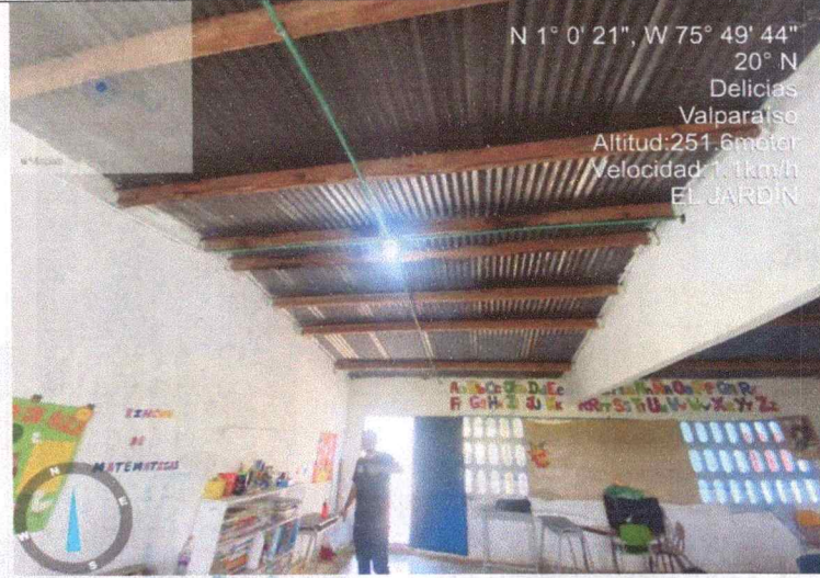
Imagen 9: cubierta de aula principal despues de la cuchilla
