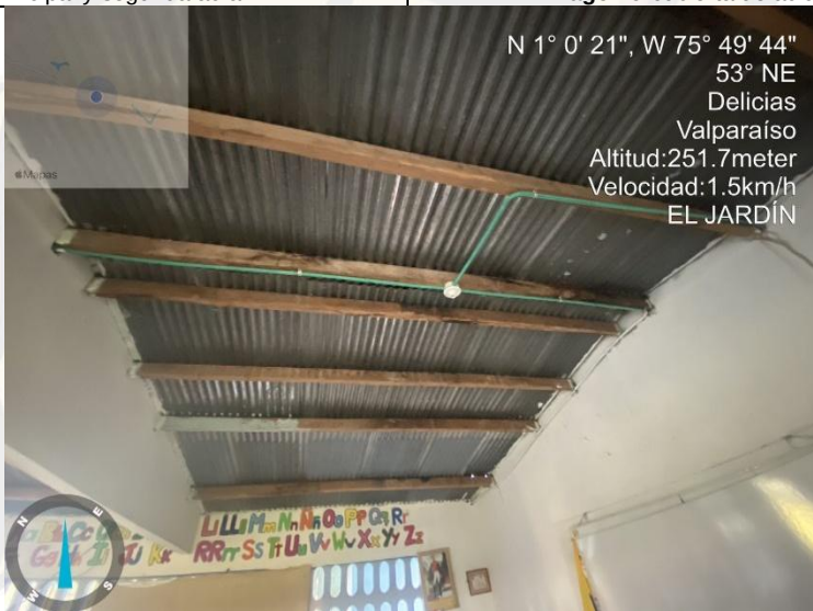
Imagen 10: cubierta principal antes de la cuchilla UNIDAD SANITARIA
