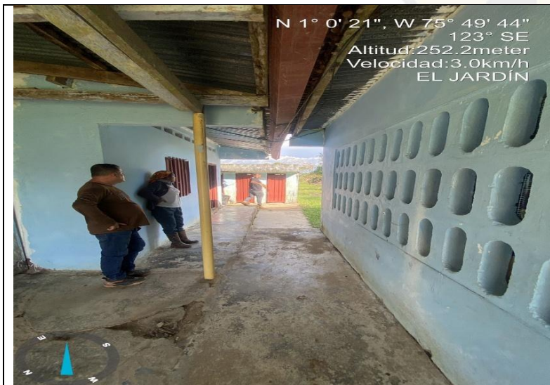
Imagen 8: pasillo entre aula principal y segunda aula
