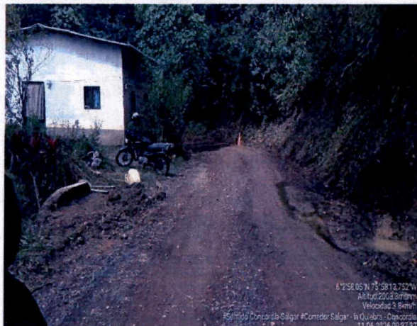
Foto 1. Inicio de actividades constructivas
