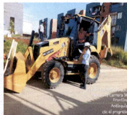
Inspección retroexcavadora - frente de trabajo Frontino
