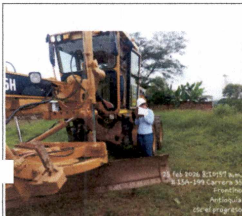
Inspección Motoniveladora - frente de trabajo de Frontino
