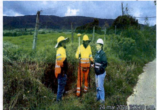
Foto 4. Verificación de uso de Epps y dotación
